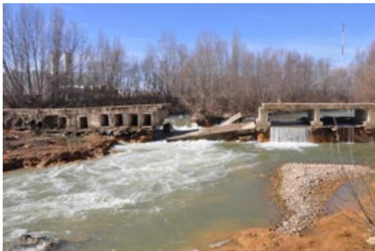
Figura 3. Colapso del puente en el río Bernesga causado por la incisión.
