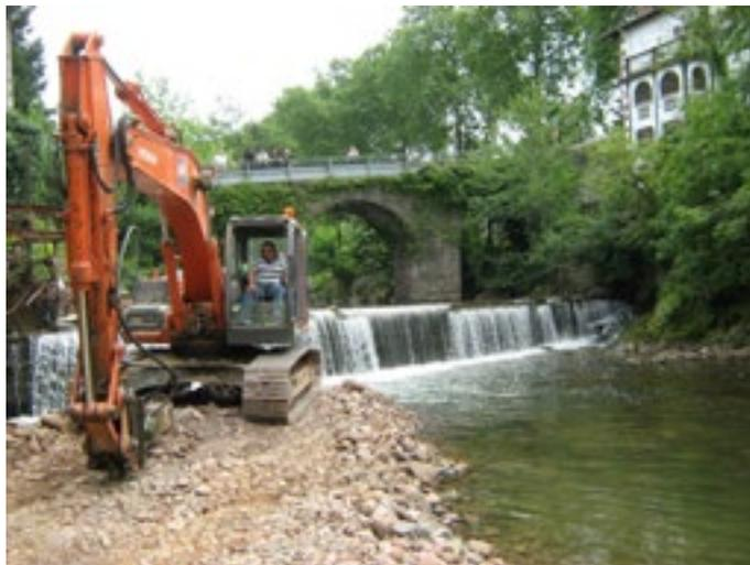
Figura 3. Obras de demolición del azud de Lekaroz (Fuente: CHC).
