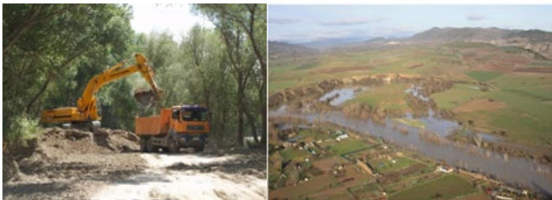
**Figura 4.** Ejemplos de actuaciones de restauración geomorfológica en el sistema Arga-Aragón, dirigidas a la eliminación o retranqueo de estructuras de defensa longitudinal y a la reconexión eco-hidrogeomorfológica del cauce con sus llanuras de inundación presentes o históricas (Fuente: Gobierno de Navarra y Elaboración propia).
