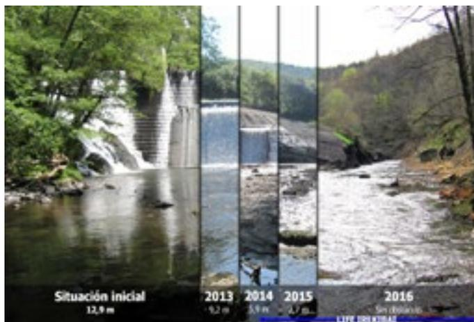
Figura 4. Obra de demolición por fases. Fuente: URA
