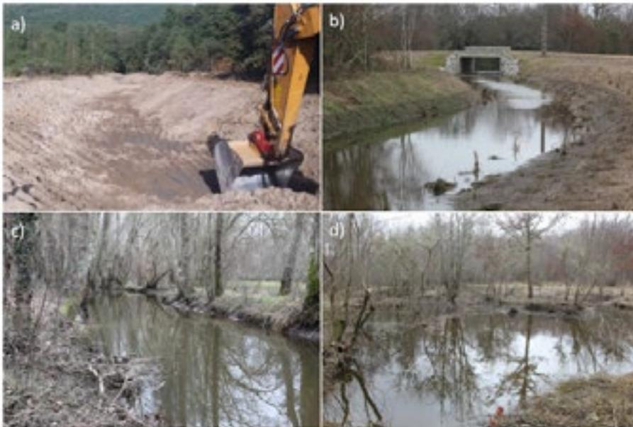
Figura 5. Fotos de ejecución de rehabilitación y estado final del río Limia en Ponteliñares – Rairiz de Veiga. a) Excavación para la apertura del cauce; b) Estado final de obra de entrada al cauce; c) Estado final del cauce rehabilitado; d) Formación de humedal en cauce rehabilitado.
