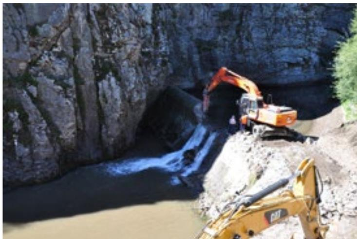
Figura 4. Ejecución de las obras de demolición del azud de la Gotera en el río Bernesga.
