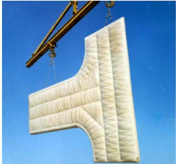
Figura 9. Colocación de pieza de hormigón flexible del Hotel Tres Islas, 1973, Archivo de la Fundación Miguel Fisac, AFF-274
