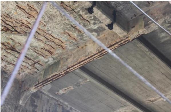
FIGURA 4. Daños en el interior, pérdida de recubrimiento.
