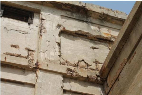
FIGURA 3. Daños generalizados por ambiente agresivo (exterior)
