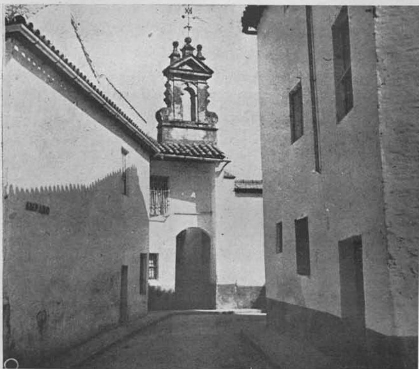
(Fig. 2). Hospital de la Lámpara. Al fondo la espadaña-campanario
