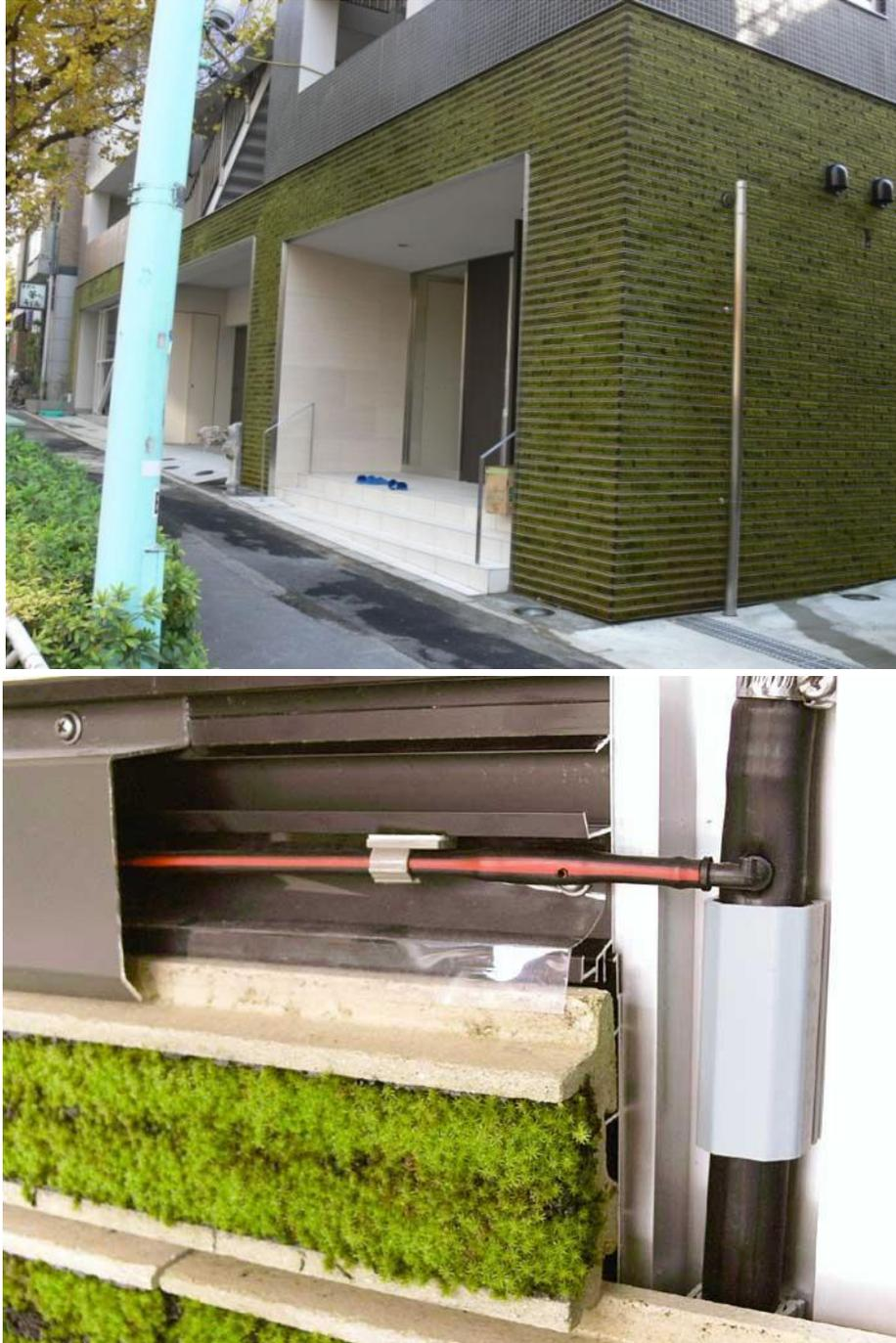
**Figura 2.** *Geomoss*: aspecto de una fachada (arriba) y detalle constructivo de la parte superior, donde se observan la subestructura de soporte, el sistema de riego y los módulos de cerámica cubiertos por musgo del género *Racomitrium* (abajo).
