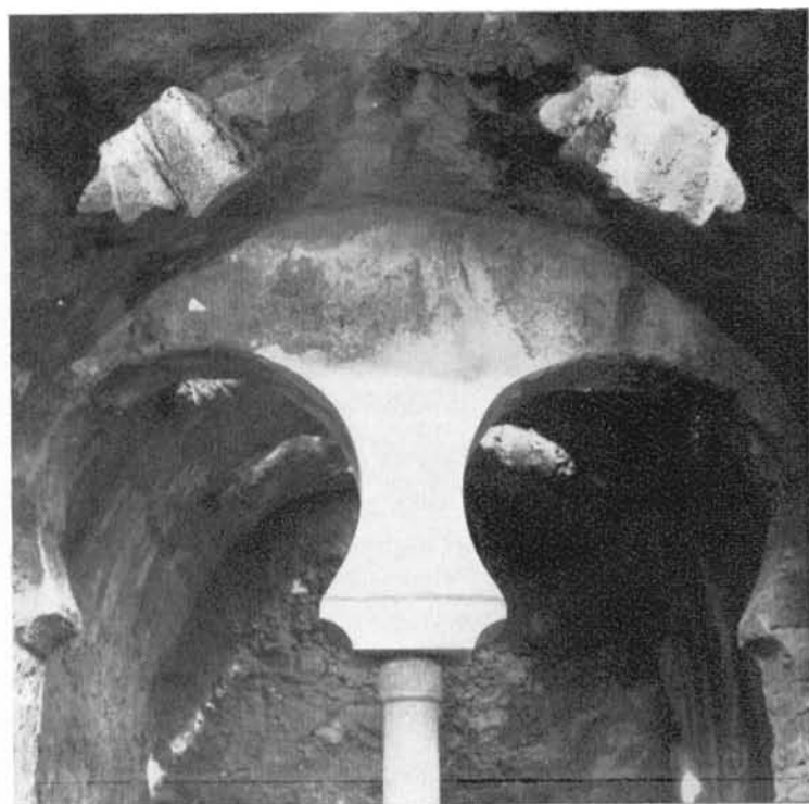
Una de las dependencias destinadas al baño de vapor o "al bayt al-voasla ni" de los baños del Alcázar Califal.
