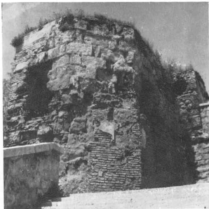
Torre del baño, nombrada también Torre de las Arcas, sobre la muralla, frente al Alcázar de los Reyes Cristianos.
