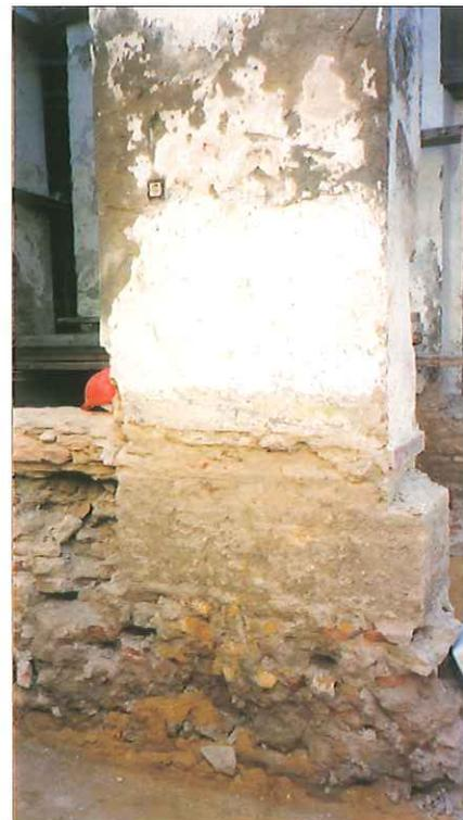
Foto 1: Se diferencian dos zonas fundamentales: 60 cms de zanja constituida por fábrica de ladrillo, con aparejo definido y una capa inferior resuelta con ladrillos y tierra con cal compactada.
