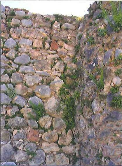
**Foto 3:** Grieta en el muro de fachada y la torre sur
