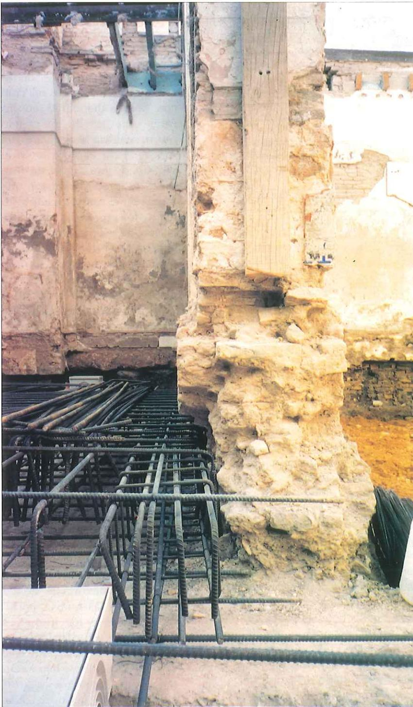
Foto 6: En la fotografía se pueden apreciar dos fases distintas; la zona izquierda está preparada para hormigonar mientras que la derecha está en los trabajos de compactación. También se observan las regolas abiertas en los muros medianeros.
