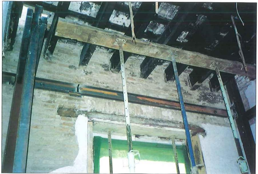
Foto 3: Apuntalamiento de las vigas de madera y de los cargaderos de huecos de ventanas
