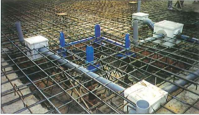
Foto 7: Afección de la losa de cimentación por las instalaciones de alcantarillado y montaje de la grúa.
