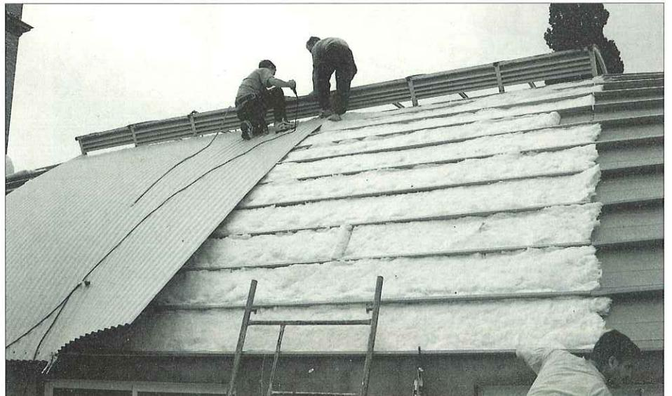
Ejecución de la cubrición, en la que se refleja las bandejas inferiores, totalmente colocadas, el aislamiento y las planchas superiores en fase de montaje.
