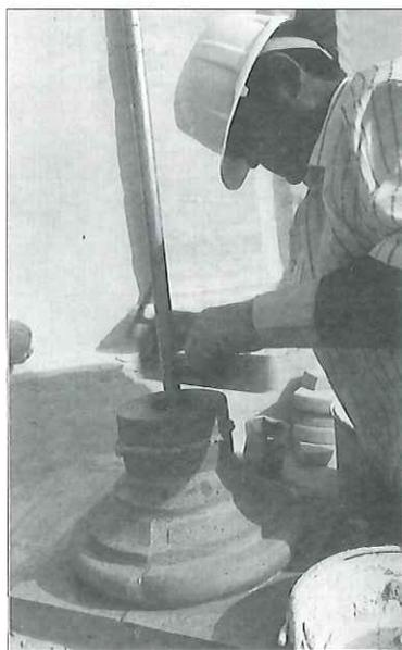
Proceso de reconstrucción de los jarrones, en el que se aprecia la colocación del vástago de acero inoxidable.
