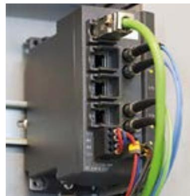
Figura 1. Los conmutadores Ethernet controlan el acceso a la red para limitar la congestión y mantener el rendimiento. (Fuente de la imagen: Amphenol)
