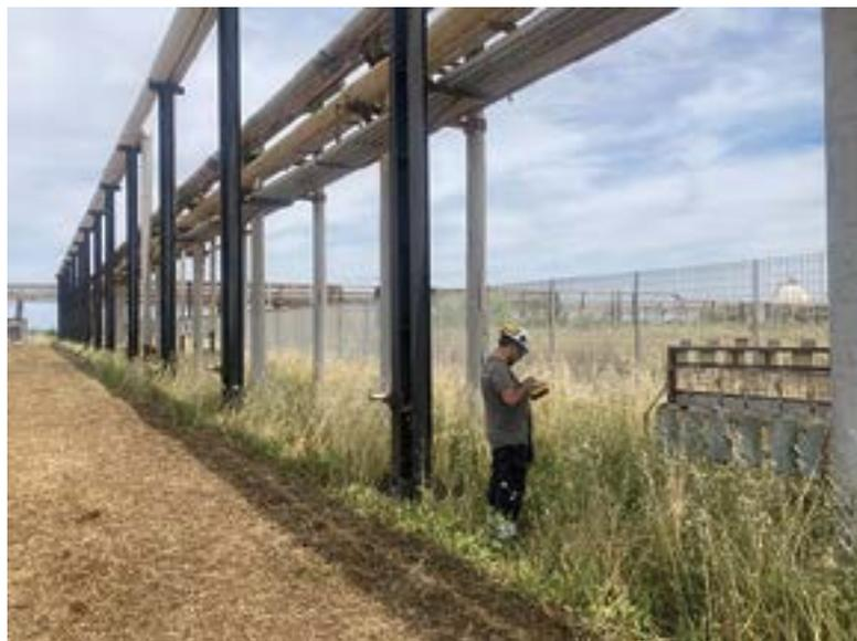
interconexión. Por eso, en lugar de aplicar un método reactivo a la toma de medidas preferimos un planteamiento preventivo. Sin embargo, para nosotros resulta muy complicado comprobar 5km de conductos, de ahí que pidiéramos a Intero - The Sniffers que lo hiciera recurriendo a los mejores instrumentos que tuvieran a su disposición. La cámara acústica de precisión de Fluke resultó ser ideal”.
