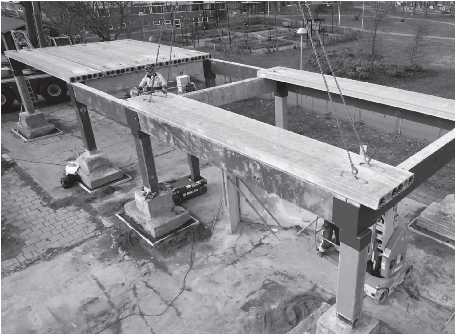
Construcción del piloto sueco con elementos reutilizados de tres donantes diferentes. / Construction of the Swedish pilot with reused elements from three different donors.
