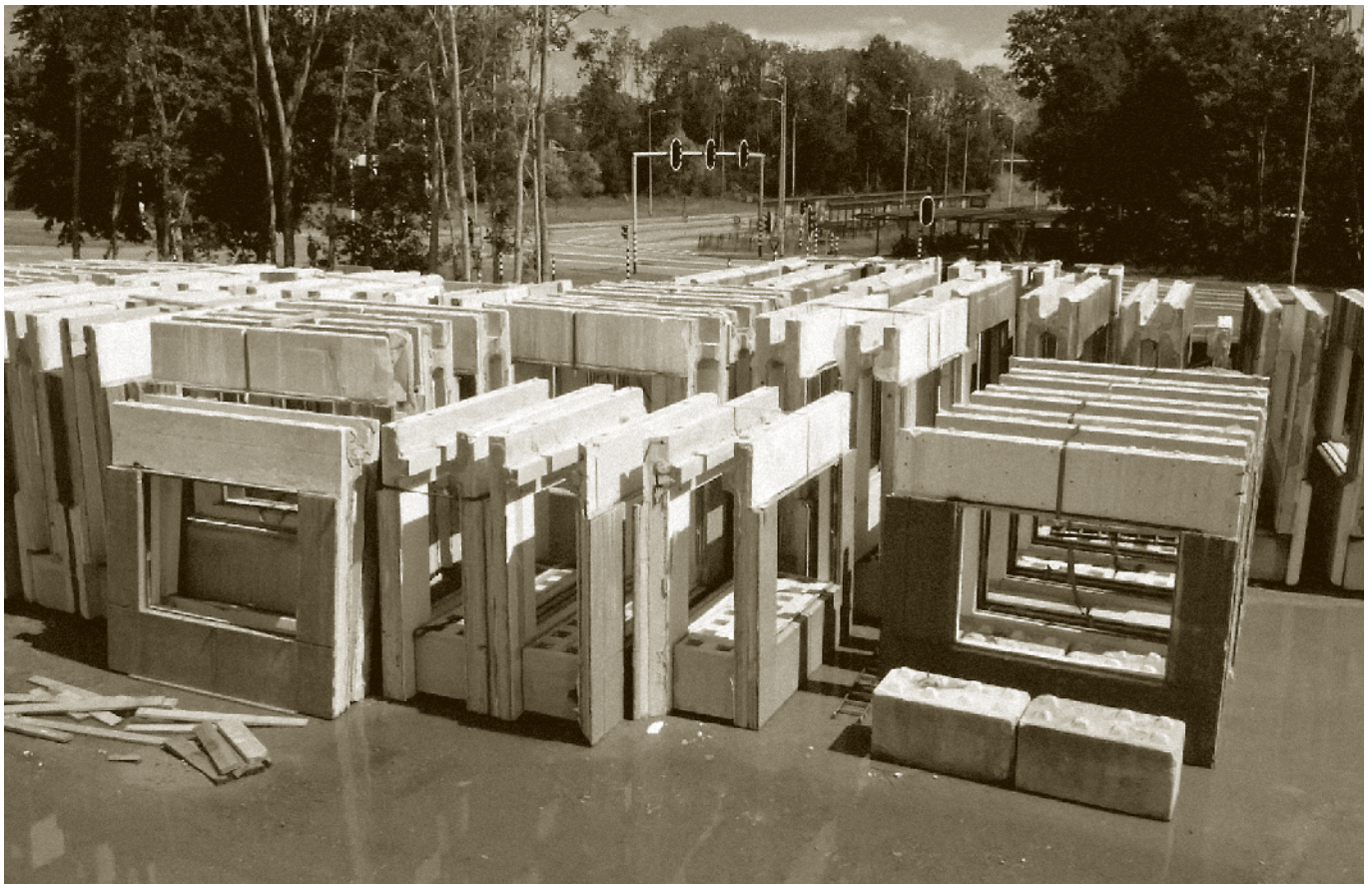
Elementos de hormigón deconstruidos del edificio donante holandés. / Concrete elements deconstructed from the Dutch donor building.
