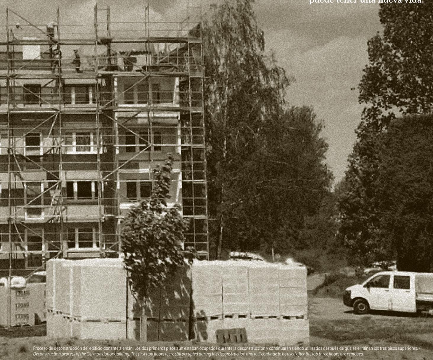
Proceso de deconstrucción del edificio donante alemán. Los dos primeros pisos aún estaban ocupados durante la deconstrucción y continuarán siendo utilizados después de que se eliminen los tres pisos superiores. /
