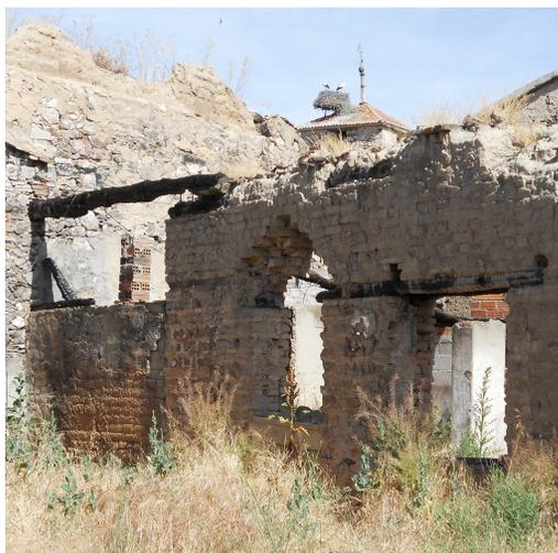
Figura 7. Mecanismos de fallo estructural en construcciones de adobe. 7a: Giro de una fachada por empuje de la cubierta. Santiago de la Puebla, Salamanca. Fuente: Javier Gómez. 7b: Fallo estructural por apertura de un hueco en Lagunilla de la Vega, Palencia. Fuente: Fernando Vegas y Camilla Mileto.
