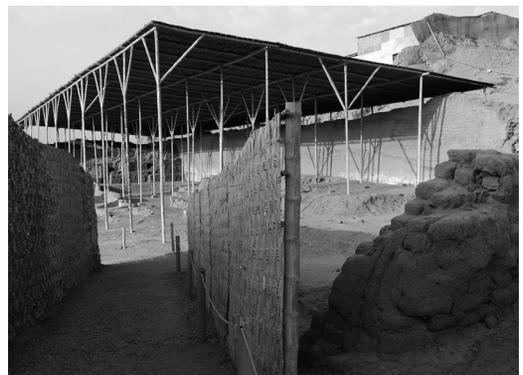
Figuras 13 y 14. Las cubiertas ligeras de materiales naturales como las bambusas utilizadas en las Huacas de Moche en Perú, sigue siendo una alternativa válida, pero es necesario cuidar su diseño para incrementar su vida útil, así como su resistencia ante los factores naturales. Fuente: Luis. Guerrero
