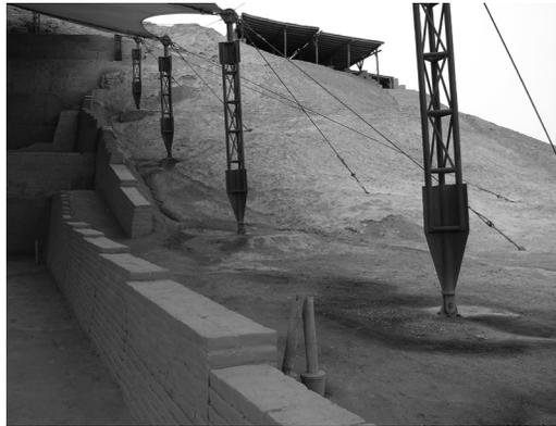
Figuras 8 y 9. El diseño de los apoyos es uno de los elementos primordiales a considerar. Entre más superficie se cubre más apoyo se requiere, ya sea en número de columnas a incorporar o en el área de contacto de la cimentación, factores que deben ser bien evaluados en la toma de decisiones del diseño de este tipo de soluciones. Fuente: Luis Guerrero
