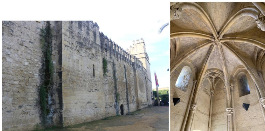
Figura 11: Fachada septentrional del alcázar de los Reyes Cristianos y bóveda interior de la torre de los Leones (Fotos del autor)
