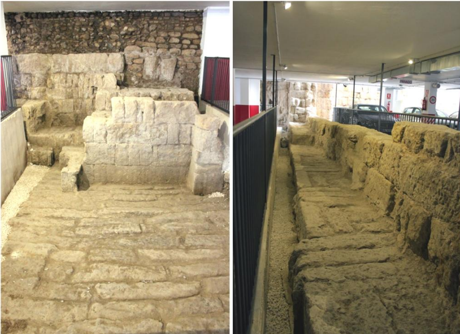
Figura 8: Muralla norte del alcázar califal, integrada en el Parking la Mezquita de Córdoba
