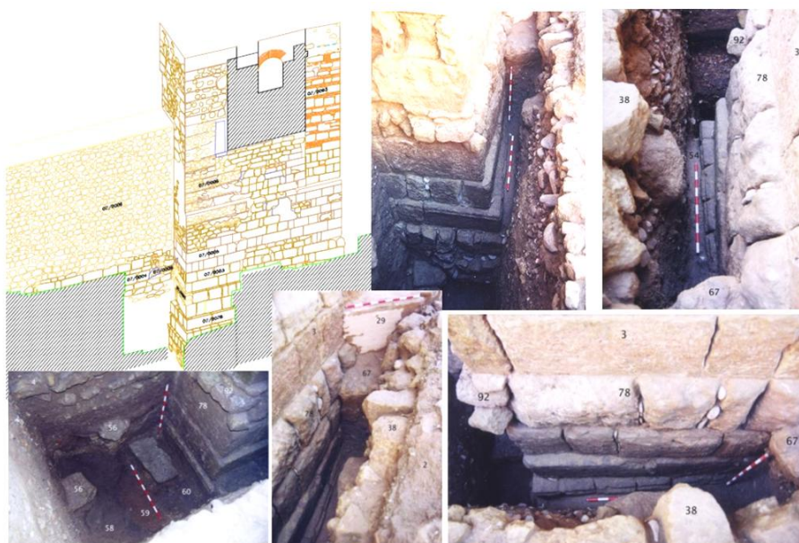
Fig. 11. Corte 7. Cimentación del pilar
