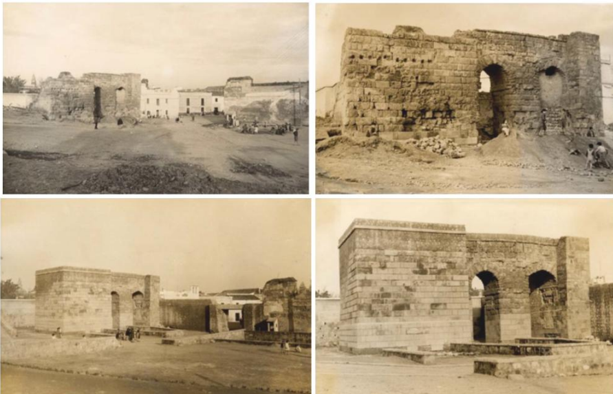
Fig. 18. Estado previo y trabajos de restauración de la Puerta de Sevilla y la torre albarrana
