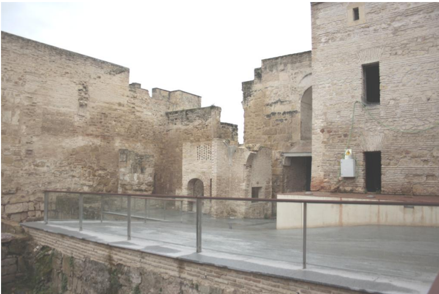
Vista de cuerpo de taquillas y pavimentación en el Patio de Mujeres
