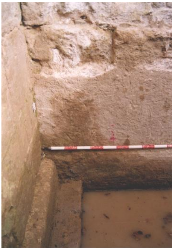
Fig. 10. Corte 4, se observa la cimentación de la muralla formada por un zampeado de sillarejos unidos con mortero de cal. E.T. Murallas de Córdoba II (GMU)
