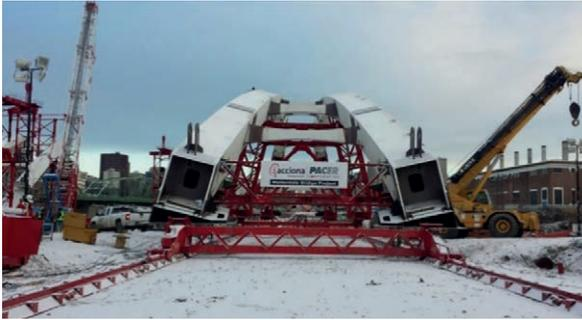
Figura 5. Camino de rodadura y patines de deslizamiento.
