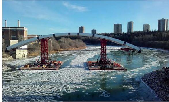
Figura 7. Navegación del arco central.
