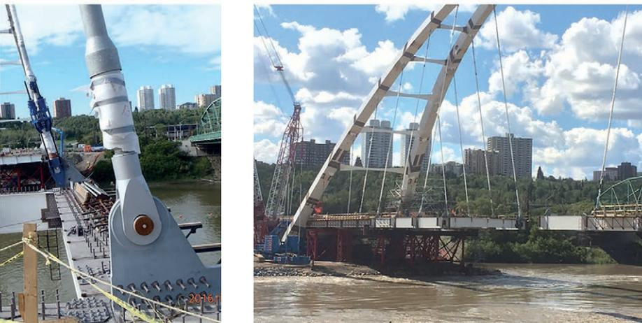
Figura 13. Sistema de colocación de péndolas y montaje de tablero por voladizos.
