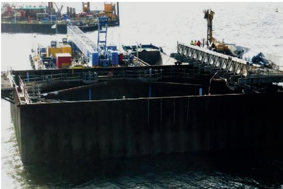
Figura 15. Vista de la Pila N1 con plataforma para ejecutar los pozos.
