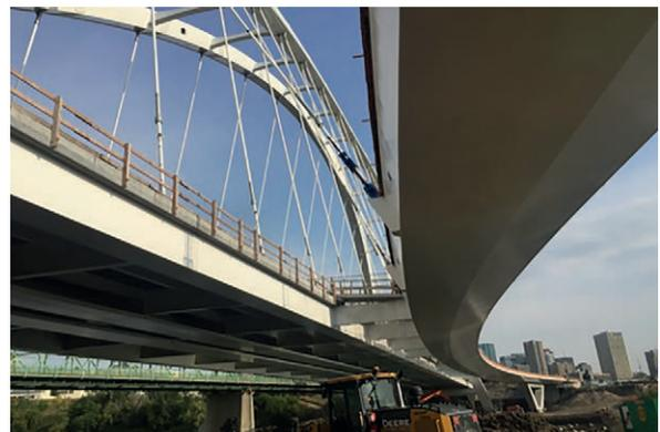
Después, unas grúas de alta capacidad levantaron los tramos de la pasarela sobre el río y los colocaron en su lugar. Las extensiones de las vigas, las péndolas y el empalme con la estructura previamente instalada se llevaron a cabo antes de soltar los segmentos de la grúa, al final de cada izado.
