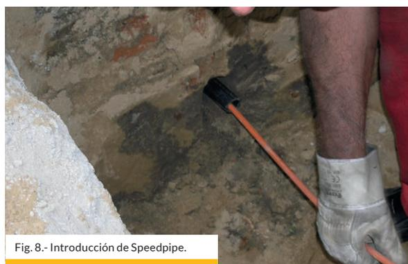
Fig. 8.- Introducción de Speedpipe.
