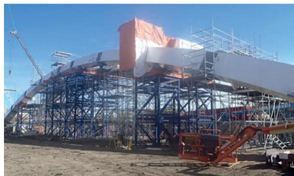
Figura 3. Montaje del arco central sobre castilletes provisionales (azul).
