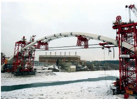
Figura 10. Izado del primer tramo del arco.
