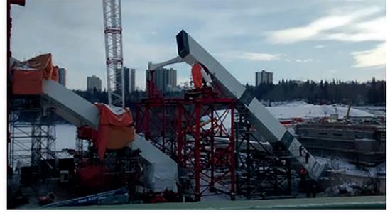
Figura 9. Premontaje de dovelas en los extremos de las bermas.
