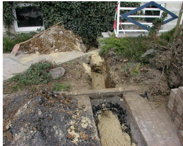
Fig. 4.- Instalación mediante procedimiento con apertura.
