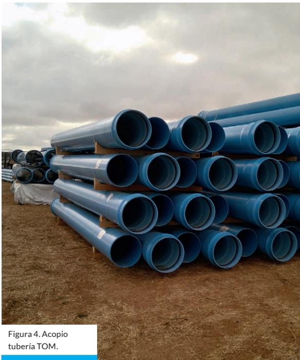
Figura 4. Acopio tubería TOM.
