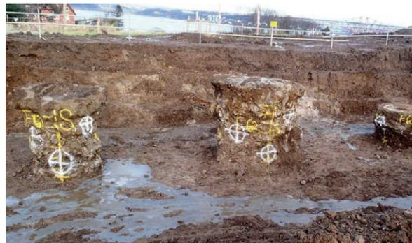
Figura 7. Campo de pruebas para el jet grouting.
