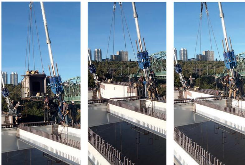
Figura 15. Montaje de tablero por voladizos.
