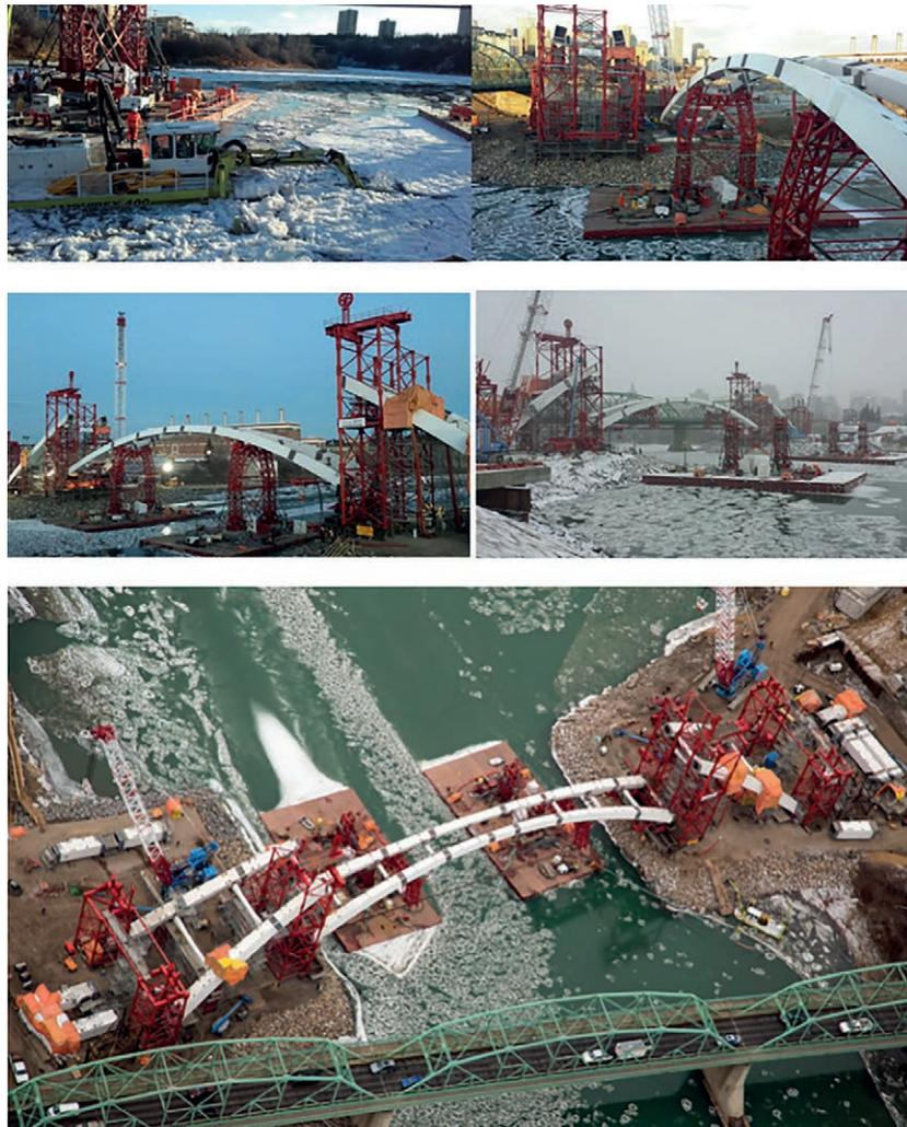
Figura 8. Rotura de hielo en el río y llegada del arco a su posición.
