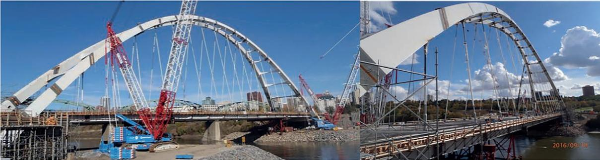
Figura 17. Estructura de arco y tablero metálico completo con las péndolas ya ajustadas.
