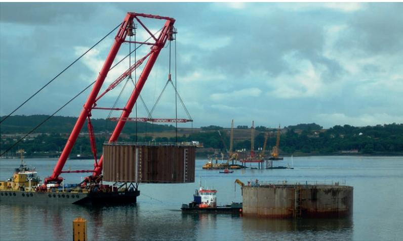
Figura 5. Instalación del cajón provisional.
