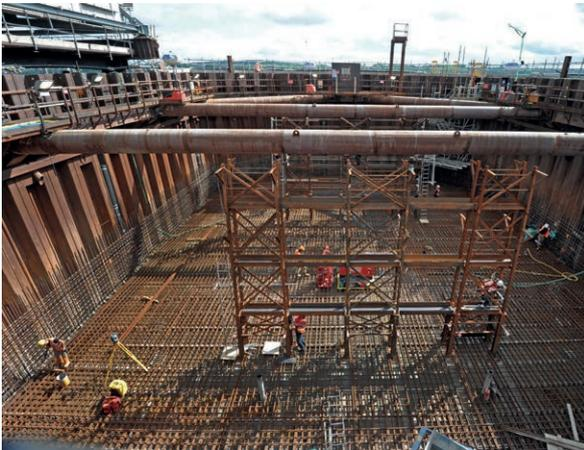
Figura 12. Ferrallado de la cimentación de la Torre Central.
