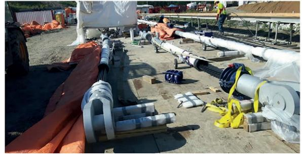
Figura 14. Corte y montaje de péndolas.
