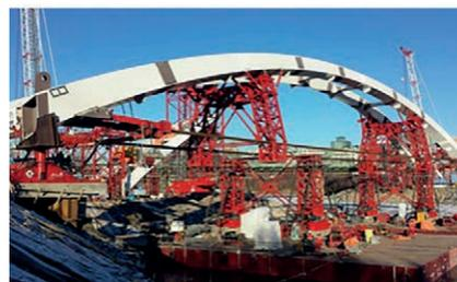
Figura 6. Lanzamiento del arco central.
