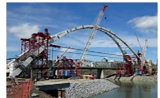
Figura 11. Izado del segundo tramo del arco.
