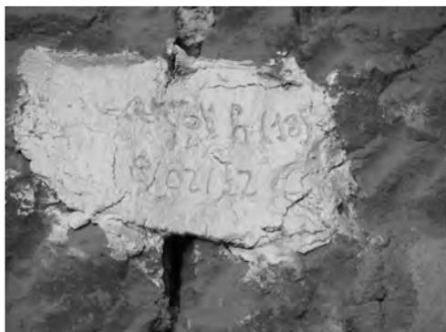
Figura 161. Deterioro de un testigo por retracción.
