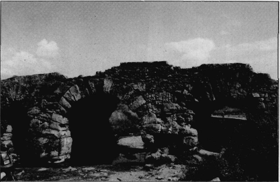
Lám. 4. (Puente n.17) Vista del puente aguas arriba; obsérvese la diversa factura de cada uno de los arcos.
