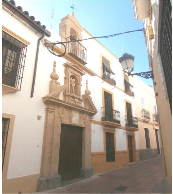
Fachada de la ermita de S. Zoilo de Córdoba
