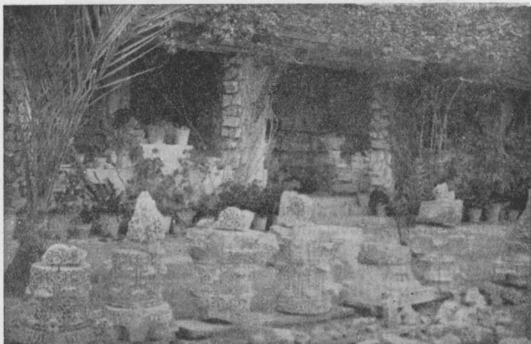
Capiteles de Dar-al-mulk, que ya han sido colocados en la restauración de este aposento hacia 1954.
