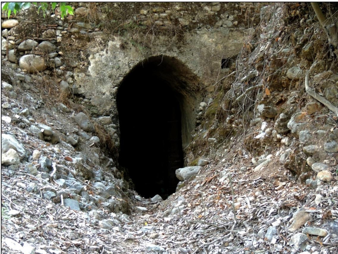
**Figura 7:** Estado actual del cárcavo del molino hidráulico de Ballenato
