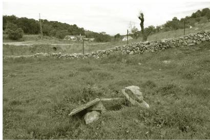
**Fig. 29.** Detalle, en primer plano, de la situación de la arqueta por la que se accede a la galería o acueducto de Cúriga
