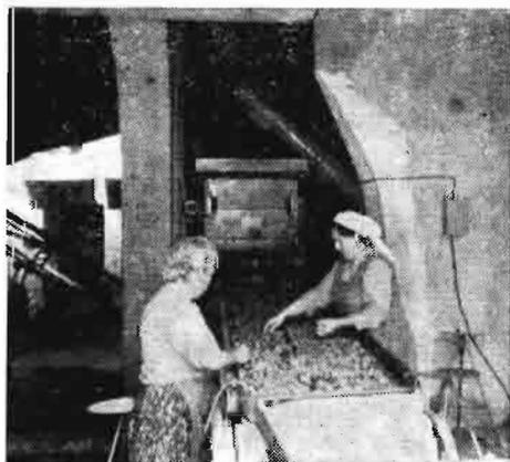
Foto 4. Tornillo sin fin, máquina peladora y mesa de selección
