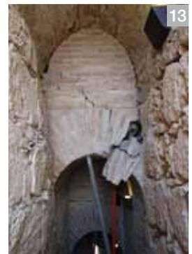
**Lámina 11.** Con una grúa móvil se empezó a eliminar el material suelto de toda la cubierta, mientras se acopiaban los sillares de piedra.
