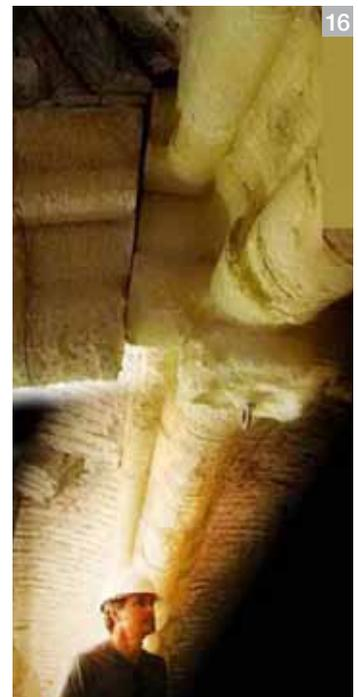
En el caso en los que existe desplazamiento entre dovelas, se comprueba que, la compresión media de contacto es admisible para la piedra caliza con la que están hechas (Lám. 17-20, Fig. 6 y 7).
