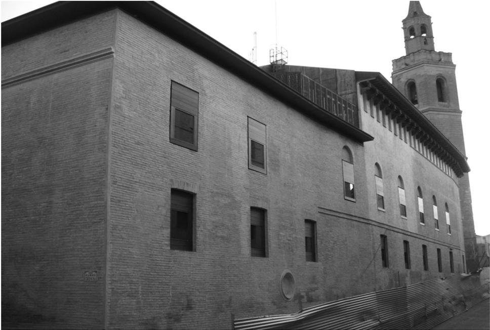
*Figura 11. Fachada del edificio a la calle del Palacio. En ella se han suprimido algunos vanos y se ha reducido el tamaño de los restantes para disminuir la entrada de luz en las salas del Museo.*
