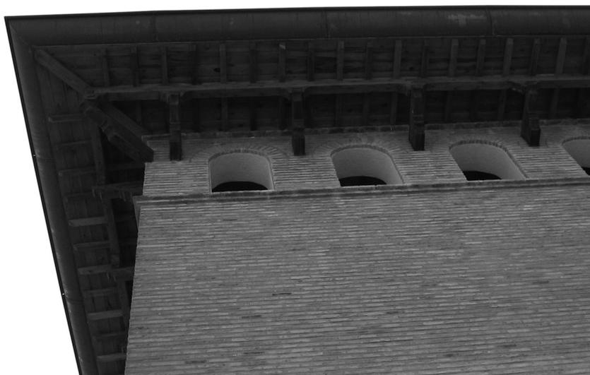
*Figura 7. Aspecto de la esquina del Palacio en la que se aprecian el detalle de la fachada, la galería de arquillos y el alero de madera restaurados.*
