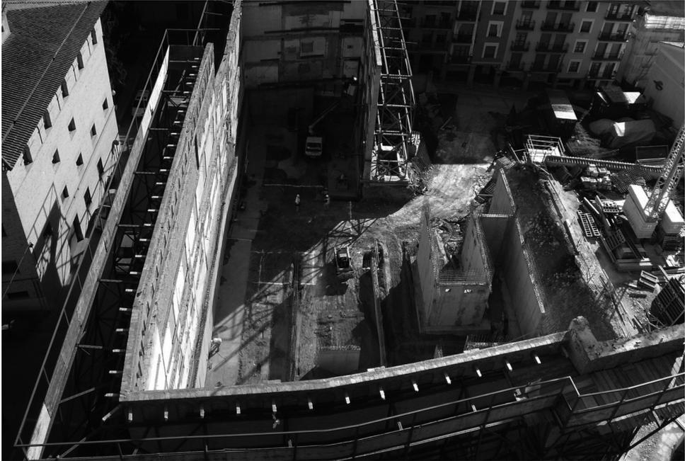
*Figura 13. Aspecto de una fase de las obras en el Palacio episcopal en que se aprecia el edificio vaciado en su interior y la estructura para sujeción de la fachada. (Fotografía cedida por María Lalaguna).*
