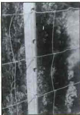
En la realización del cerramiento de fincas dedicadas al pastoreo de ganado se combinan dos tipos de materiales: el poste de soporte tipo S + B y la malla metálica anudada y alambre de espino.
