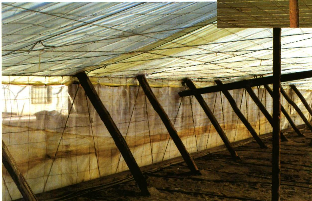
Soportes perimetrales de invernadero tipo 'Almería'. Arriba, detalle de uno interior (pie derecho).
