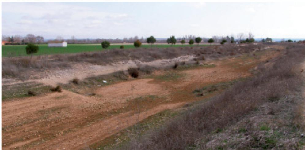
Figura 4: Cauce artificial del Alto Guadiana excavado en el fondo de valle tras la construcción del Embalse de Peñarroya.
