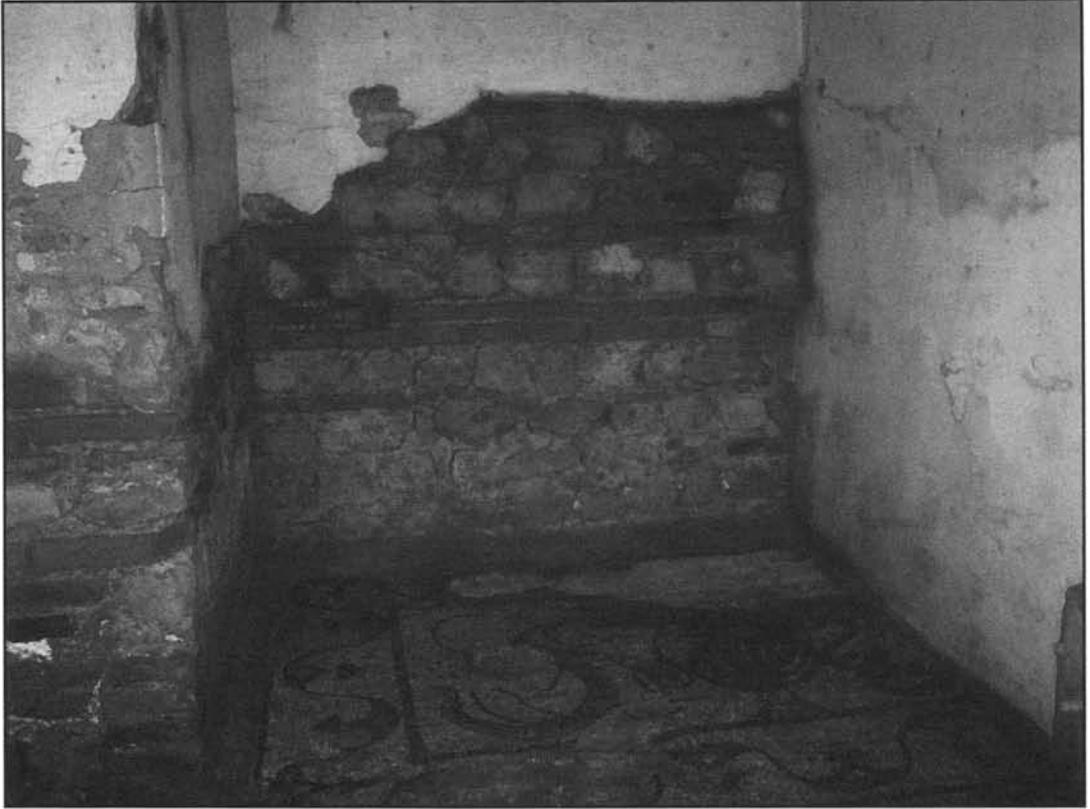
Vista de muros de opus vittatum en San Vicente.
