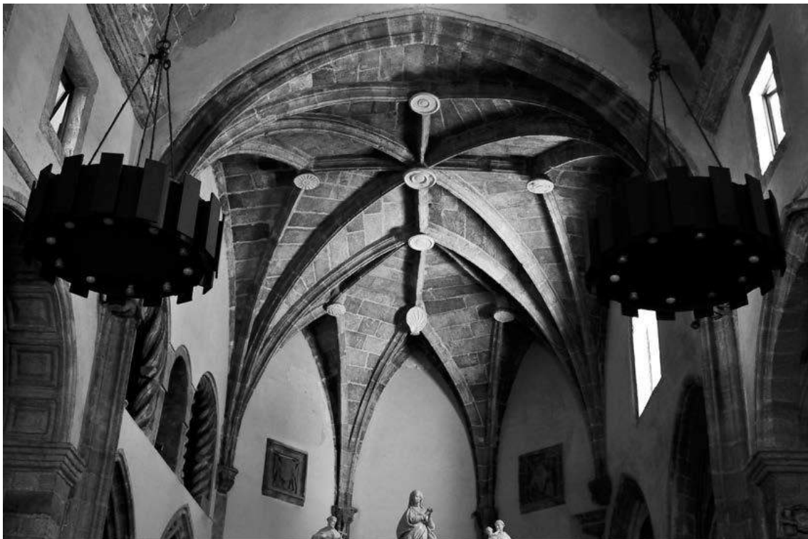
Fig. 12. Alghero. Iglesia conventual San Francisco de Alghero. Bóveda de crucería del presbiterio. [Foto: Federico Maria Giammusso]
