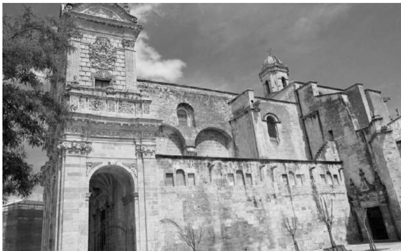
Fig. 75. Sassari. Catedral de San Nicolás. Exterior. Detalle de los arcos de descarga.
