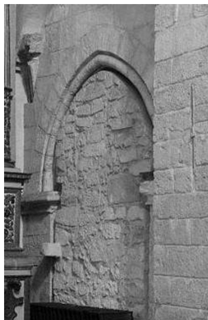
Fig. 66. Sassari. Catedral. Detalle de los antiguos arcos apuntados que permitían el paso entre las capillas laterales y arranque de las primitivas bóvedas de crucería que cubrían el espacio de cada capilla.
