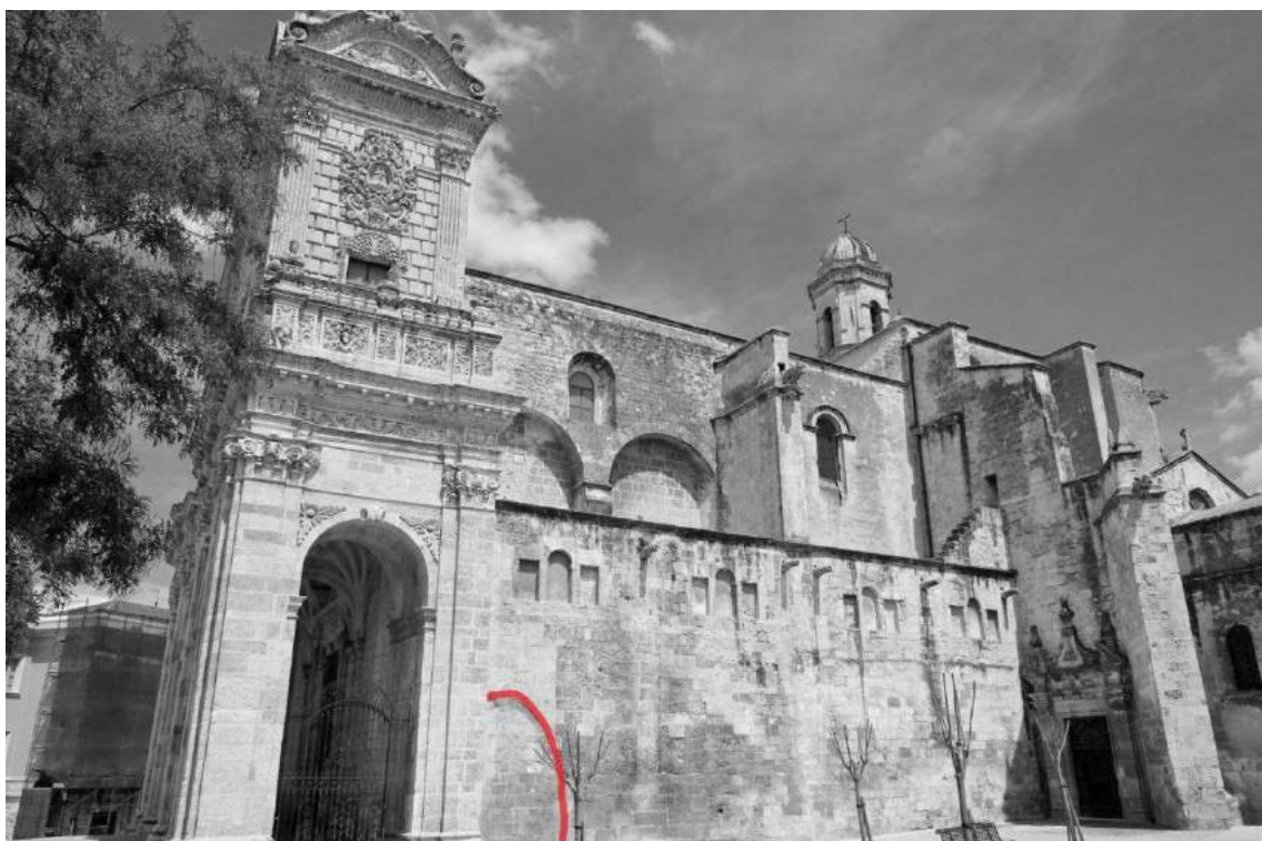
Fig. 65. Sassari. Catedral de San Nicolás. Exterior. En rojo el primitivo arco de acceso al coro alto situado en el primer tramo del templo, donde actualmente se erigen las bóvedas del pórtico.
