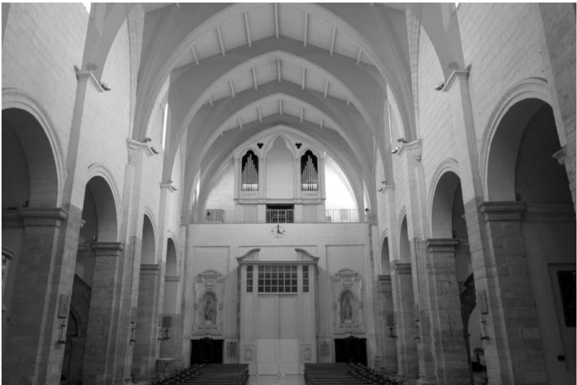
Fig. 64. Sassari. Catedral de San Nicolás. Reconstrucción de la primitiva cubierta de madera con arcos diafragma a partir de las pilastras que hoy en día carecen de utilidad. [Reconstrucción: Federico Maria Giammusso]
