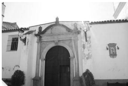
Fig. 100. Real de la Jara (Sevilla). Iglesia de San Bartolomé. Fachada. [Foto: www.sevillapedia.wikanda.es ]
