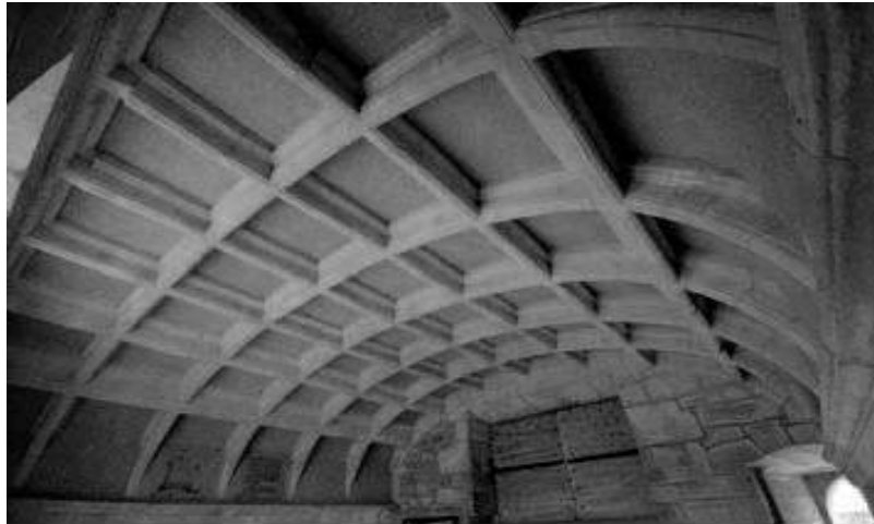
Fig. 42. Assier. Castillo. Zaguán. Detalle de la bóveda. [Foto: Javier Ibáñez Fernández]
