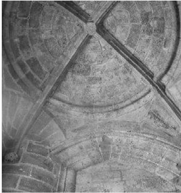
Fig. 15. Alghero. Catedral. Bóveda de platillo, sobre trompas, de la torre campanario. [Foto: ZARAGOZA, A., Arquitecturas del gótico... , op. cit., p. 153.
