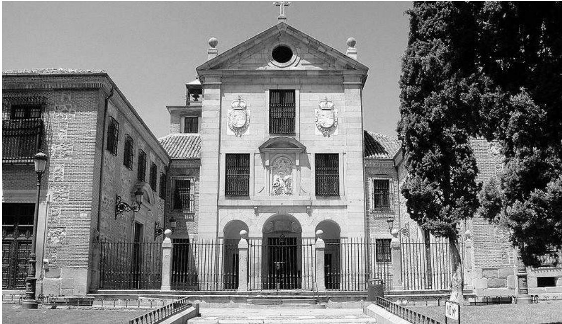
Fig. 80. Madrid. Convento de la Encarnación. Fachada. [Foto: https://commons.wikimedia.org ]
