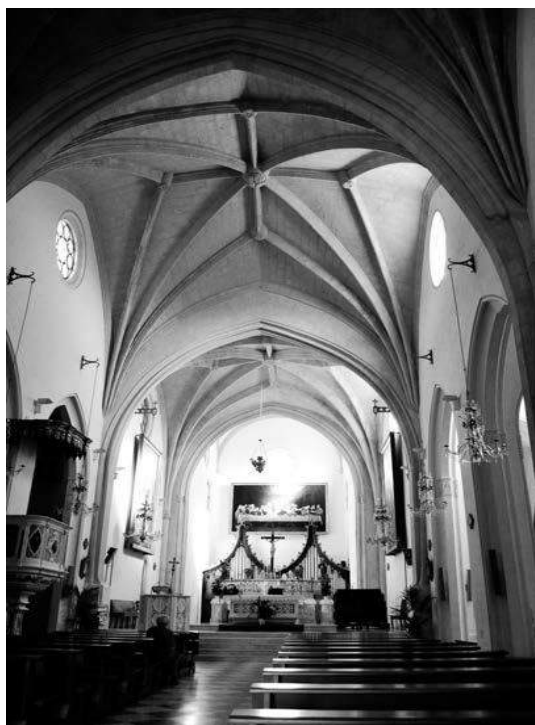
Fig. 10. Cagliari. Iglesia parroquial de Santa Eulalia. Nave cubierta con bóvedas de crucería de cinco claves. [Foto: Federico Maria Giammusso]
