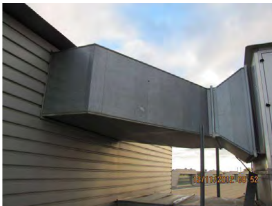
Conducto de retorno sin aislar. UTA 5.
