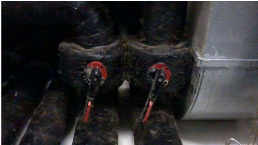
Válvulas del circuito Fancoils Física y química sin abrir del todo. Patinillo Física y química PB.
