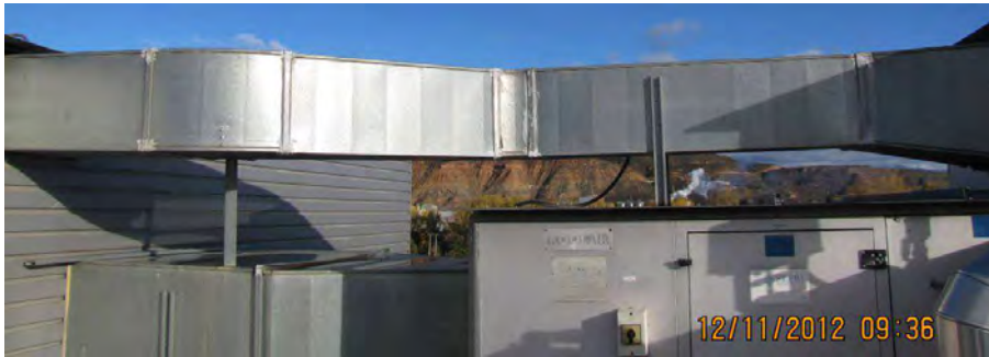
Circuito de retorno, sin aislar. UTA 2
