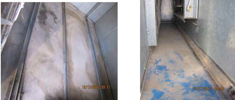
Circuito de retorno, sin aislar. UTA 2
