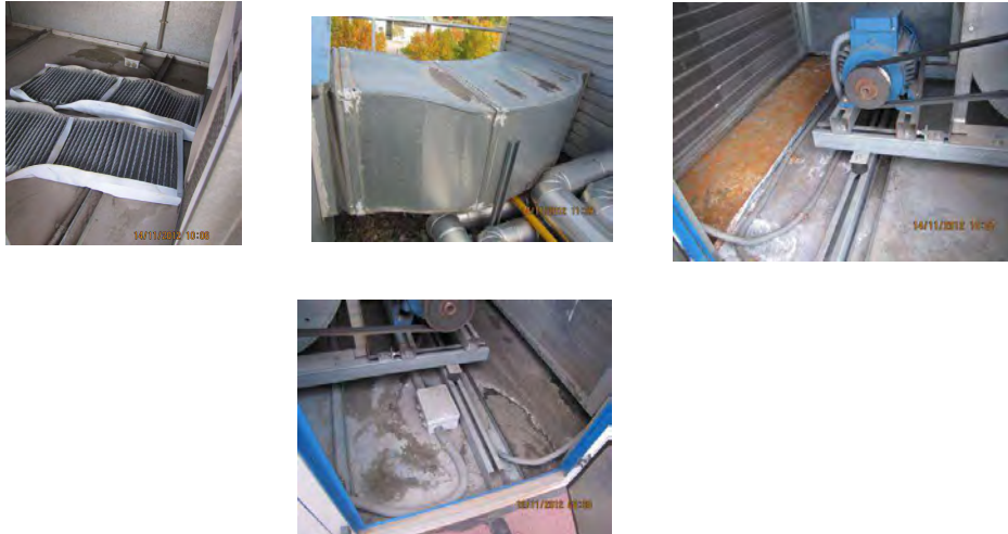
Figura 45.- Imágenes internas UTAs Edificio Científico Tecnológico
