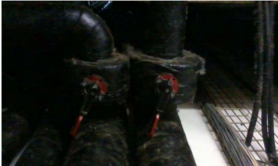
Válvulas del circuito Fancoils Física y química sin abrir del todo. Patinillo Física y química PB.
