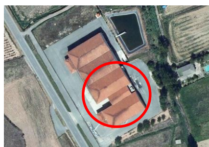
Figura nº 128. Vista aérea de la bodega cooperativa de Navarrete (La Rioja). (FUENTE: SIGPAC)
