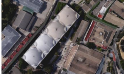
Figura nº 20. Vista de la cubierta de la bodega Tío Pepe de González Byass (Jerez) (FUENTE: Sigpac)
