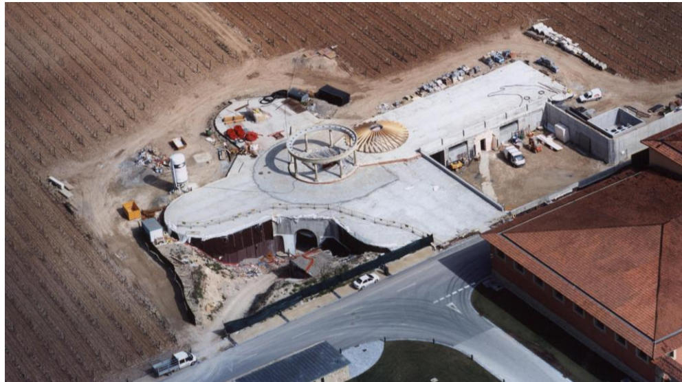
Figura nº 145. Vista aérea de construcción de bodega en Bodegas Dinastía Vivanco. (FUENTE: Paisajes de España)
