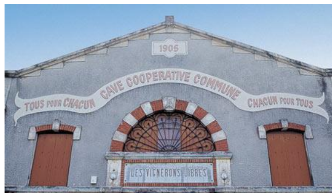
Figura nº 39. Fachada Cave Coopérative de Maraussan (Francia)
