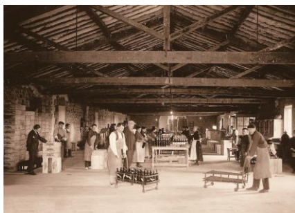
Figura nº 102. Imagen nave planta cota +0,00 m en su estado inicial. (FUENTE: Bodegas Franco-Españolas)
