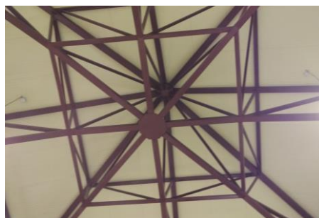
Figura nº 3. Bodegas Alto Moncayo en Borja (Zaragoza). Estructura embrochalada.
