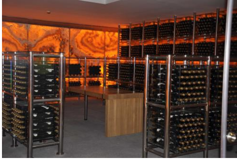
Figura nº 153. Botellero de cajones de vidrio sobre estructura de acero inoxidable. Bodegas Villarrica, Hervías (La Rioja)
