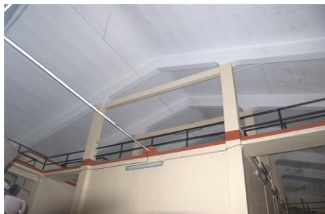
Figura nº 116. Fotografía de interior de la nave primitiva de la bodega cooperativa de Ausejo (La Rioja)
