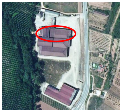
Figura nº 126. Vista aérea de la bodega cooperativa de Arenzana de Abajo (La Rioja). (FUENTE: SIGPAC)
