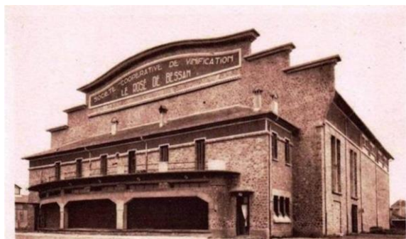
Figura nº 44. Fachada principal de bodega cooperativa Le Rosé de Bessan (Midi)
