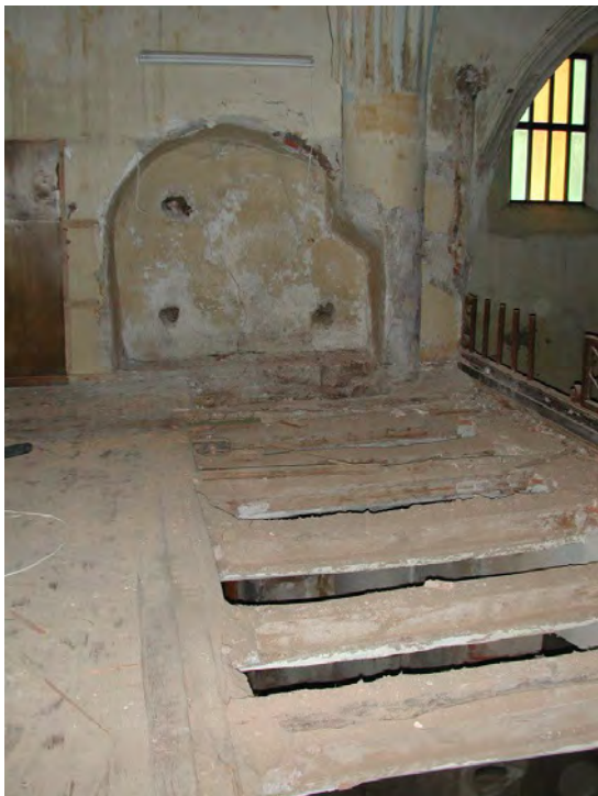
Lám. 225 - Convento de Santa Clara de Entrena, coro alto durante las obras de restauración de la iglesia, fotografía cedida por Gaspar Aragón Osés, arquitecto encargado de las obras de restauración, 2000.
