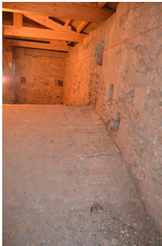
Lám. 219 - Convento de Santo Domingo de la Calzada, zona superior de la bóveda en el crucero (agosto 2012).
