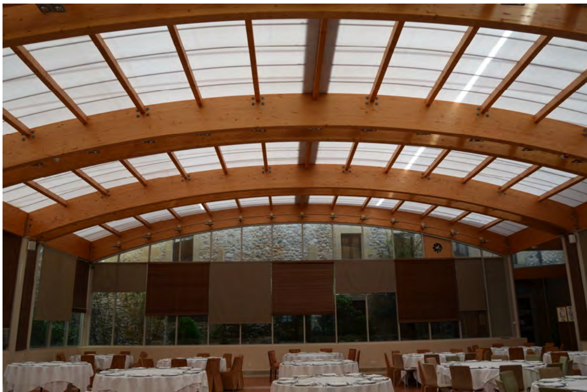
Lám. 213 - Convento de Santo Domingo de la Calzada, parador, comedor ubicado en el patio de novicios (agosto 2012).
