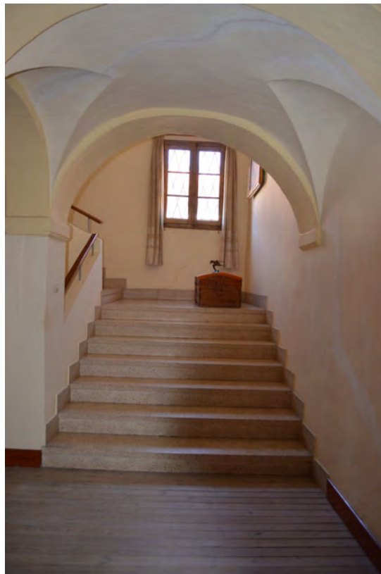
Lám. 336 - Convento de la Purísima Concepción de Alfaro, escalera suroeste de acceso a planta segunda (julio 2013).
