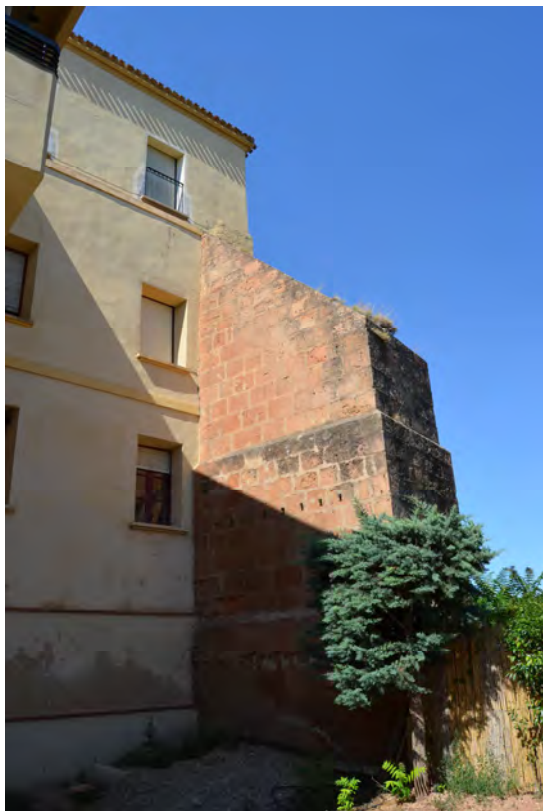
Lám. 192 - Convento de Vico en Arnedo, fachada sur, detalle de un contrafuerte (7/8/2012).
