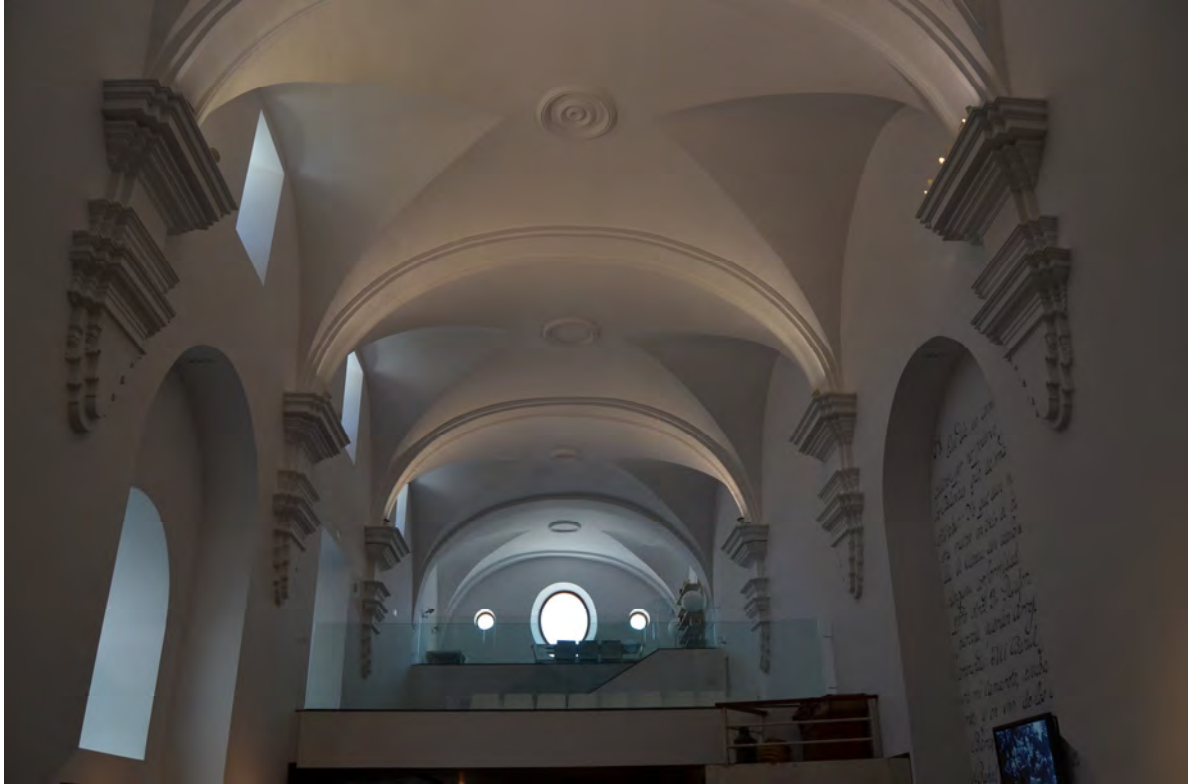
Lám. 348 - Convento de San Francisco en Torrecilla de Cameros, detalle de las bóvedas de cubrición (agosto 2012).
