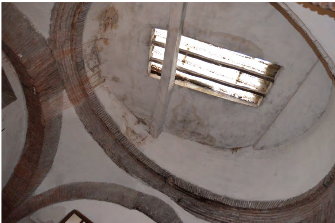
Lám. 323 - Convento de Santa Elena en Nájera, lucernario en cocina antigua (noviembre 2012).
