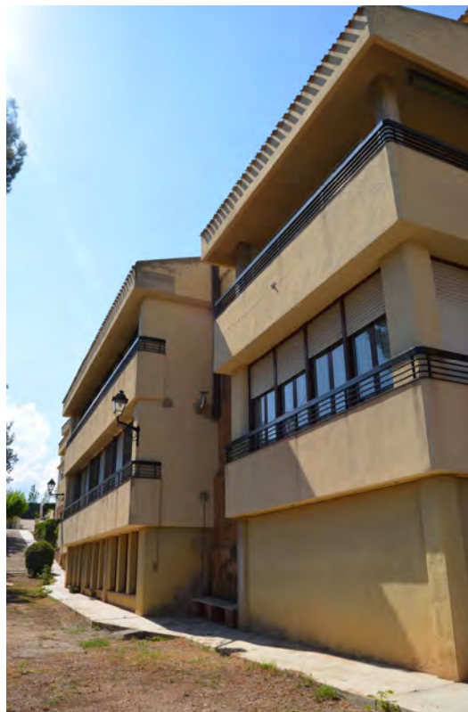
Lám. 193 - Convento de Vico en Arnedo, miradores en fachada sur entre los contrafuertes (7/8/2012).
