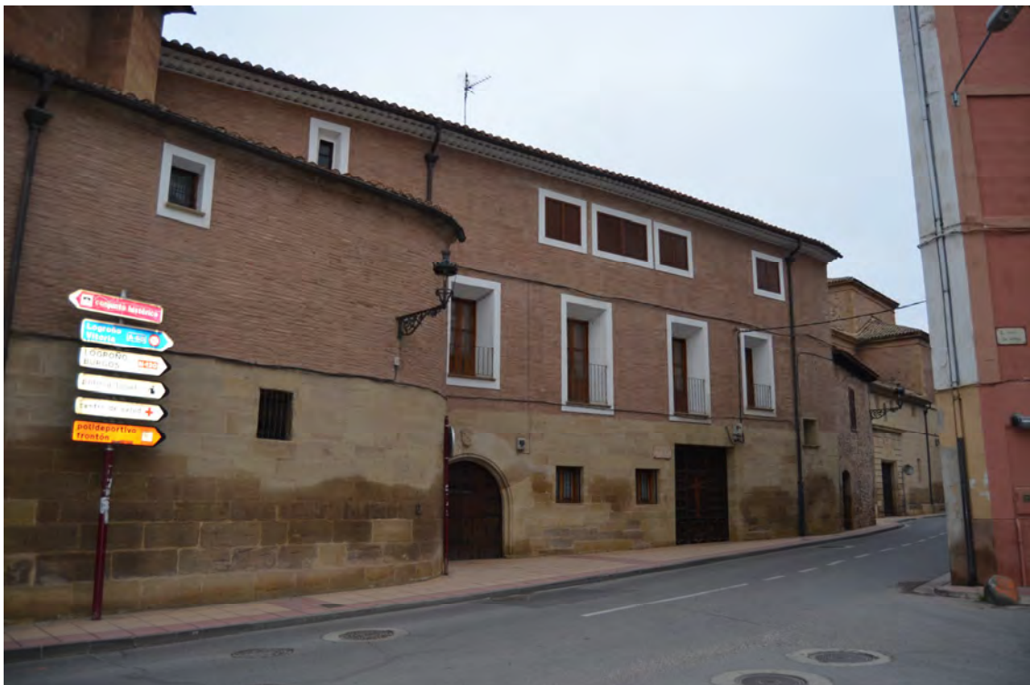
Lám. 78 – Convento de Santa Elena en Nájera, fachada a calle San Fernando con la iglesia al fondo (noviembre del 2012).
