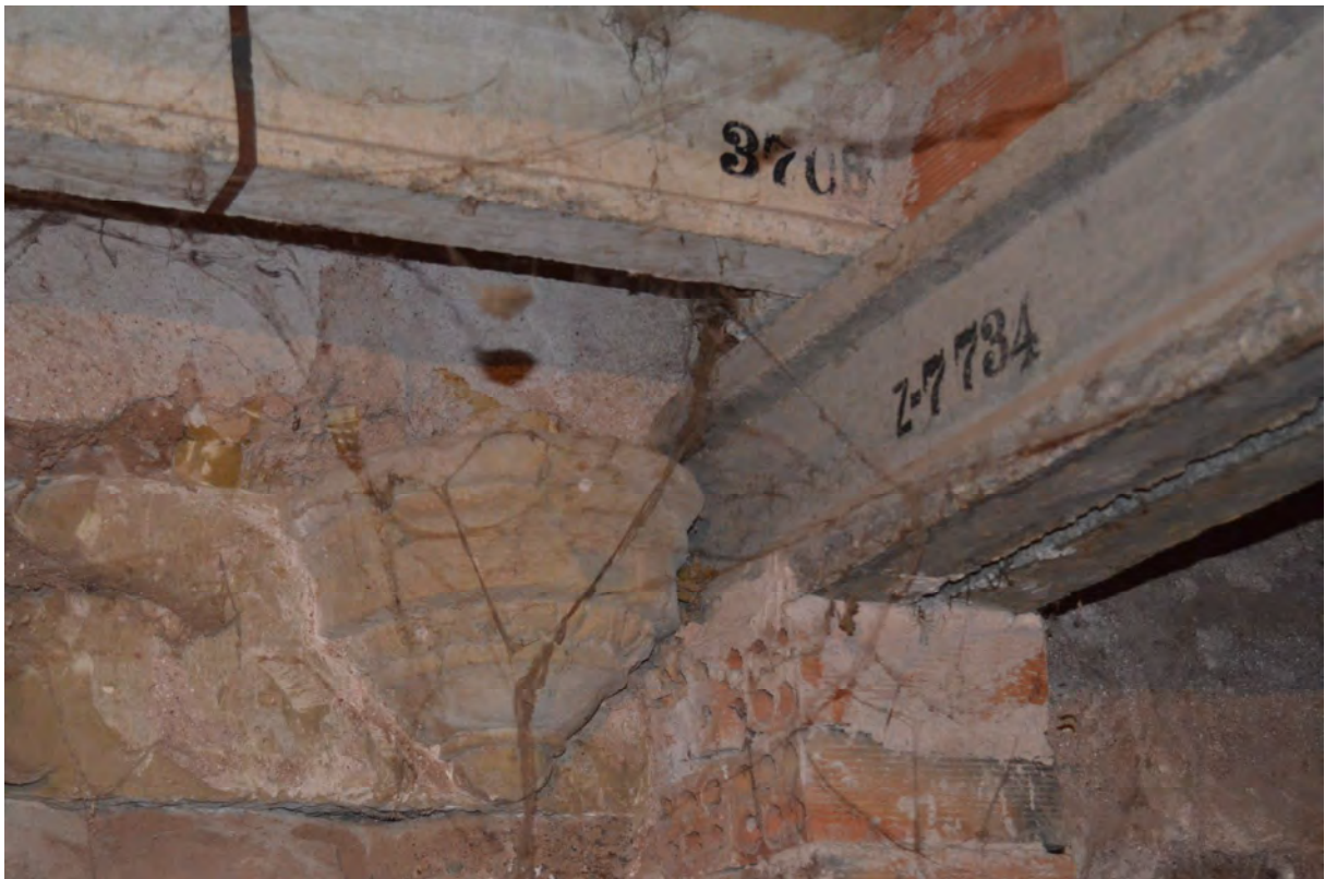
Lám. 245 – Convento de San Francisco de Nájera, detalle de un capitel del antiguo edificio conventual escondido entre viguetas de hormigón de intervenciones posteriores.
