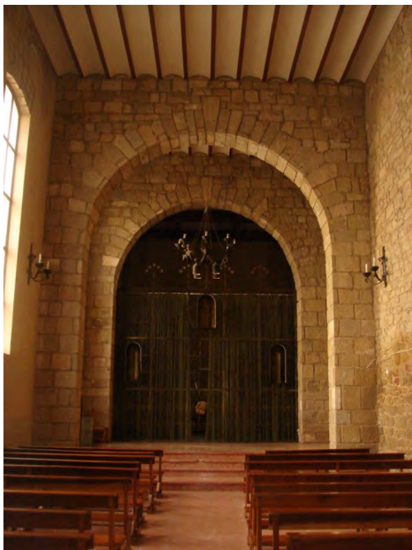
Lám. 260 – Convento de Madre de Dios de Logroño, interior de la iglesia, vista hacia la cabecera (enero 2012).
