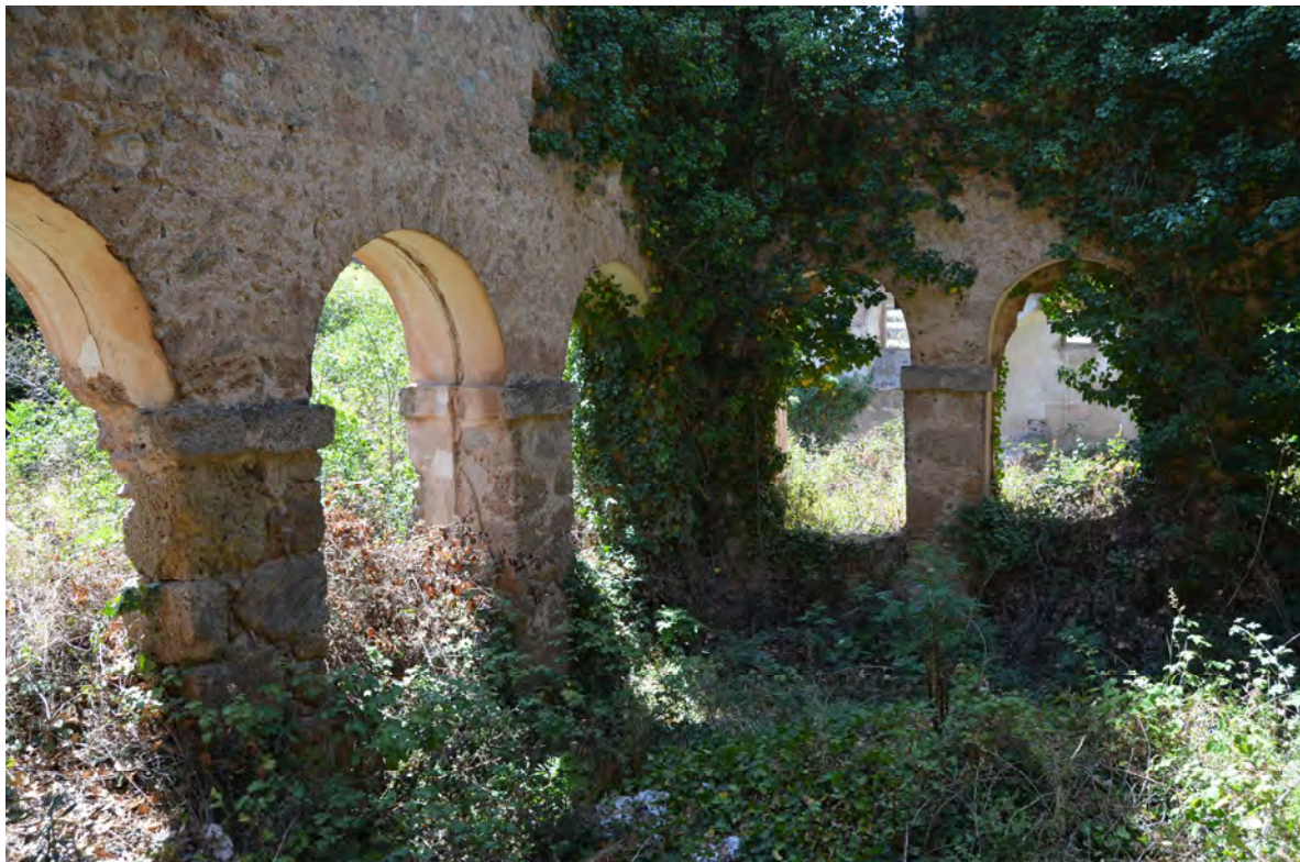
Lám. 159 - Convento de San Antonio de Padua en Nalda, muros este y sur del patio del claustro (agosto 2012).
