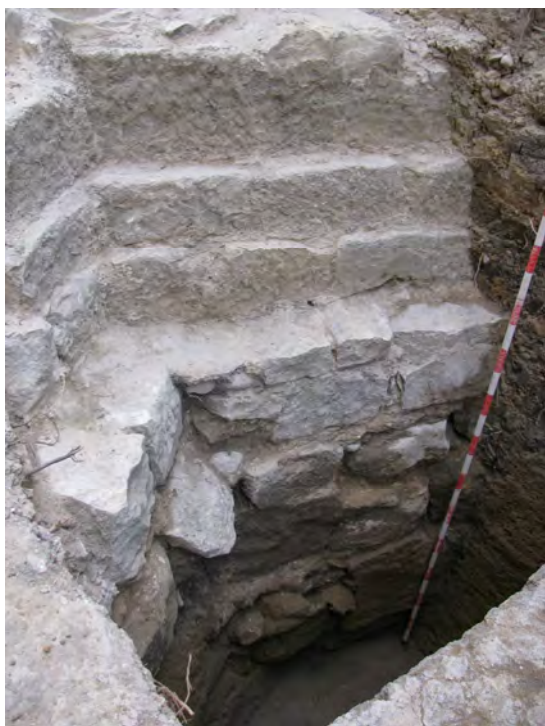
Lám. 176 – Convento de Madre de Dios de Logroño, detalle de la cimentación del contrafuerte este de la cabecera de la iglesia antigua (ANGULO SÁENZ Teresa y PORRES CASTILLO Fernando, Informe de los sondeos de caracterización estratigráfica... , op. cit., p. 34), enero 2012.
