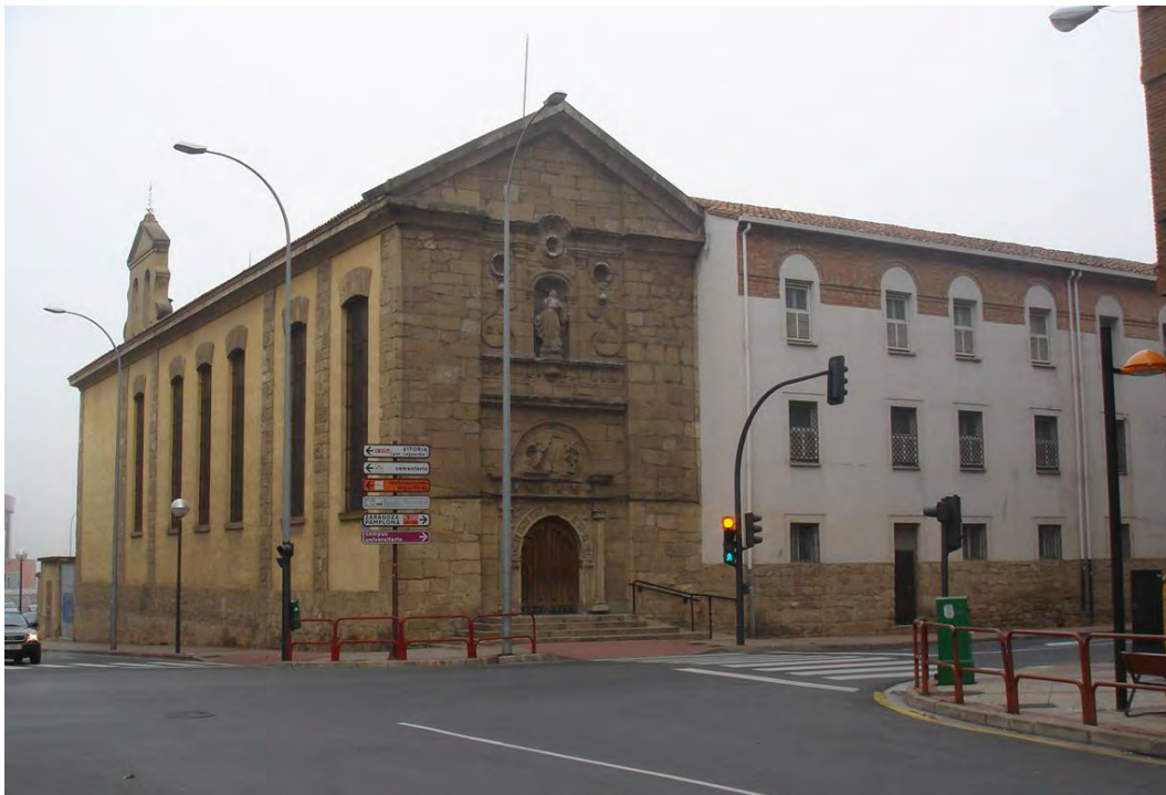
Lám. 61 – Convento de Madre de Dios de Logroño, iglesia y paño de la fachada sur que se reconstruyó en las obras de 1970 (enero 2012).
