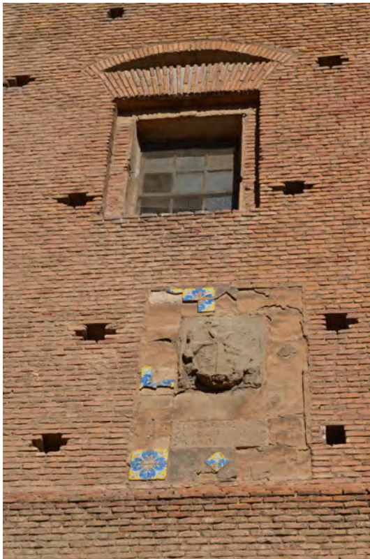
Lám. 268 - Convento de San Francisco en Alfaro, escudo en lateral este de la cabecera (julio 2013).
