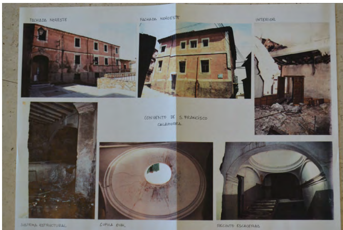
Lám. 284 – Convento de San Francisco de Calahorra, fotografías de la fachada hacia la plaza Rasillo de San Francisco e interiores del edificio sacadas del proyecto antes mencionado, estado en el que se encontraba la edificación, 1989 (AGLR, sig. 04760 y 04761).
