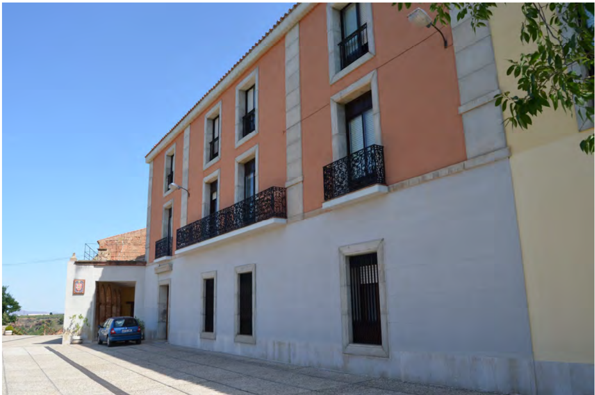
Lám. 189 - Convento de Vico en Arnedo, fachada norte, casa de Olózaga (actual hospedería) (7/8/2012).
