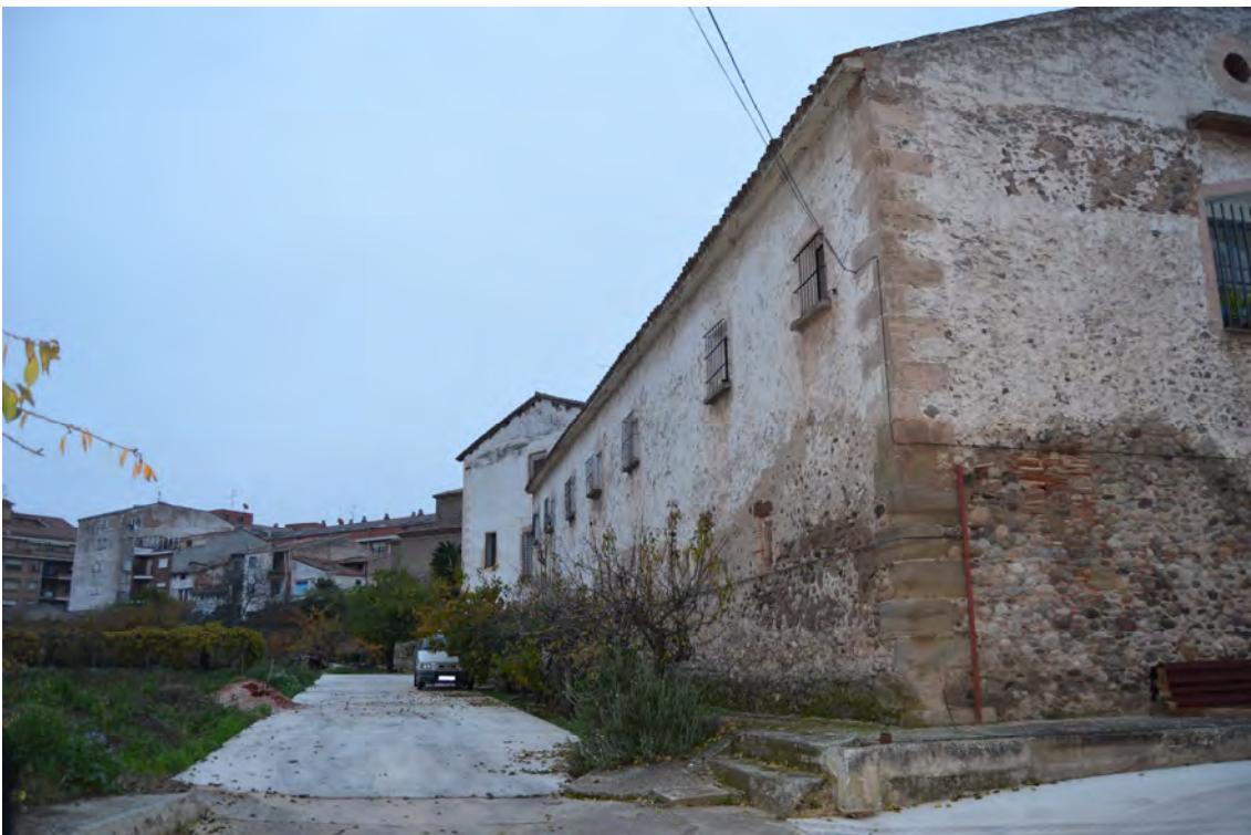
Lám. 172 – Convento de Santa Elena en Nájera, vista de las edificaciones interiores del convento con la huerta a la izquierda (noviembre 2012).
