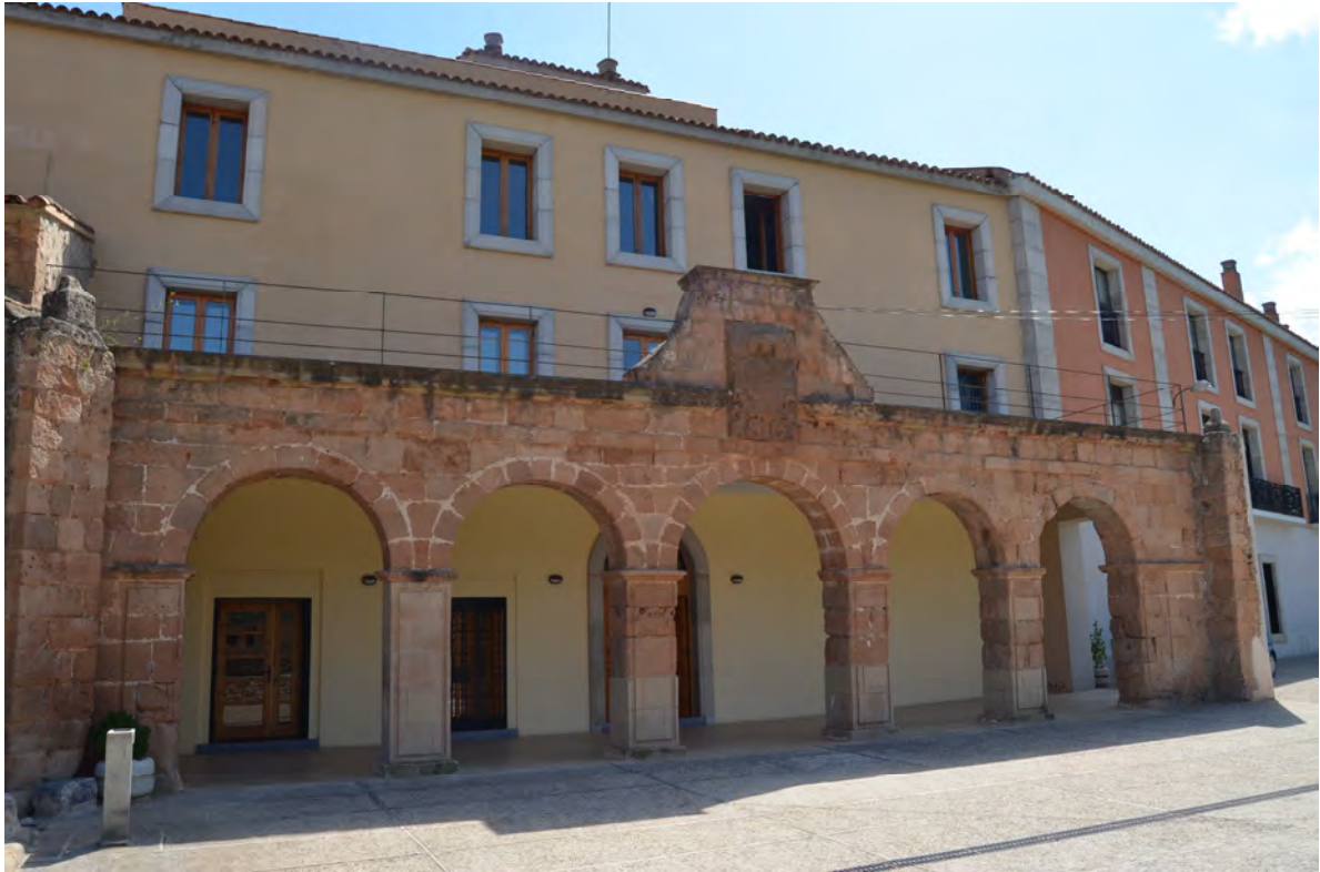
Lám. 188 - Convento de Vico en Arnedo, fachada norte, pórtico de entrada al Convento (7/8/2012).
