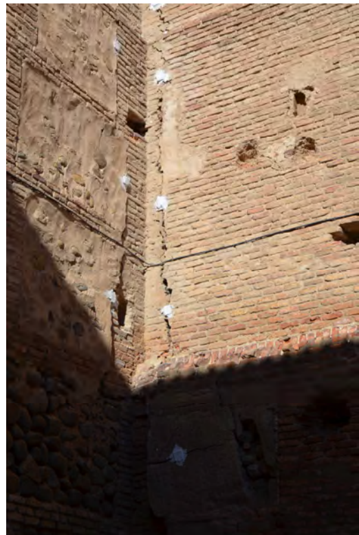
Lám. 269 - Convento de San Francisco en Alfaro, grieta con testigos en la esquina del ala este del crucero y la cabecera (julio 2013).
