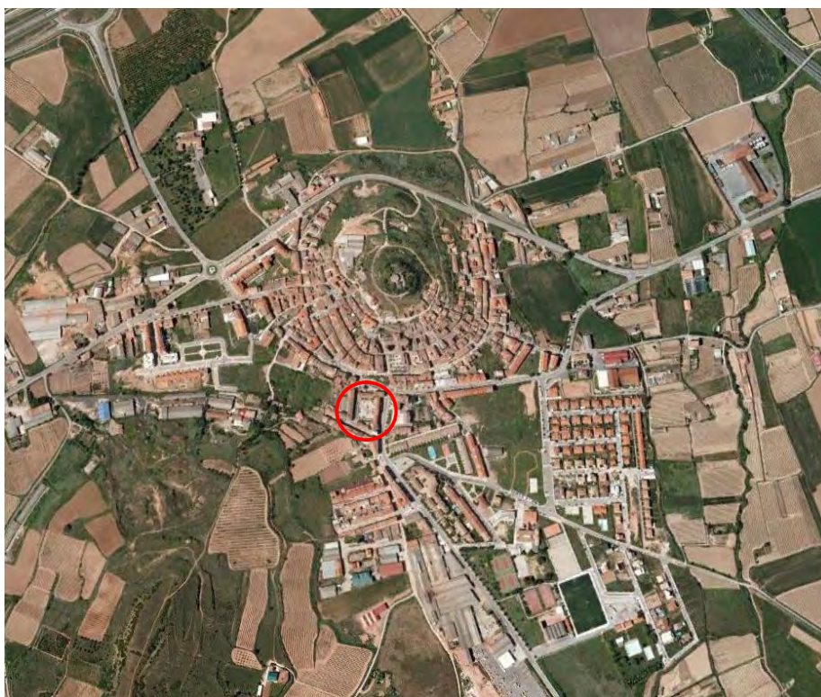
Lám. 10 – Convento de Santa María de Jesús en Navarrete, vista del Google Earth del 1-1-09 de la población indicando dónde se ubicaba el convento.
