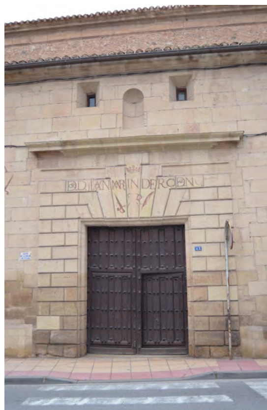
Lám. 148 – Convento de Santa Elena en Nájera, puerta de acceso a la iglesia (noviembre 2012).
