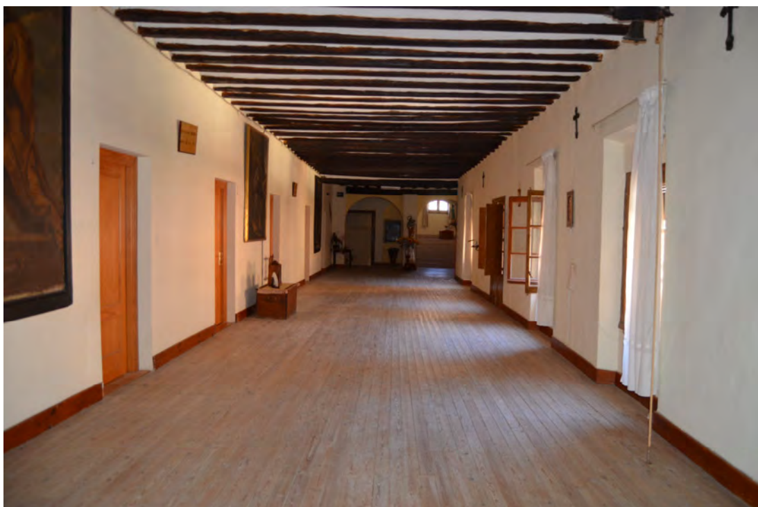
Lám. 337 - Convento de la Purísima Concepción de Alfaro, deambulatorio en planta primera en torno al patio, lado sur (julio 2013).
