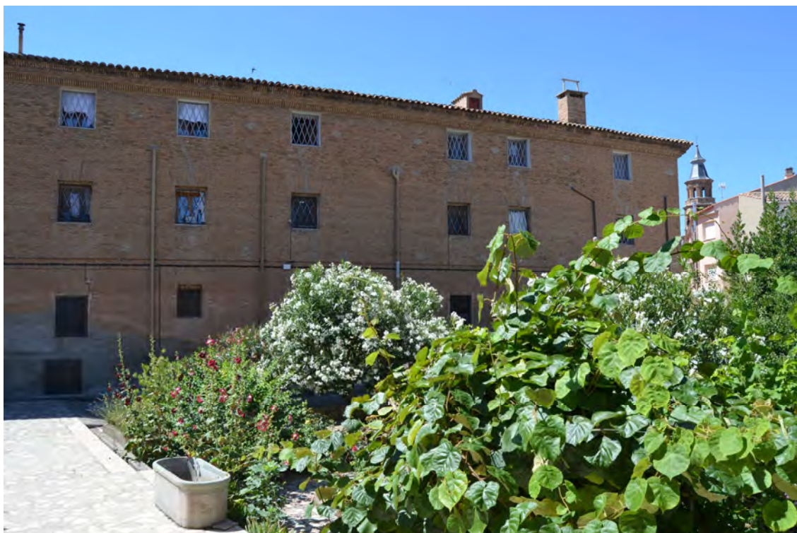
Lám. 334 – Convento de la Purísima Concepción de Alfaro, alzado norte del convento (julio 2013).
