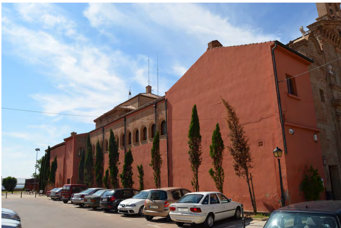
Lám. 281 – Convento de San Francisco de Calahorra, fachada del edificio anexo a la iglesia (abril 2013).
