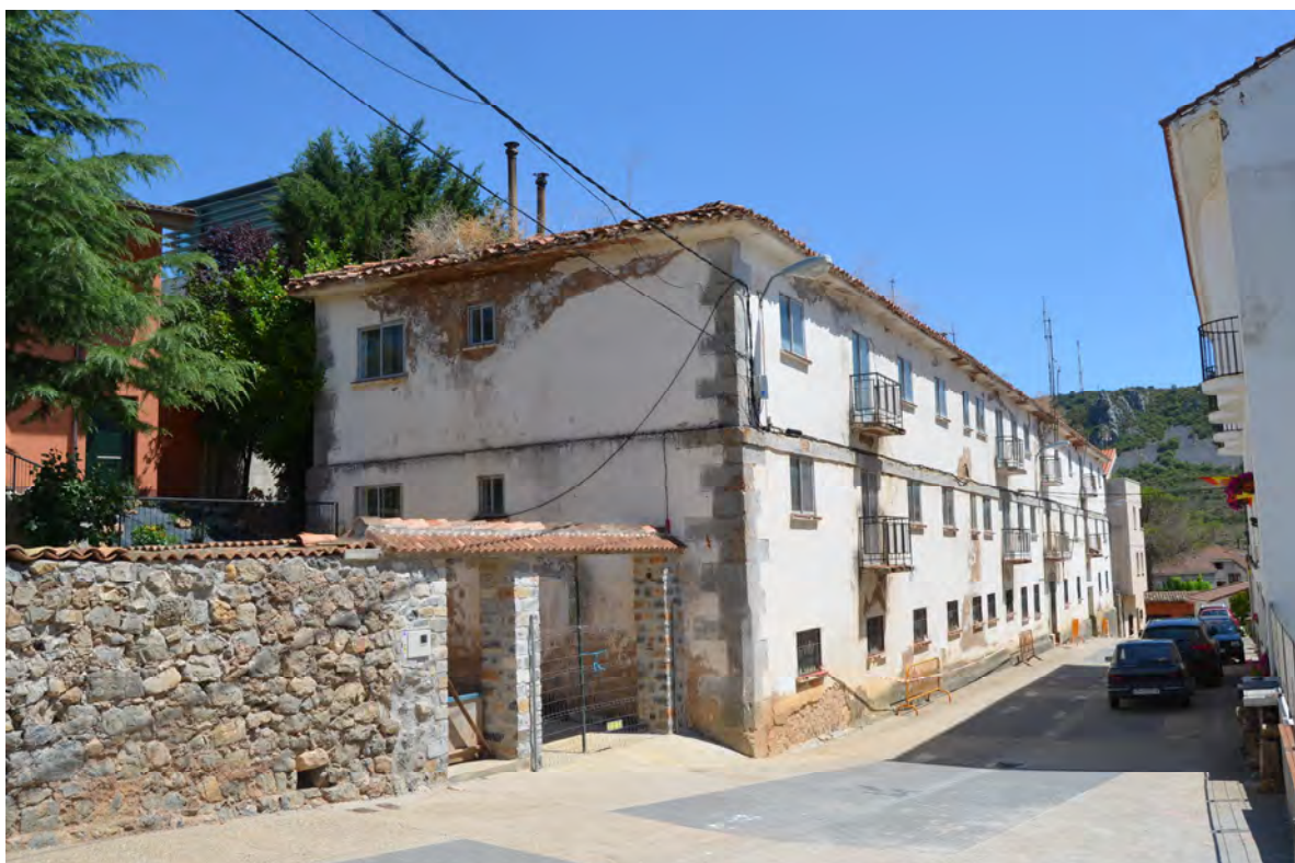
Lám. 351 - Convento de San Francisco en Torrecilla de Cameros, fachada suroeste del antiguo Cuartel de la Guardia Civil, ubicado en lo que fueron las dependencias conventuales (agosto 2012).
