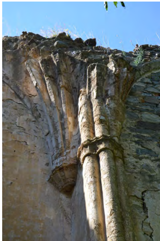
Lám. 110 – Convento de Campolapiente en Cornago, detalle del remate a modo de capitel en las columnillas y arranque de las bóvedas de la cabecera y primer tramo de la nave (julio 2013).
