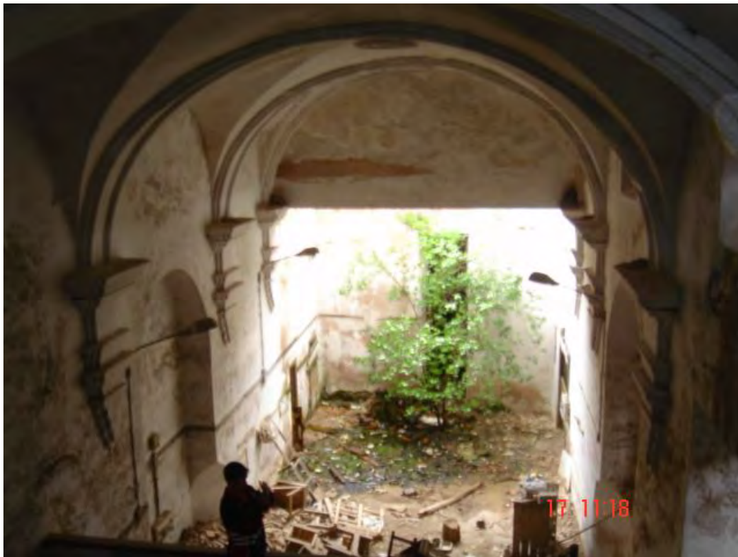
Lám. 340 – Convento de San Francisco en Torrecilla de Cameros, fotografía del estado de la iglesia en 2008 antes del inicio de las obras, realizada desde el coro hacia la cabecera, cedida por Javier Arizcuren.
