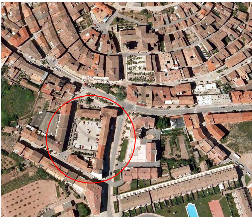
Lám. 11 – Convento de Santa María de Jesús en Navarrete, vista del Google Earth del 1-1-09 de la población en la que se aprecia el aparcamiento que ocupa lo que en su día fue el claustro del convento.
