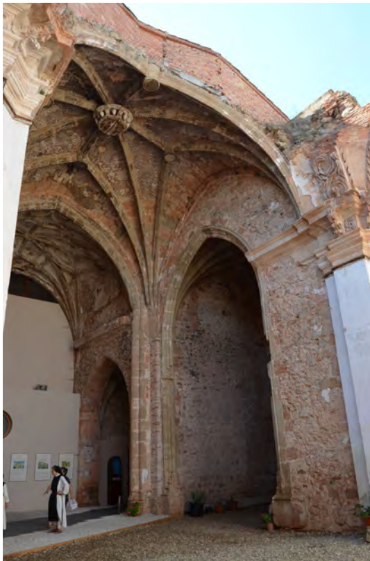
Lám. 200 - Convento de Vico en Arnedo, nave de la iglesia (7/8/2012).
