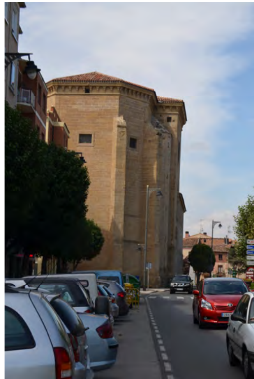
Lám. 117 - Convento de Santo Domingo de la Calzada, vista exterior de la cabecera de la iglesia (agosto 2012).
