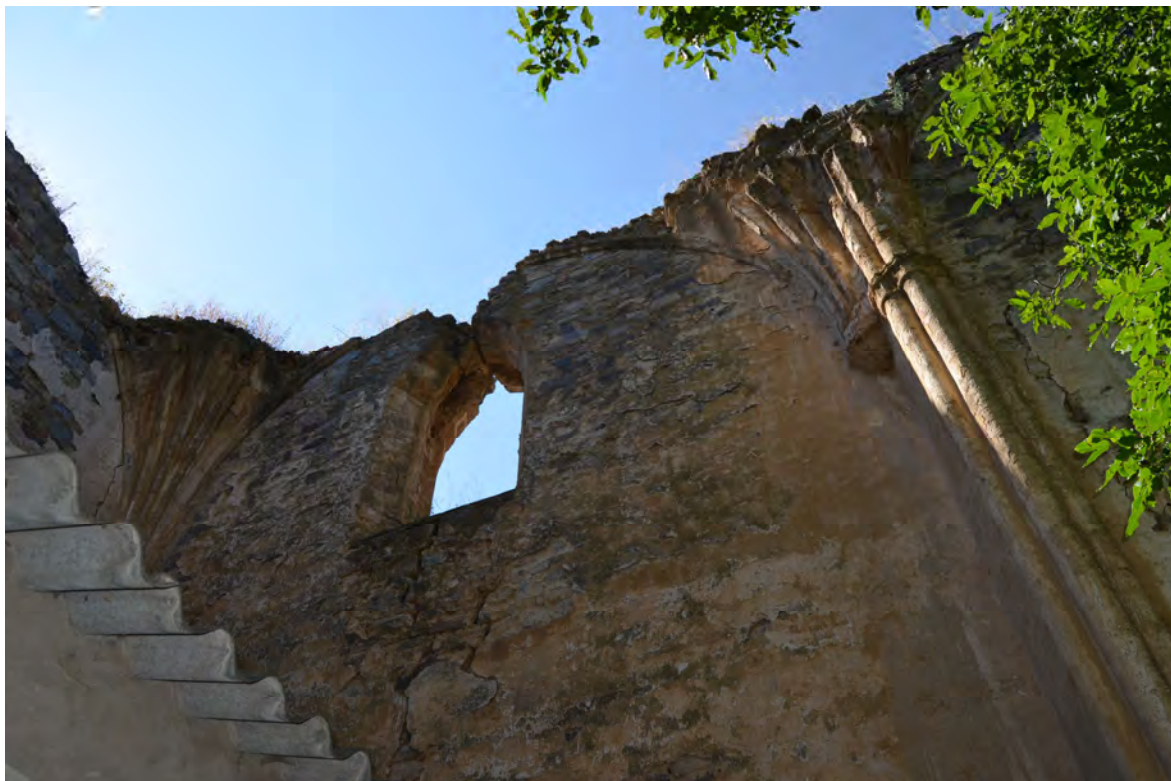
Lám. 107 – Convento de Campolapiente en Cornago, interior de la cabecera, paño sur, vista de la ventana con arco apuntado, los haces de columnas que separan la cabecera de la nave y los arranques de la bóveda que cubría la cabecera (julio 2013).
