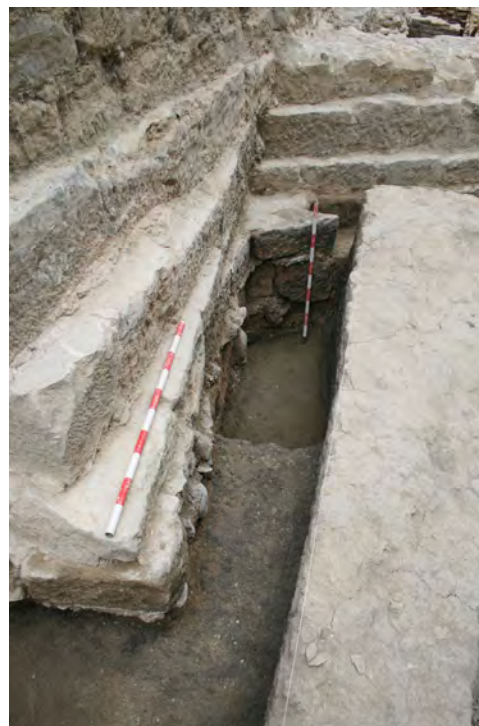
Lám. 177 – Convento de Madre de Dios de Logroño, detalle de la cimentación en la zona de unión del brazo del crucero este y la cabecera de la iglesia antigua (ANGULO SÁENZ Teresa y PORRES CASTILLO Fernando, Informe de los sondeos de caracterización estratigráfica... , op. cit., p. 36), enero 2012.
