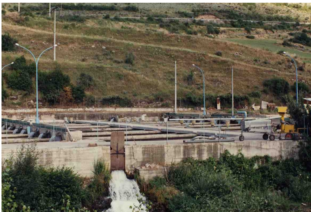
Figura A-5.3: Suelta de agua en la piscifactoría de Torrecilla.
