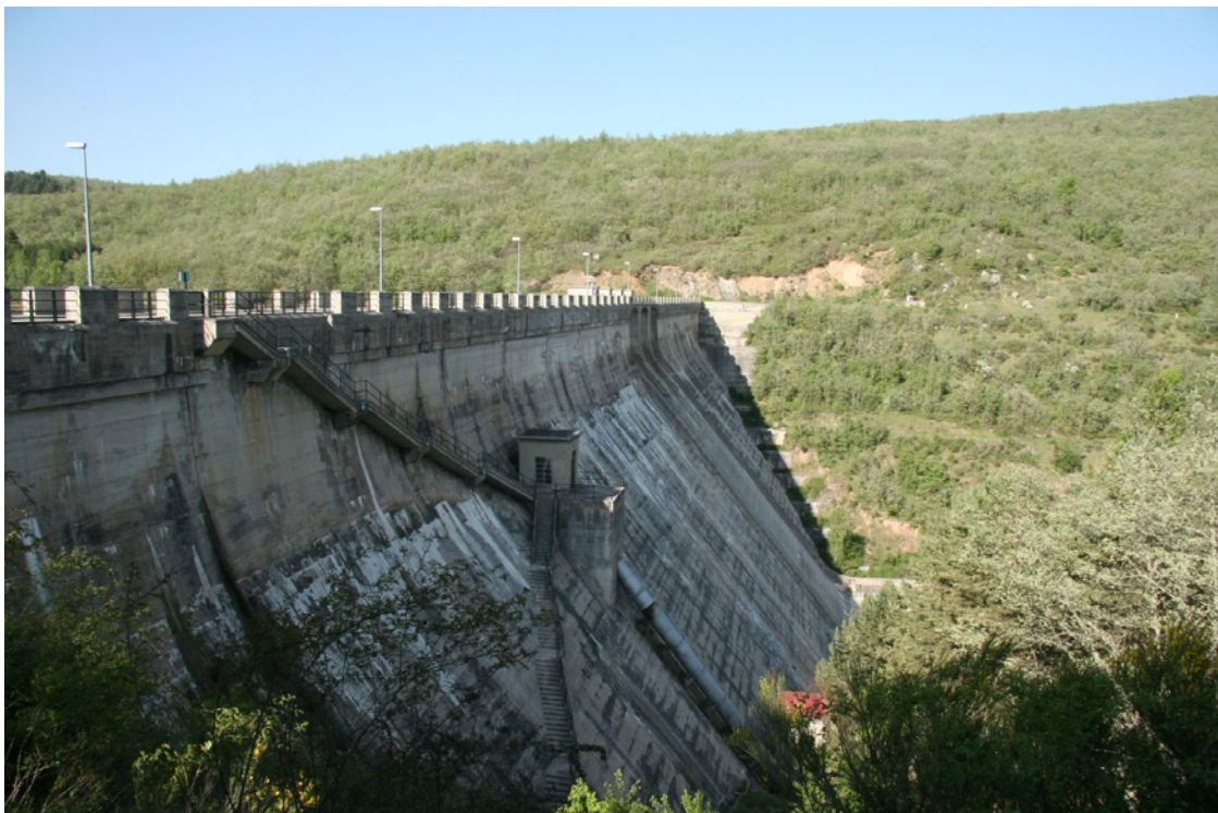
Figura A-5.10: Vista desde la presa del embalse de González Lacasa (Ortigosa).
