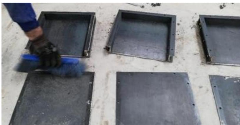
*Ilustración 21 - Ejemplo de limpieza y aplicación de desencofrante a los moldes*
