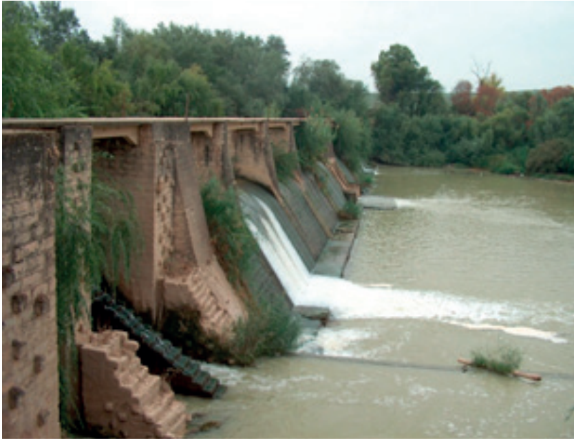
Figura 7.20.–Cuerpo de presa de la central Casas Nuevas.
