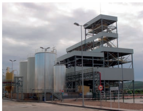
Fotografía 3.4.–Planta de producción de biodiesel (Estación de Linares-Baeza)
