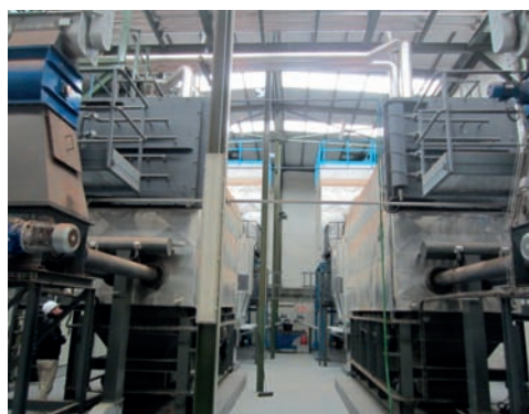
Fotografía 3.6.–Sistema de climatización centralizada con hueso de aceituna de geolit (Mengíbar).
