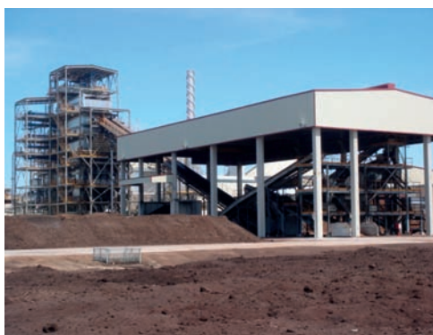
Fotografía 3.5.–Planta de generación de energía eléctrica alimentada con biomasa del olivar (Estación de Linares-Baeza).
