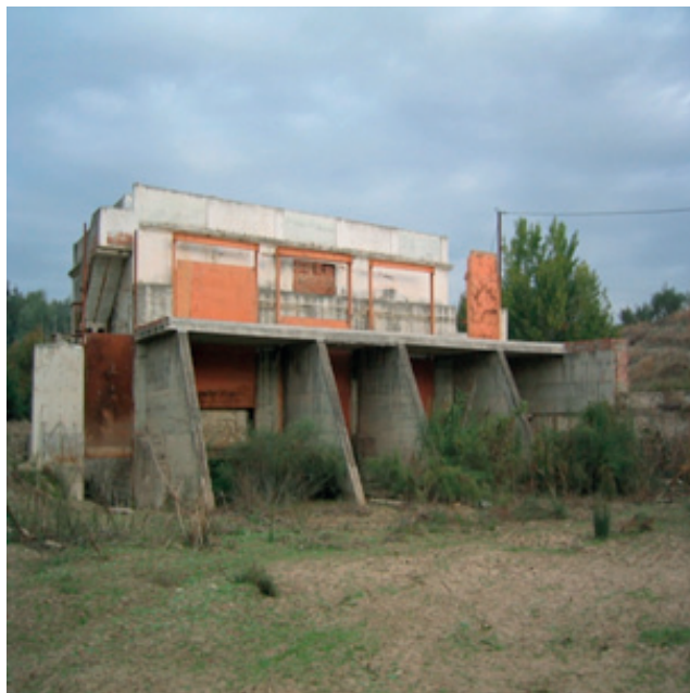
Figura 7.22. Estado actual del edificio de la central de Puente del Obispo.
