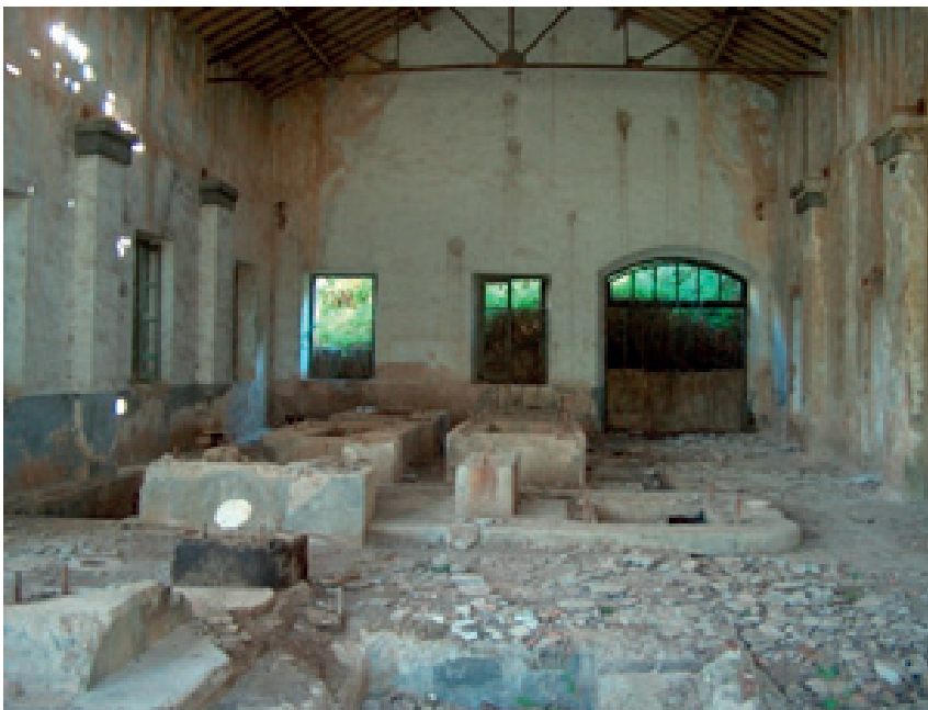
Figura 7.21.–Interior del edificio de la central Valdepeñas.
