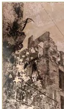
Fig. 05 | Edificio de los almacenes Casa Viniegra que ardió y donde se encontró un cadáver calcinado. (F.D.B.N.E.).
