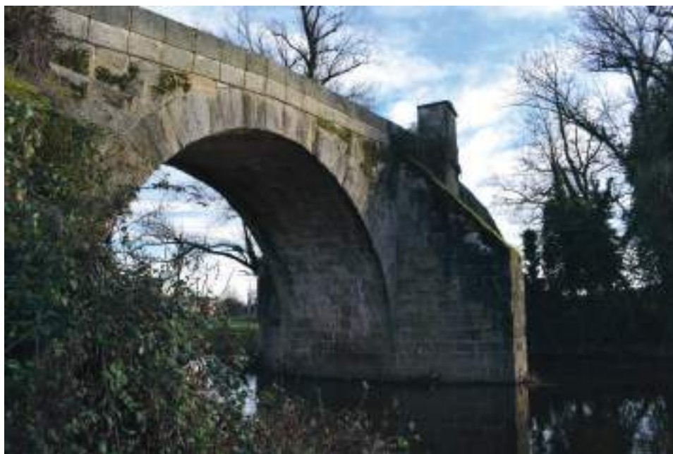
FIG. 12. Pila central del Puente de Carracedo. Fotografía del autor.
