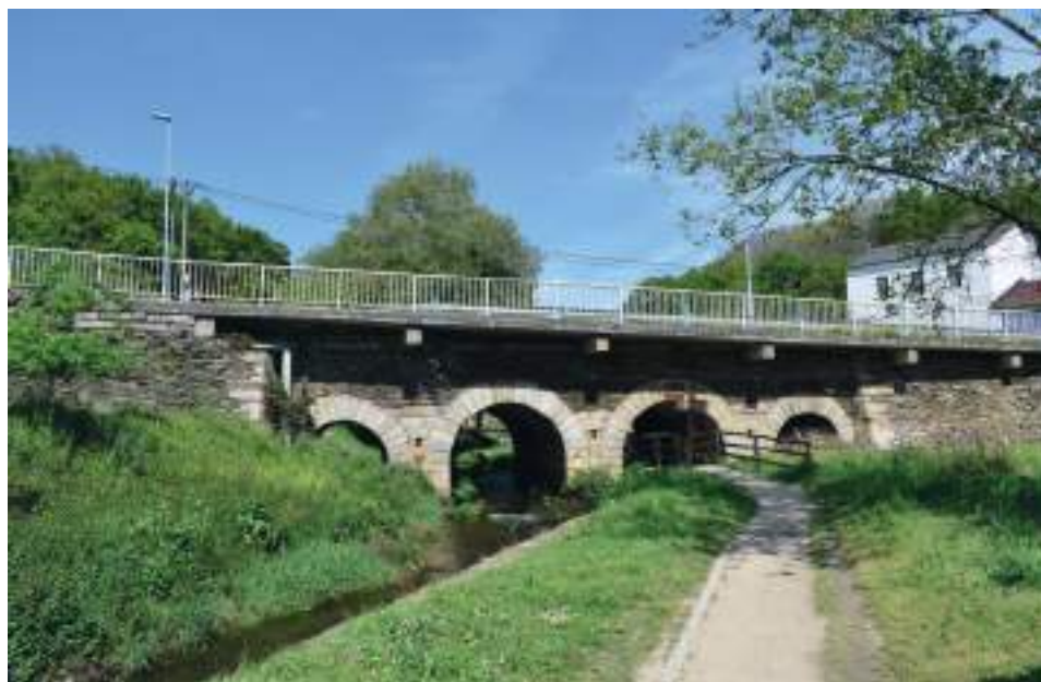
FIG. 22. Puente de San Fiz (aguas abajo). Reformado hacia 1630, aunque sufrió modificaciones en los siglos posteriores. Fotografía del autor.
