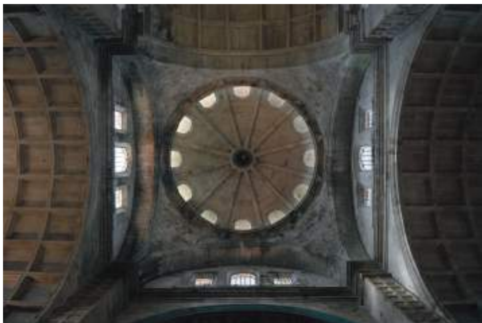
FIGS. 37-38. Cimborrio y media naranja de la iglesia monasterial de San Martín Pinario vistos desde la nave y la parte central del crucero. Obra diseñada en 1625 por Constantino Leitão de Vasconcelos y aprobada el 25 de julio de dicho año por fray Bernardo Gómez. Fotografías del autor.
