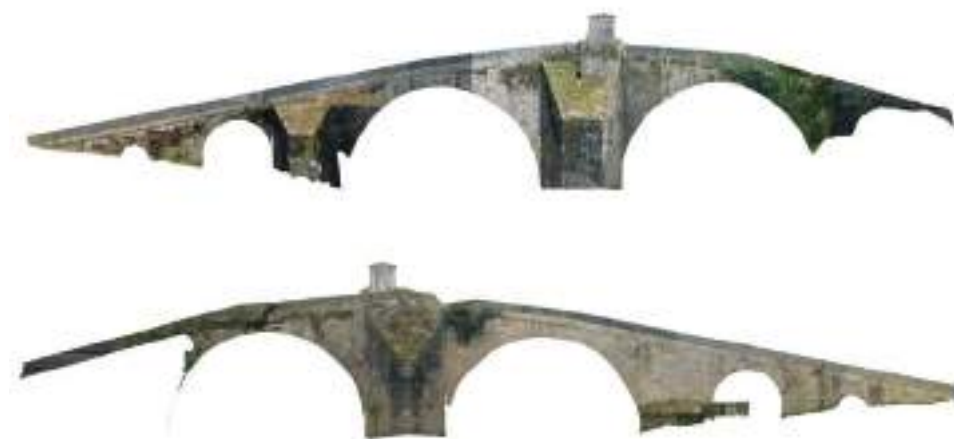
FIG. 11. Infografía del Puente de Carracedo creada con dos ortofotografías debidas a Belén Riveiro Rodríguez. Cortesía de la citada autora.
