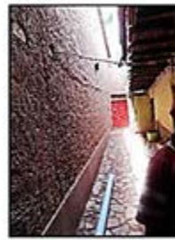
Ingreso peatonal tipo "T", calle Umanchata N° 121, Cusco
