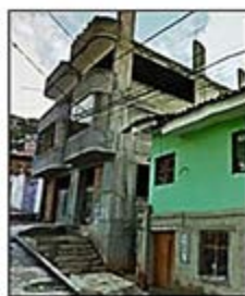
Ingreso peatonal, jirón Pumacahua N° 250, Urb. Tahuantinsuyo, Cusco
