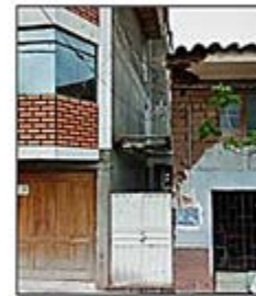
Ingreso peatonal tipo "I", calle Rosa Túpac Amaru NI- 19, San Sebastián.
