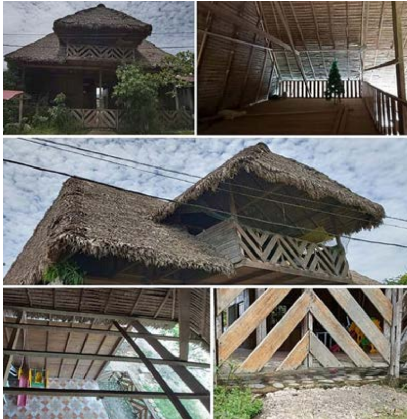
Figura 8 Isometría y registro fotográfico de la vivienda C en la comunidad Kotsimba
