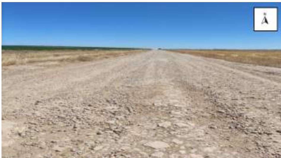
Figura 60: Vista general panorámica de la probable vía secundaria con los indicios evidentes que pudieran indicar los restos cimentados a base de cantos rodados alternados con caliza y grava sobre la pista que presenta una anchura de aproximadamente 7 metros. Fuente: foto autor.
