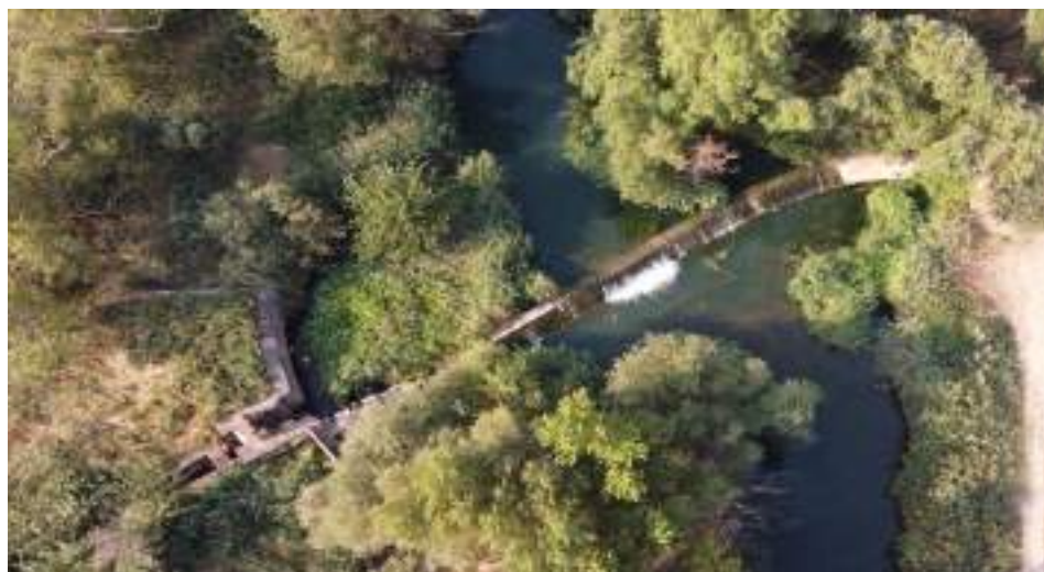
Figura 54: Azud actual de Madriz-Centén, al sur de las Murallas de Grisén, en la localidad homónima. Fuente: imágenes tomadas a través de vuelo dron DJI Mavic Pro Platinum a un altura de 100 m y distancia focal de 24 mm. Foto autor.
