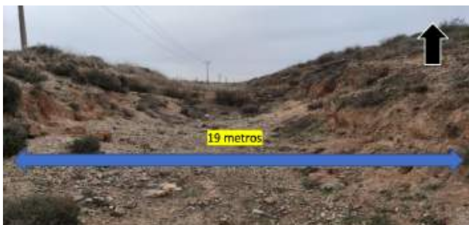
Figura 126: Acequia Revieja en sus cercanías a la Urb. Lago Azul. Fuente: foto autor.
