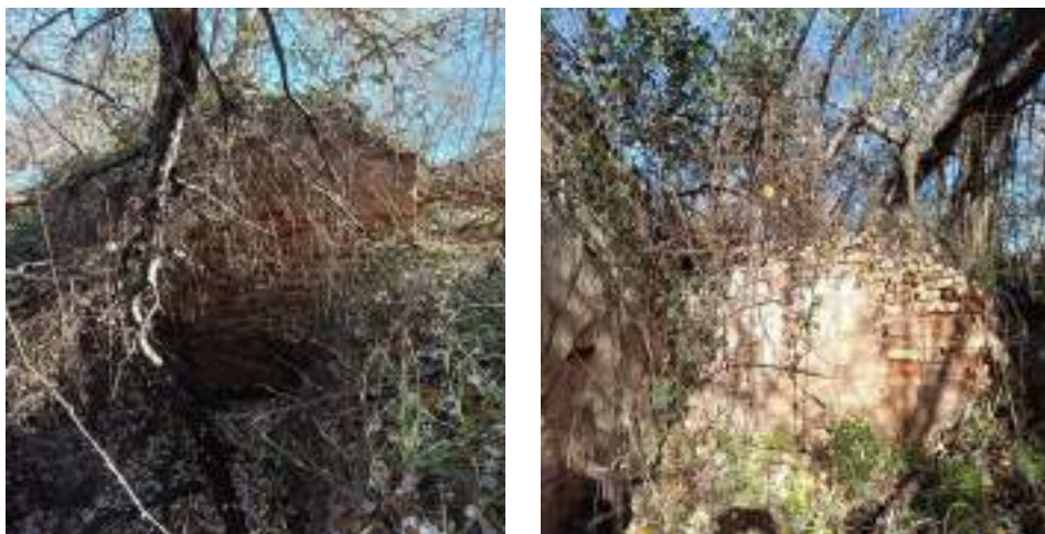
Figura 71 y 72: Imagen de la casa de compuertas anexa al azud, denominada almenara, y por donde normalmente se regulaba la entrada de agua a través del control de las compuertas o tajaderas que se solían situar en su interior. Fuente: Foto autor.
