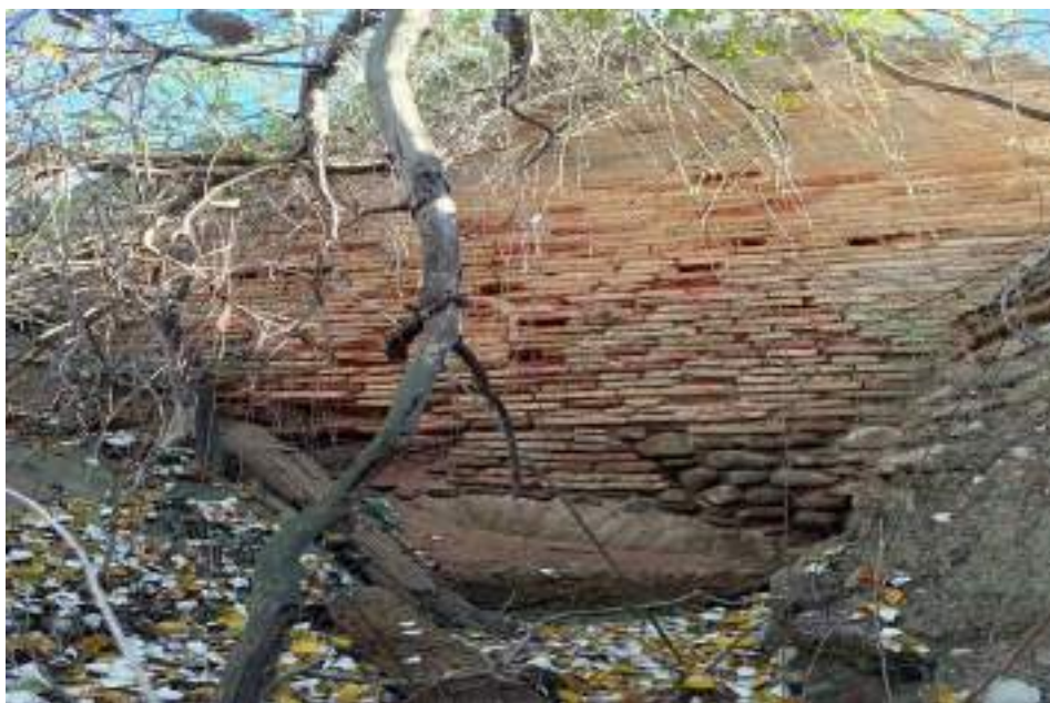
Figura 82: Parte final de la “garganta” y lugar por donde entraría el agua directamente del río a través del canal excavado hasta su cauce. Junto a la parte del techo abovedado donde se ubicaría un poco más atrás la almenara que controlaría el flujo y caudal del agua, se comprueba además la presencia de las paredes bastante deterioradas a ambos lados de la garganta que en forma de canal y colapsadas hacia el interior dirigían dicho cauce. Fuente: foto autor.
