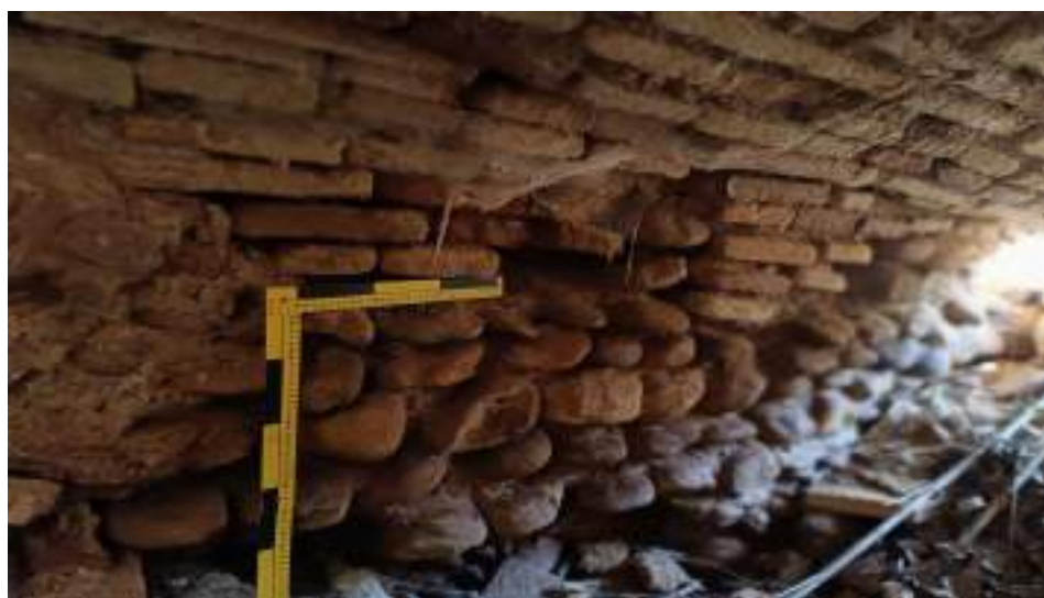
Figura 86, 87 y 88: Distintos elementos integrantes, tanto interiores como exteriores que muestran las particularidades de dicha fábrica. Fuente: foto autor.
