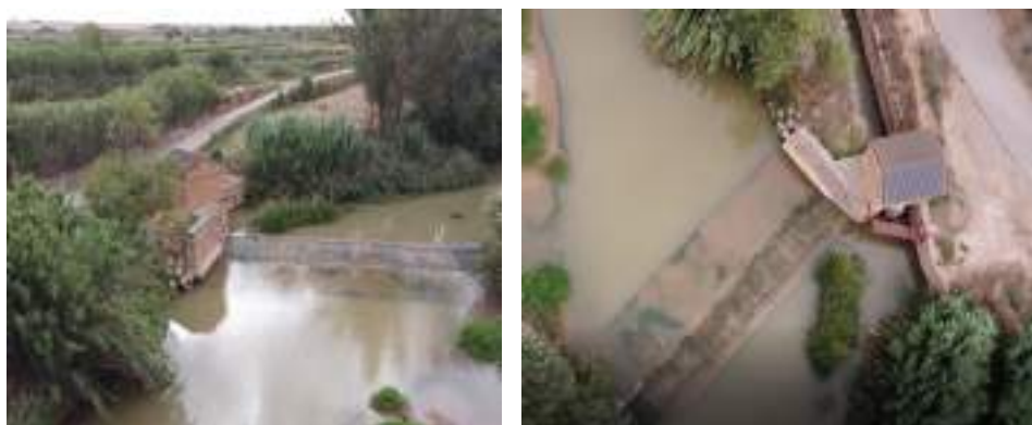
Figura 23 y Figura 24: Vista aérea azud de Losas tomada con un dron DJI Mavic Pro Platinum a un altura de 100 m y distancia focal de 24 mm. Dicho azud se encuentra situado en la localidad de Bárboles y perteneciente a la acequia de Pinseque, Peramán y Alagón. Fuente: Foto autor.
