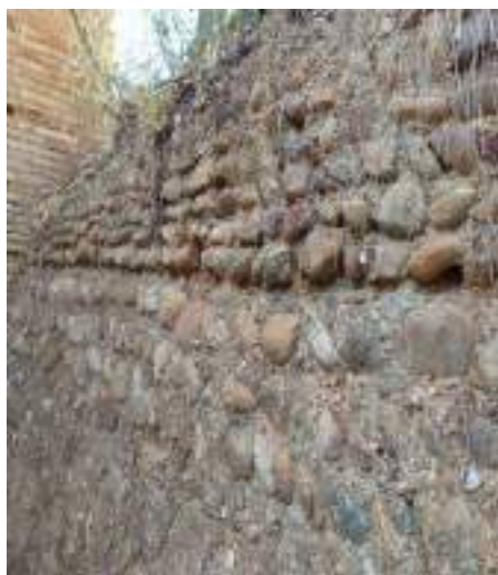
Figura 84 y 85: Detalle de la distinta disposición y diámetro de las pequeñas piedras de las que se componen las paredes de la “garganta”. Fuente: Foto autor.
