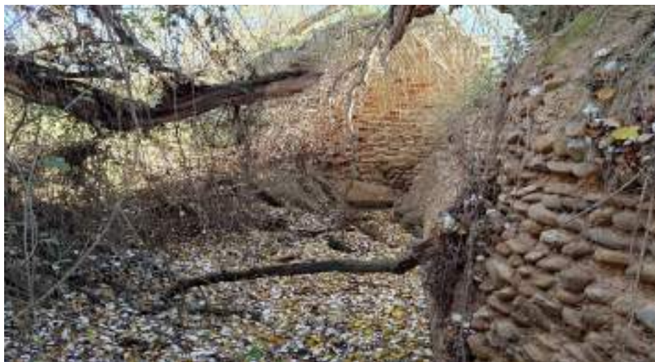
Figura 83. Detalle del canal o “garganta” que procedente del río conduciría las aguas hacia la casa de la almenara. Fuente: Foto autor.
