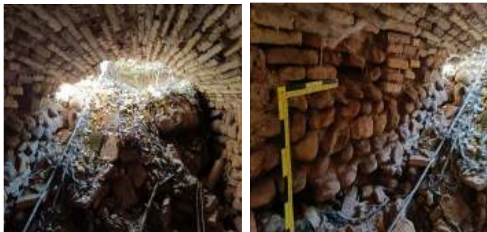
Figura 78 y Figura 79. Tragaderas de forma abovedada. Fuente: Foto autor.
