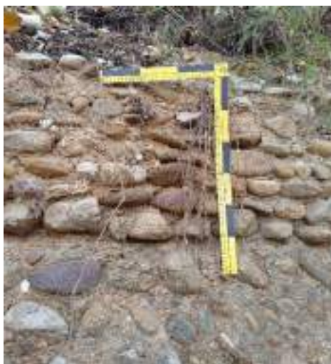
Figura 84 y 85: Detalle de la distinta disposición y diámetro de las pequeñas piedras de las que se componen las paredes de la “garganta”. Fuente: Foto autor.
