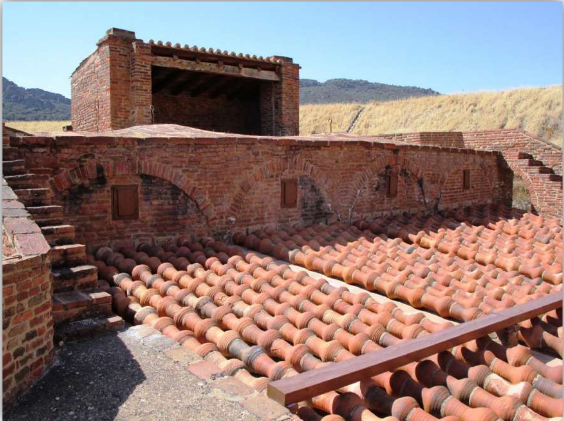
Figura 42. Horno de aludeles en Almadén. Fueron inventados en Huancavelica en 1633 por Lope Saavedra Barba e introducidos y mejorados en la villa almadenense por Juan Alonso de Bustamante en 1646
