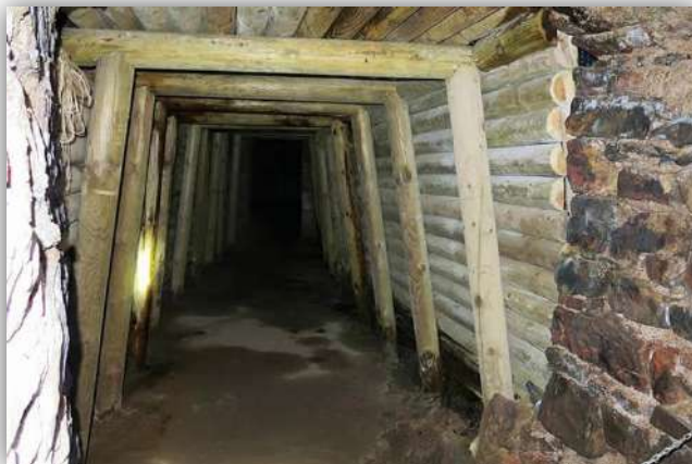
Figura 17. Muro de mampostería y entibación en madera de la mina de Almadén
