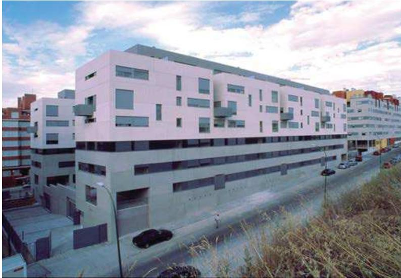
El basamento, planta baja y primera, con paneles prefabricados de hormigón acabados con áridos de machaqueo de gran tamaño; la planta segunda queda retrasada con carpinterías oscuras; el cuerpo central con paneles prefabricados de hormigón claro y árido fino y el ático con paneles metálicos de más luminosidad.
