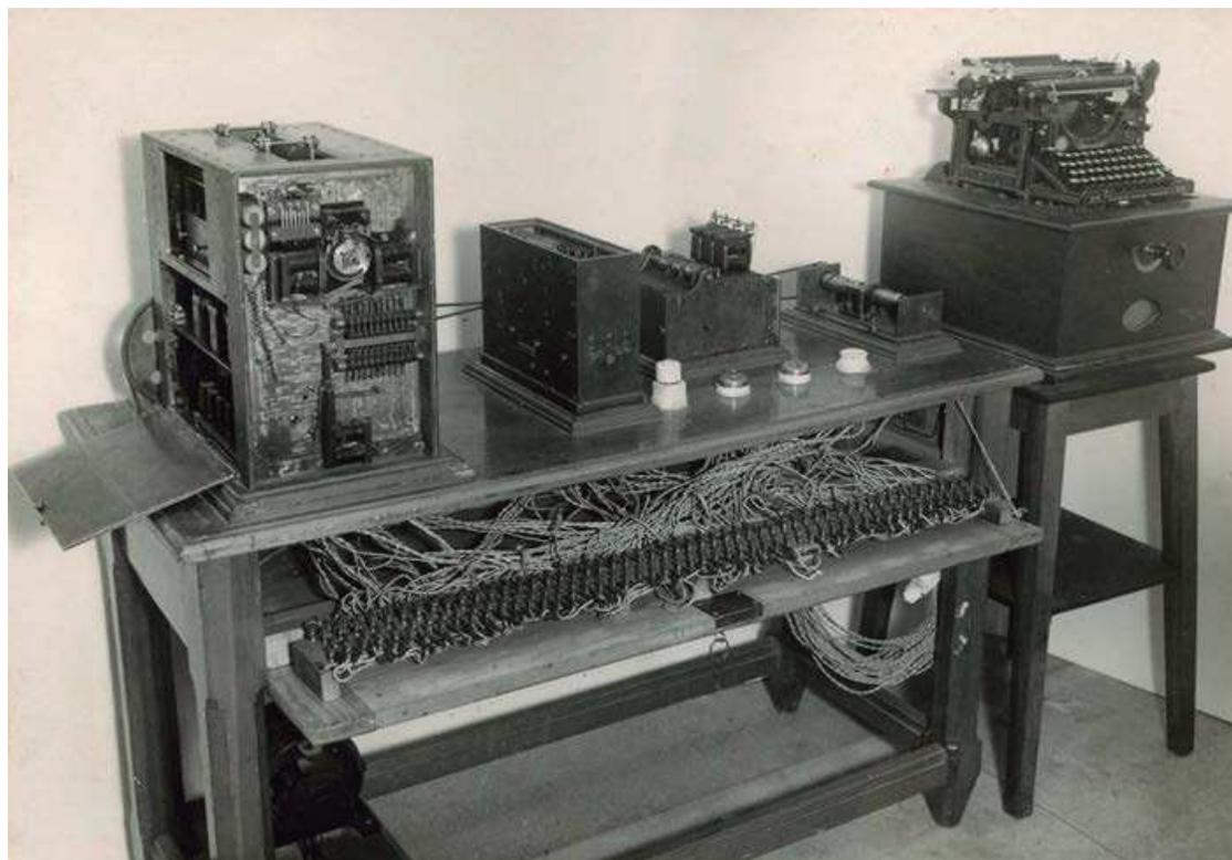
Figura 12: Imagen del *aritmómetro electromecánico*, 1920
