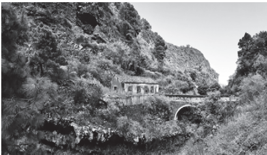
Central Hidroeléctrica Electrón, ca. 1910 [AGP]
