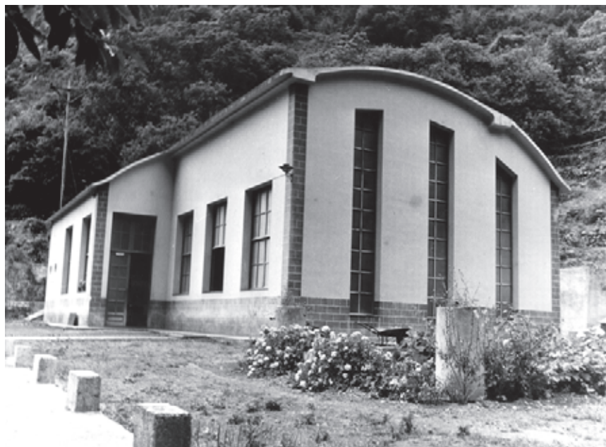
Central Hidroeléctrica Salto del Mulato (San Andrés y Sauces), ca. 1955 [AGP]
