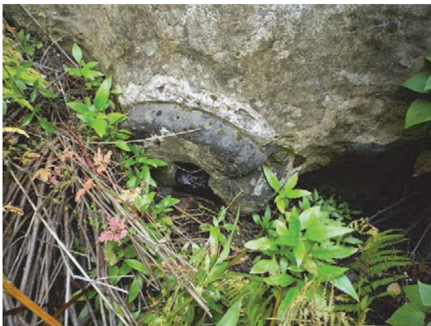
Molino de Pestana con el cubo de sillería y argamasa; detalle del bocín, 2016 [ALT]
