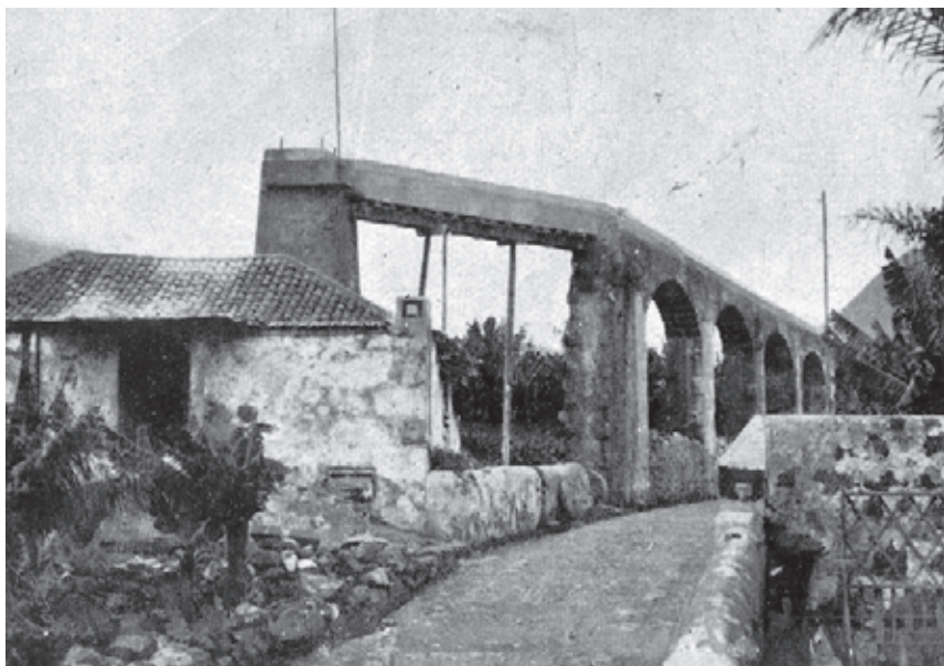
Molino Viejo o de Arriba, hacienda de Argual, con la canalización, cubo y casa molinar, ca. 1920 [BMSCT]
