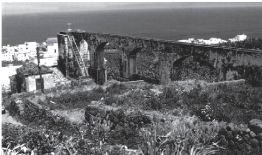
Acueducto y casa molinar de El Regente (San Andrés y Sauces); en 1904 se instaló una central hidroeléctrica en su seno, ca. 1960 [AGP]
