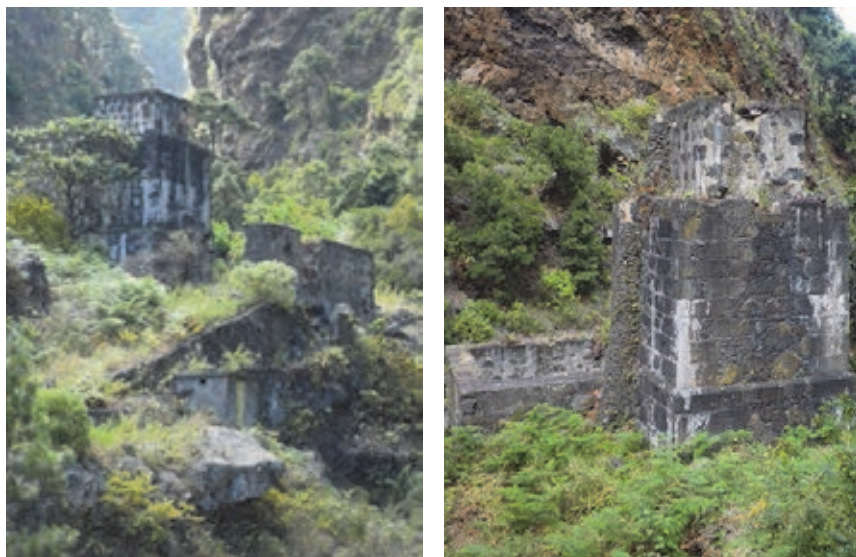
Molino de Álvarez Cordero, más tarde de Monteverde y harinero del Electrón; parte posterior con cubo de sillería y argamasa, 2013 [ALT]
