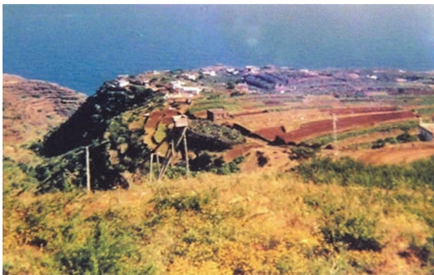
Restos del molino de Gallegos (Barlovento), ca. 1980 [JPC]
