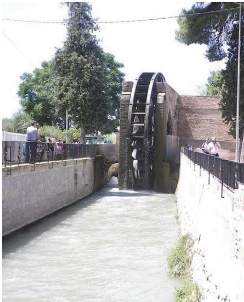
Rueda vertical o aceña de propulsión superior. Huerta de Murcia, 2014 [ALT]
