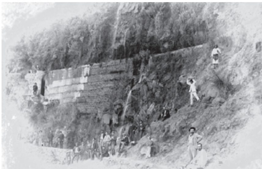
Trabajos de canalización de aguas, La Palma. Fotografía de Rosendo Cutillas, ca. 1895 [AGP, RCH]
