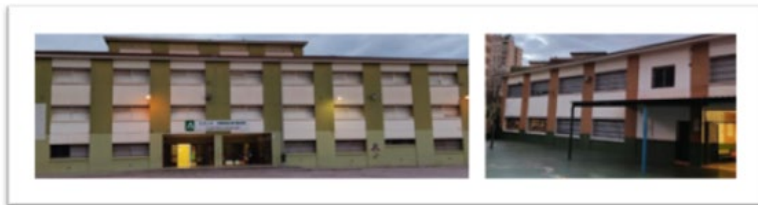
Figura 2: Edificio de Educación Primaria y edificio de Educación Infantil
