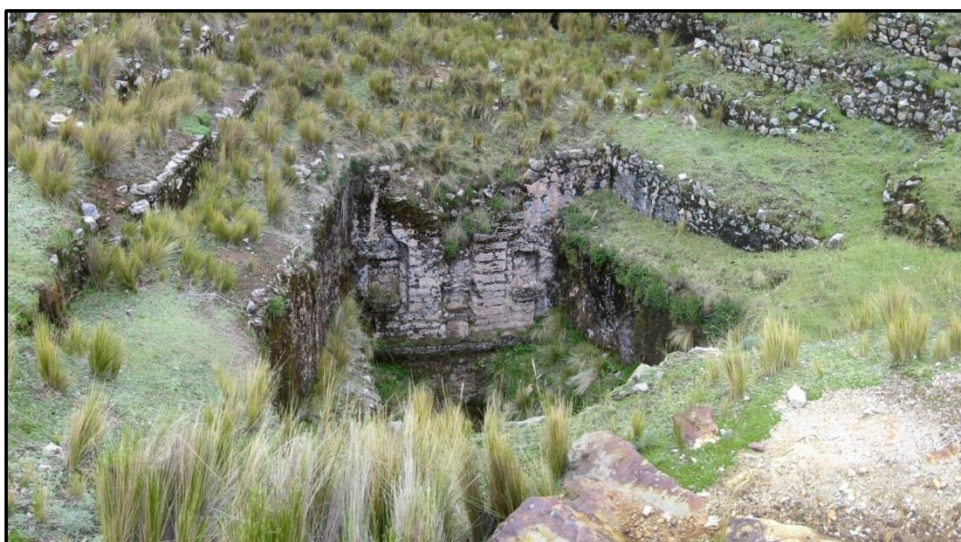
Figura 88. Bocamina del socavón San Javier, parcialmente tapada por un relleno reciente, empleado como galería de desagüe (Fuente: Autores)
