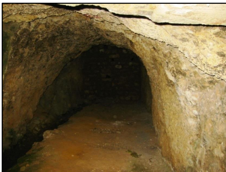
Figura 87. Primeros metros del socavón de N ra Sra. de Belén (Fuente: Autores)
