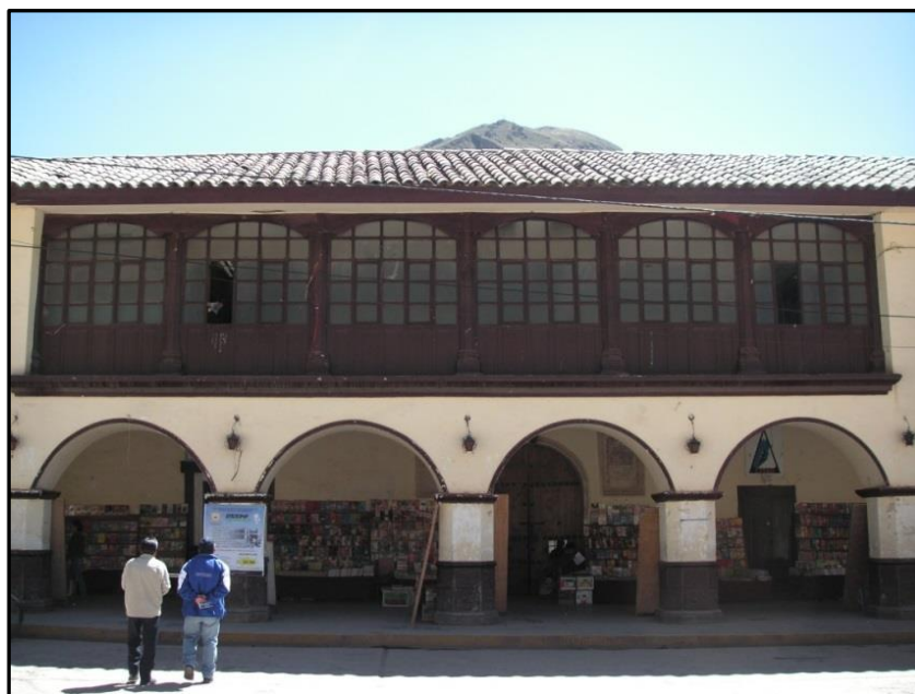
Figura 110. Huancavelica. Antiguo cabildo. (Fuente: Autores)
