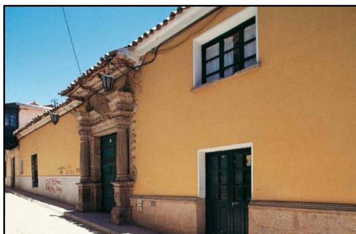
Figura 38. Potosí. Casa de los condes de Carma. Fines siglo XVII (Fuente: Prado y Pozo, 2004) 260
