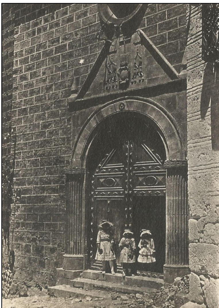
Portada antigua de la iglesia de san Francisco con el frontón partido y un óculo por encima. 1917. Fotografía Enrique Mackay.
