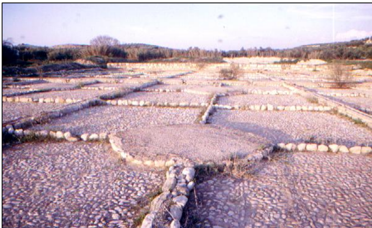
Salina de Peal de Becerro. Albercas de decantación de sal. 2001. (destruidas en la actualidad) Foto José María Crespo
