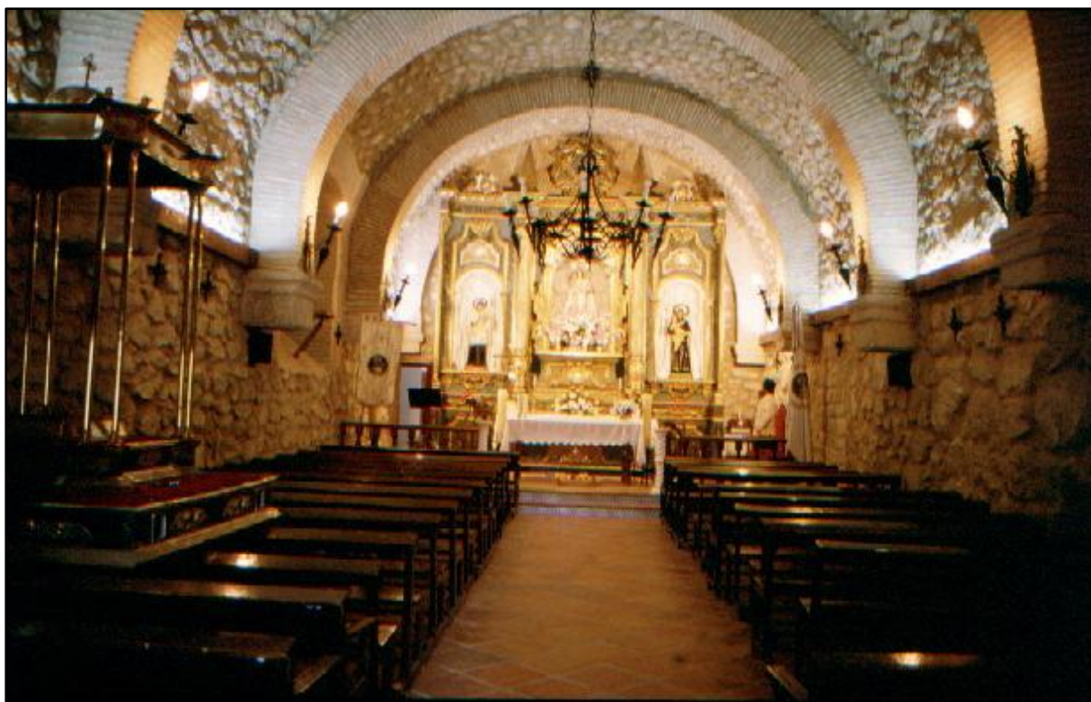
Interior de la nave de la ermita de la Virgen de la Cabeza. Detalle de los arcos fajones que sostienen la bóveda semicircular. Fotografía José María Crespo García. 1998
