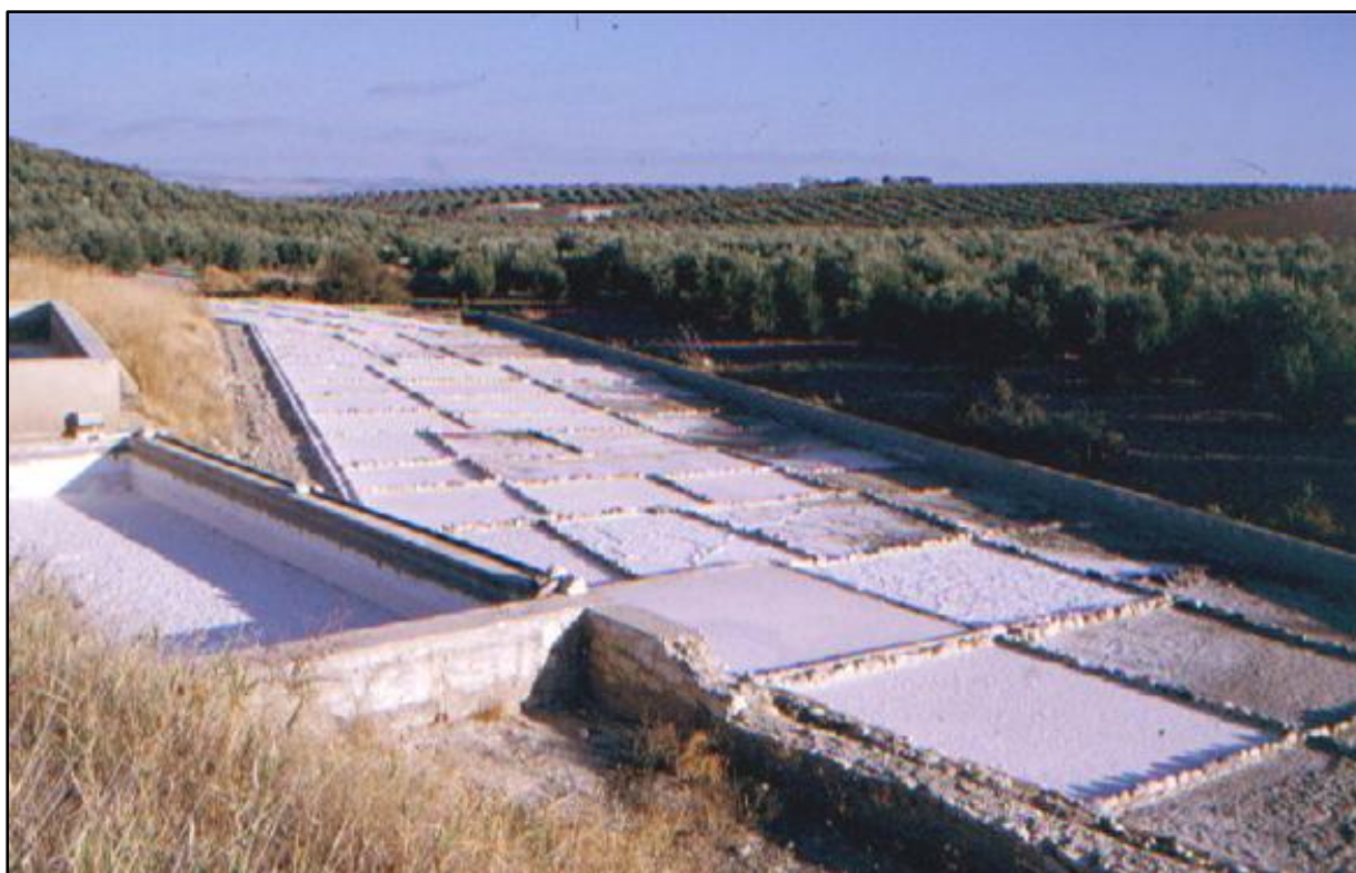
Salina de Dos Hermanas. Paraje de Los Nerios. Albercas de decantación de sal y de almacenaje de agua. 2001. Foto José María Crespo García.
