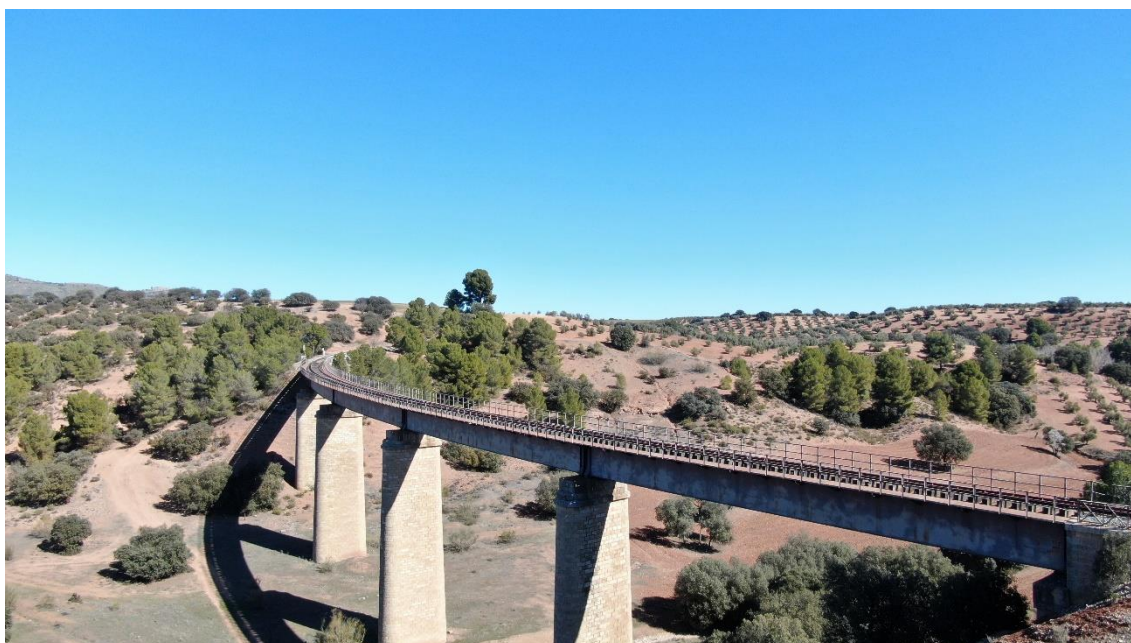
83. Vista aérea del viaducto en curva.
