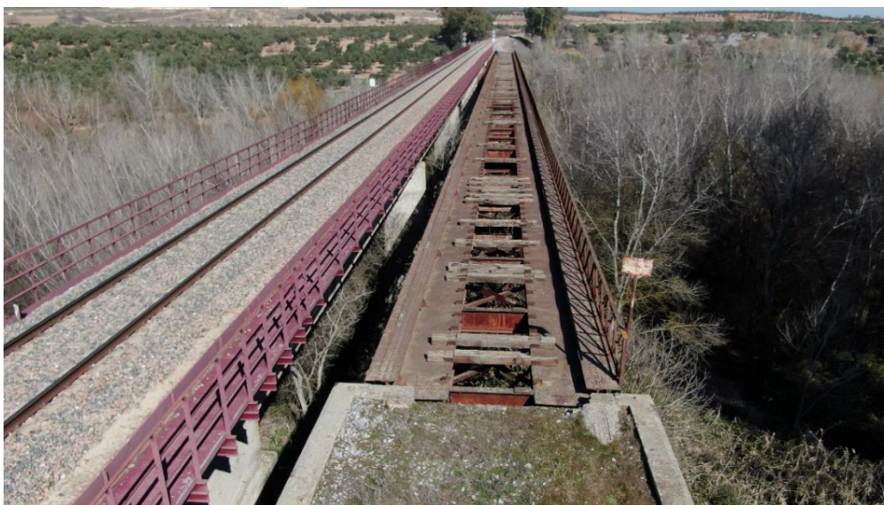
12. Vista plataformas viaducto de hormigón (actual) y metálico (primitivo).
