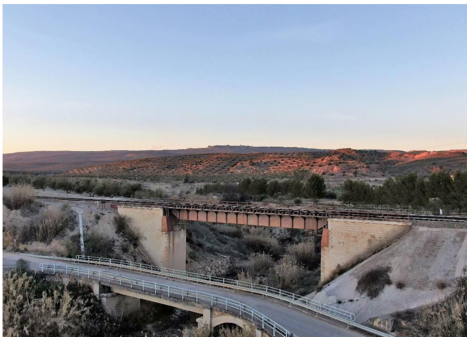
29. Vista aérea puente sobre arroyo Bedmar.
