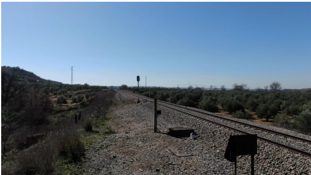
08. Salida del viaducto dirección Almería.
