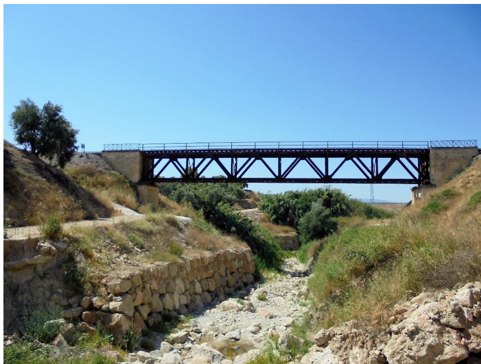
14. Puente arroyo Matadero.
