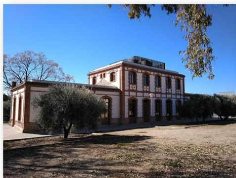
Vista de la fachada posterior de la Estación de Almería (Linares)
