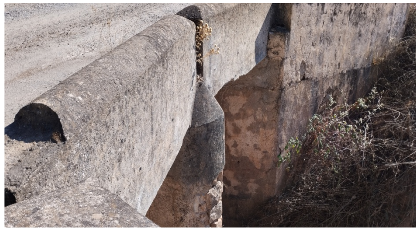
Detalle del puente, realizado en mampostería con revestimiento de cemento
