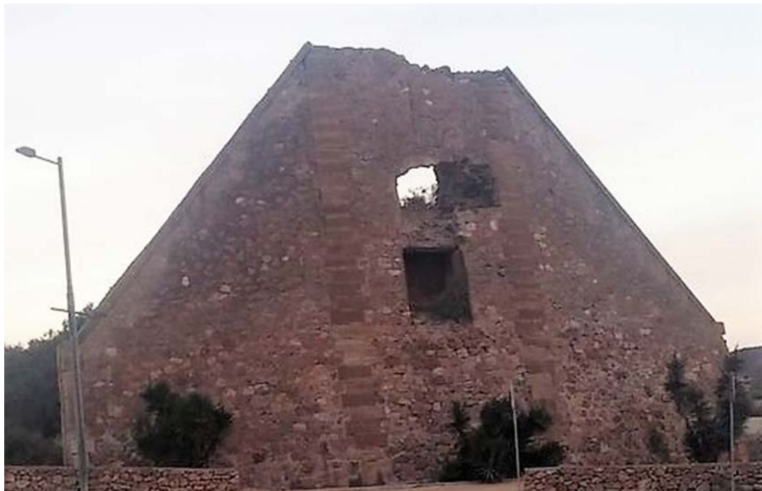
Cargadero de mineral en Garrucha
