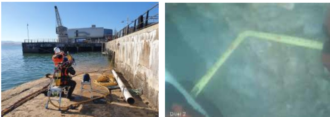
Figura 27: Preparación de los buzos y actuaciones subacuáticas en la reparación de los pilares del Muelle de Maura [8].
