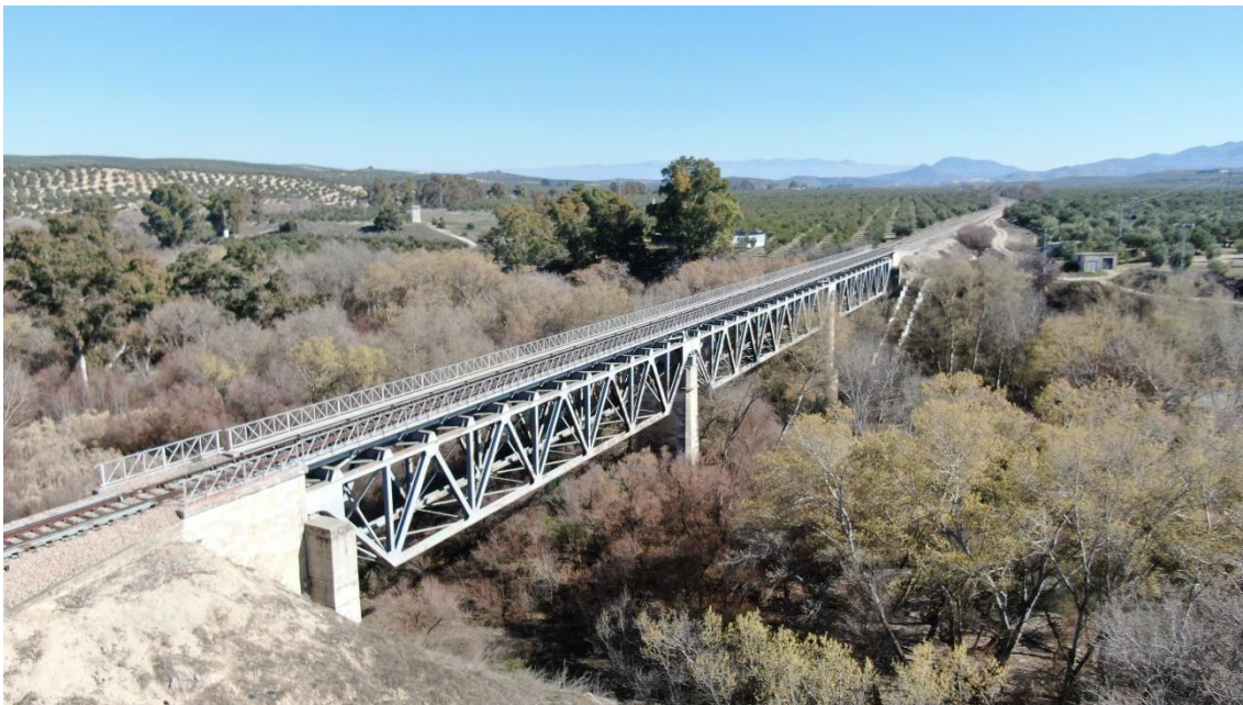
26. Vista aérea viaducto sobre el río Guadalquivir.
