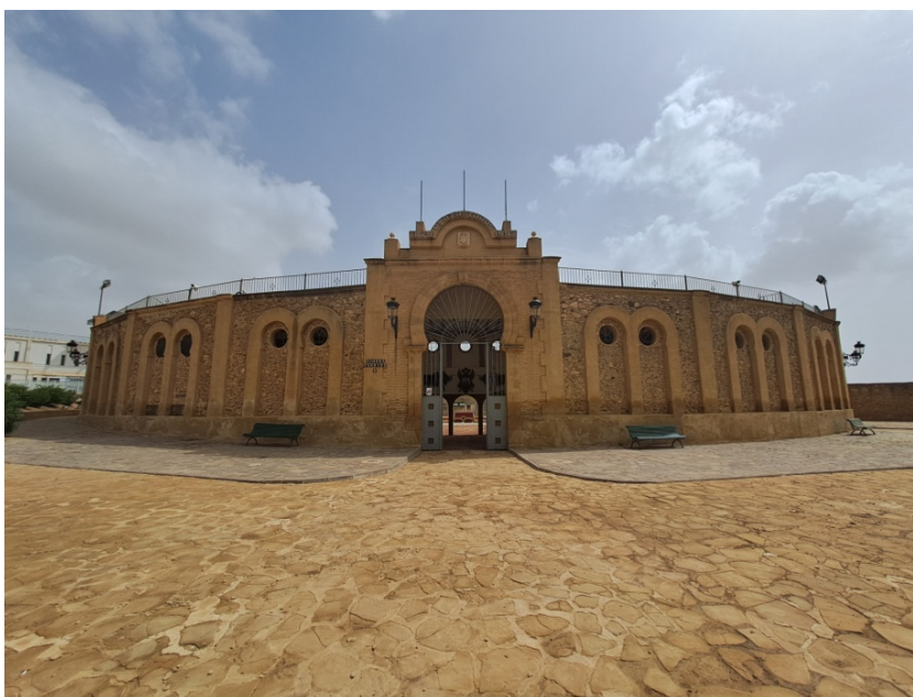
Fachada principal de la Plaza de Toros
