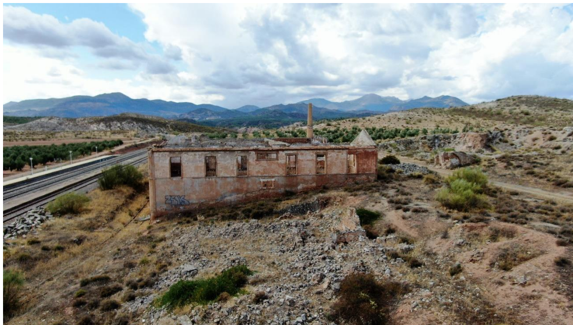
60. Ruinas del complejo industrial anexo a la estación.
