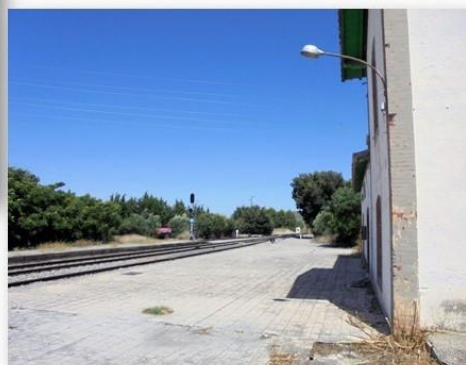
Vista del andén y vías dirección estación Linares-Baeza.
