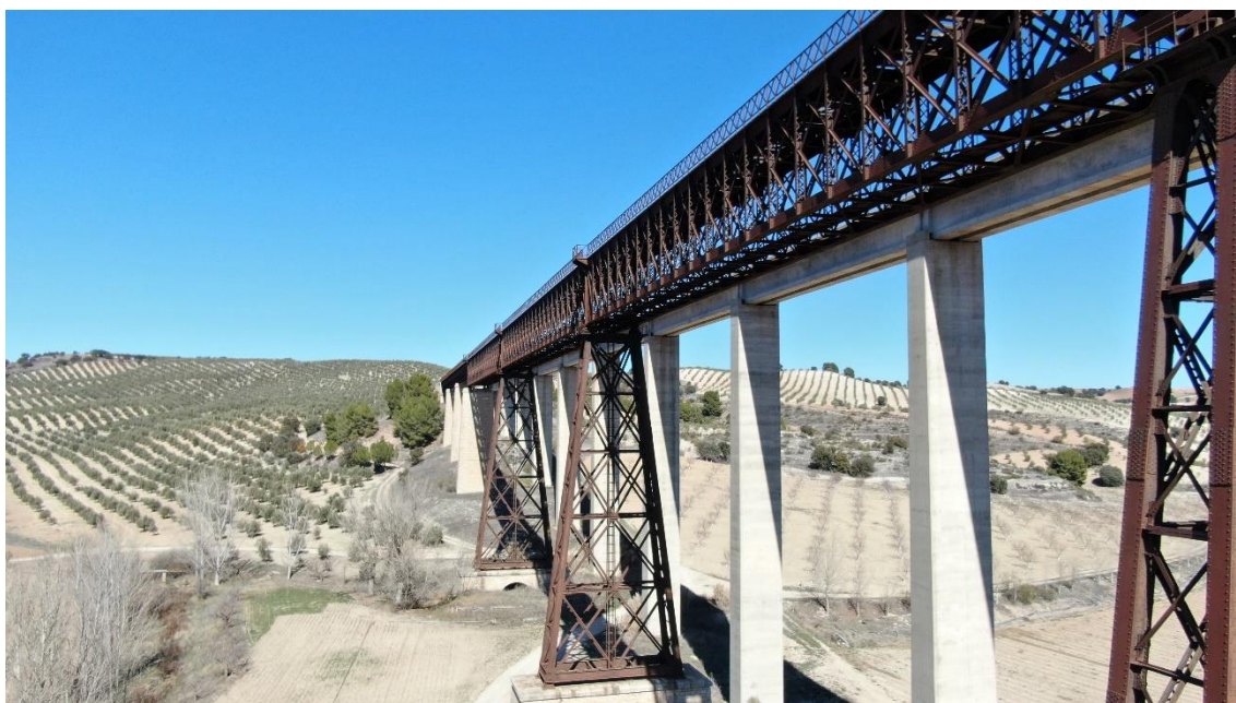
89. Vista aérea del puente aguas arriba lado Linares.
