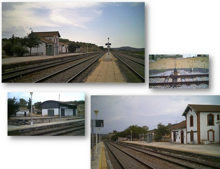
35. Andén y edificios anexos a la estación: almacenes, viviendas.
