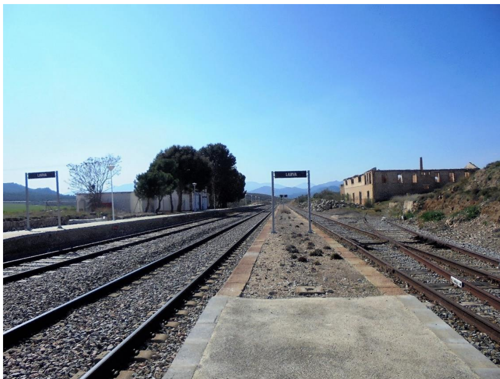
63. Vista vías de circulación dirección Almería.
