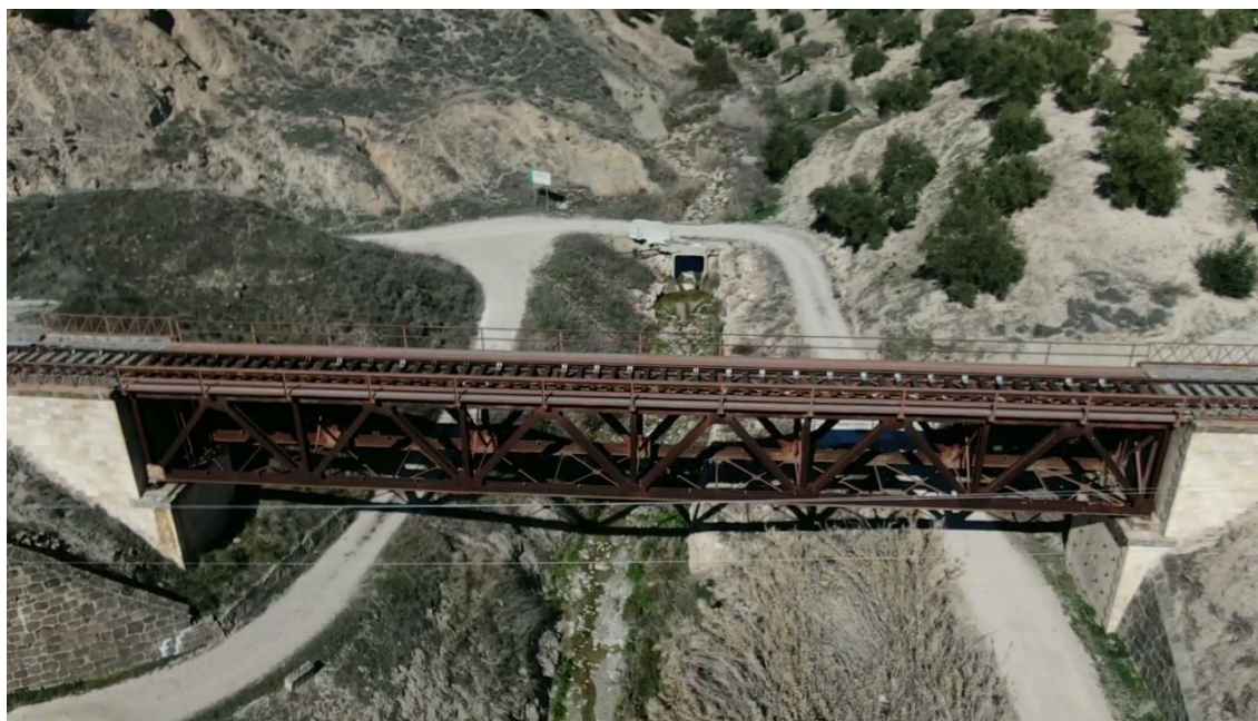
21. Vista aérea puente ffcc sobre arroyo Matadero.
