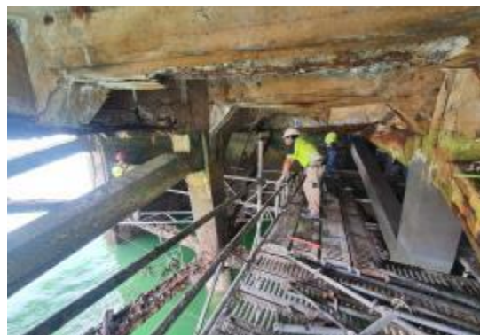
Figura 26: Trabajos de reparación del muelle en su interior [8].
