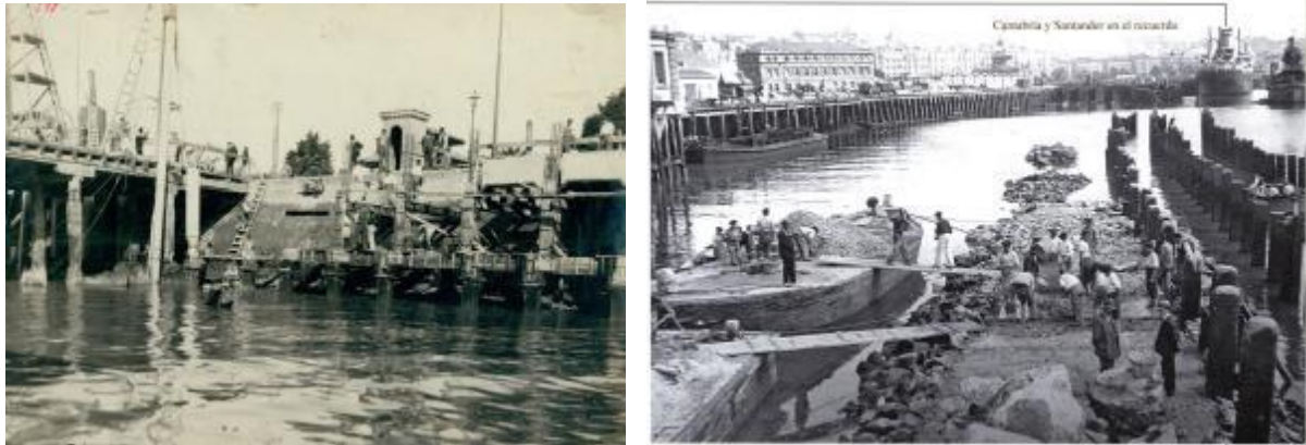
Figura 14: Trabajos de reconstrucción del Muelle de Maura [13 -izquierda- y 11]. Circa 1940.
