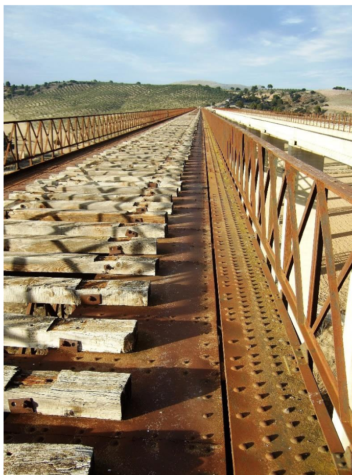
94. Vista del piso del viaducto sobre la viga principal.
