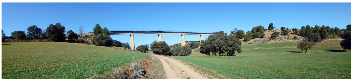
80. Panorámica del viaducto 'aguas abajo' Barranco Ocaña.
