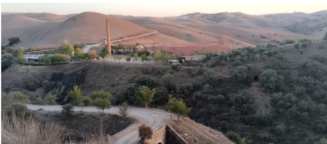
Paso elevado del camino del Sinapismo (12) sobre la línea del fcc de La Carolina a Puertollano
