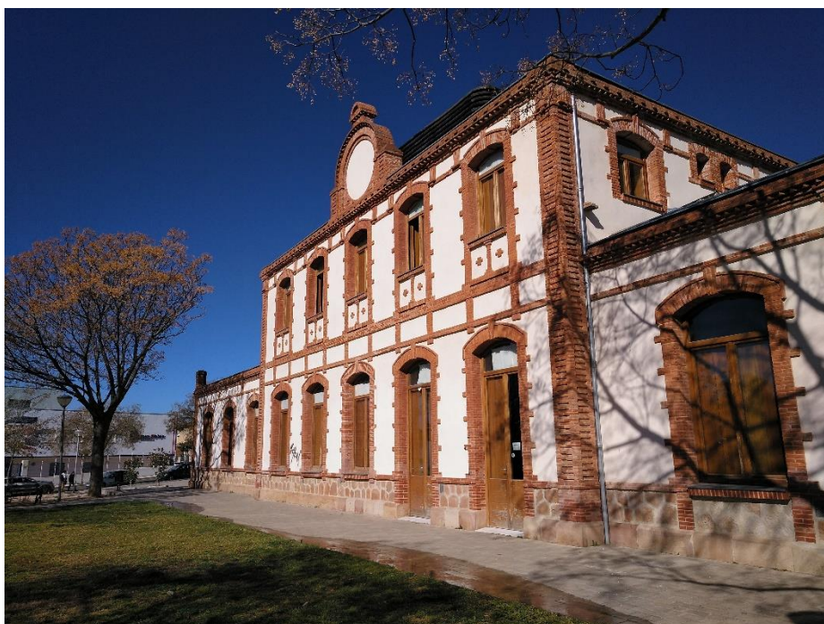
05. Fachada principal de la estación de Almería en el barrio de San José en Linares.
