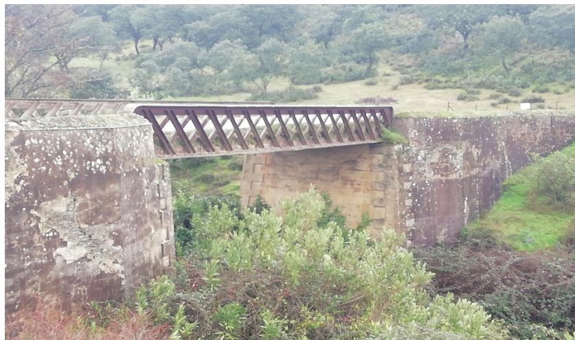
Puente de hierro sobre el arroyo de la Campana en el camino de la Mina de La Española (9) y Pozo Federico (10)
