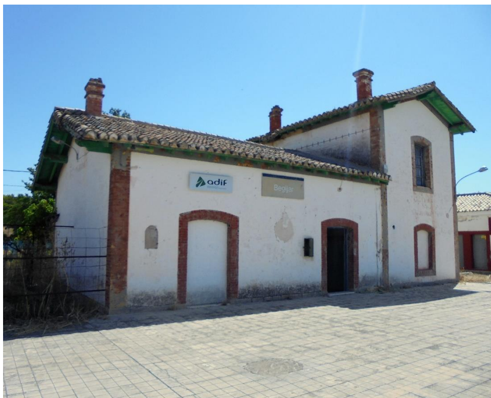
18. Edificio principal de la estación (abandonado)
