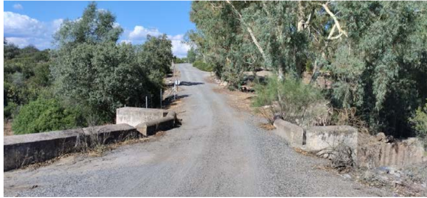
Puente sobre el arroyo Matababras en el camino de la mina San Juan de Adaro (23)
