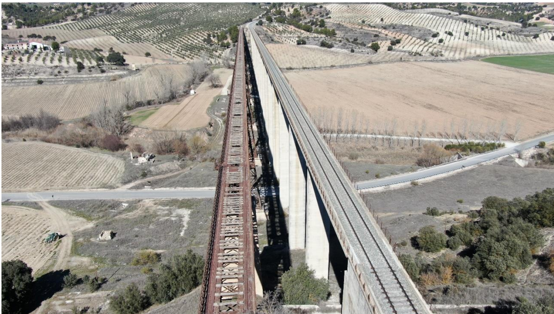
95. Vista aérea del puente viejo y del nuevo de hormigón.
