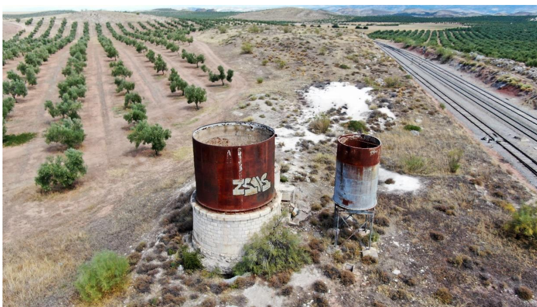
61. Antiguos depósitos de suministro de agua a la estación y al complejo industrial.
