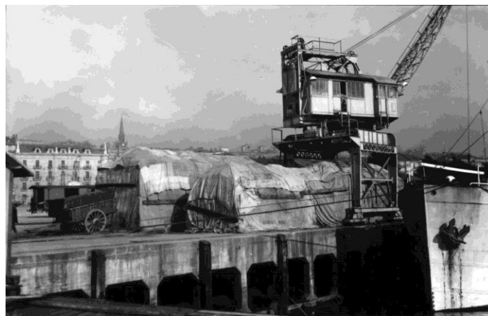
Figura 17: Grúa móvil sobre los cantiles del Muelle de Maura [13]. Circa 1955.
