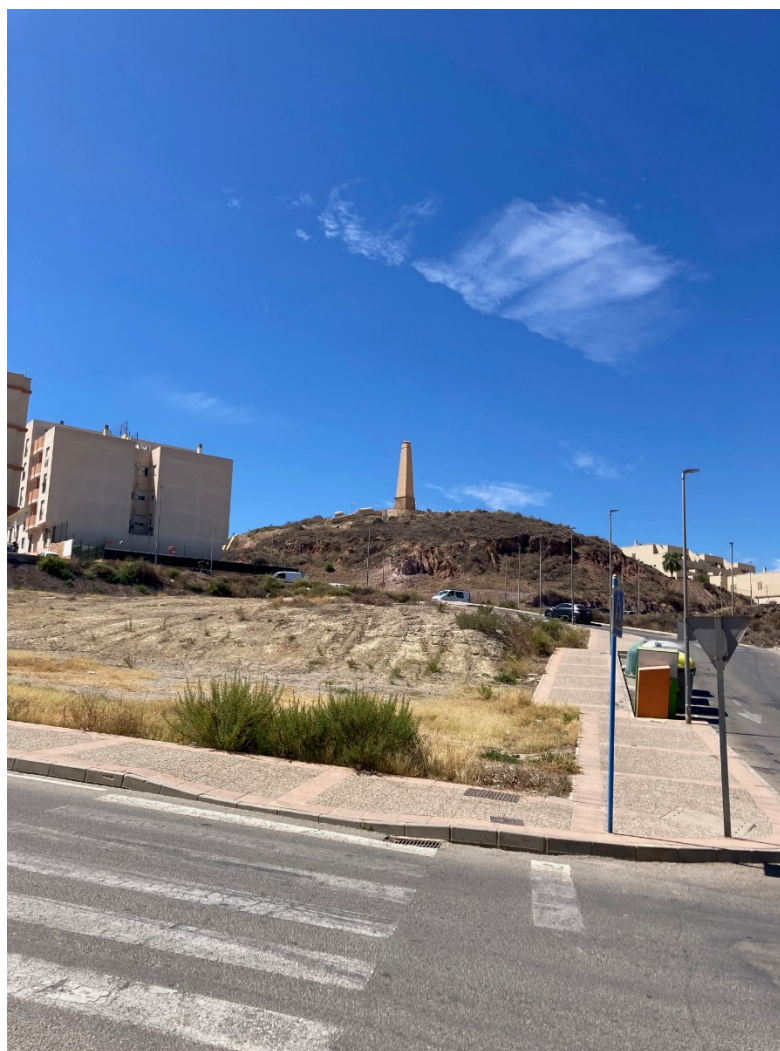
"El Calvario". Chimenea de la Antigua fundición San Ramón
