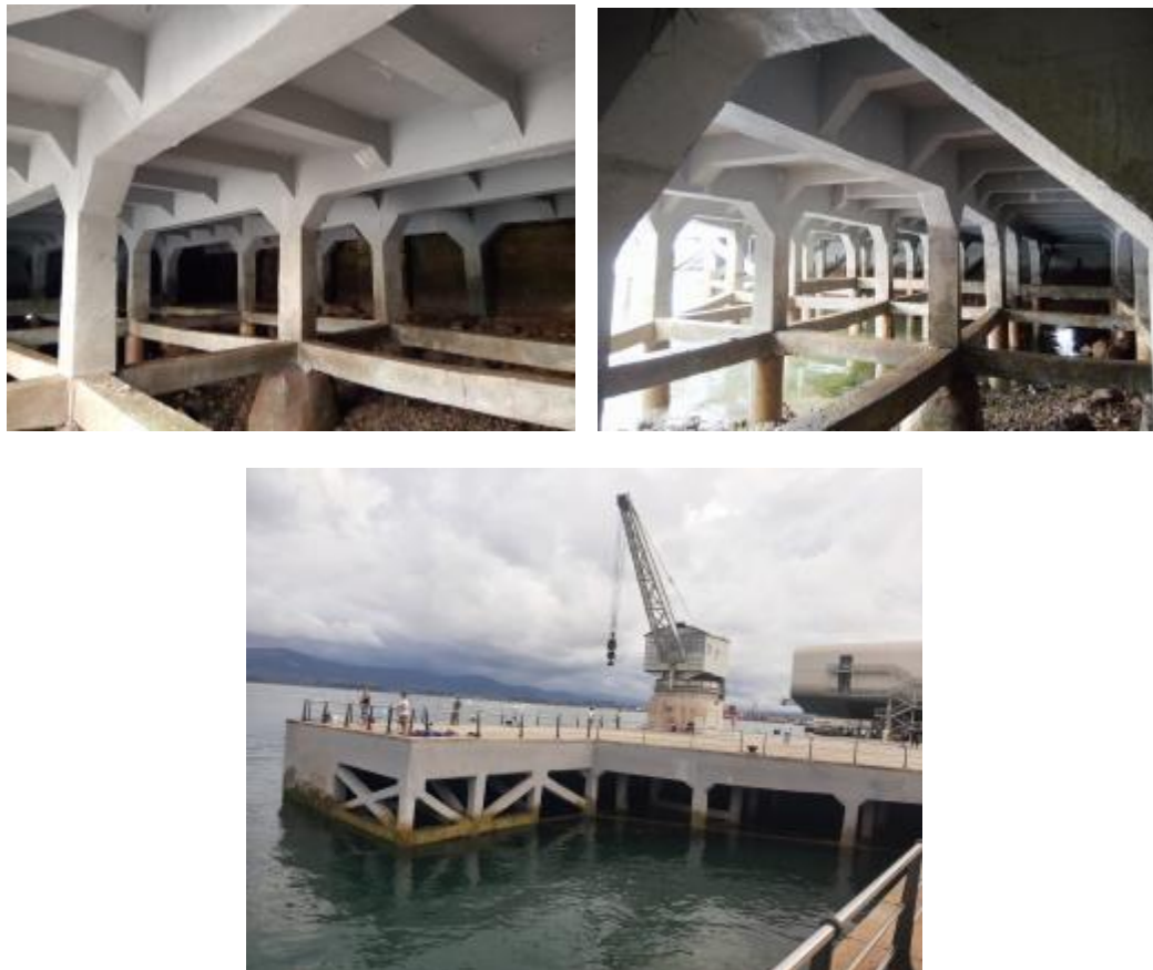
Figura 29: Diversas vistas del Muelle de Maura una vez restaurado, tras la finalización de las obras (Fotografías de [8] y del autor).
