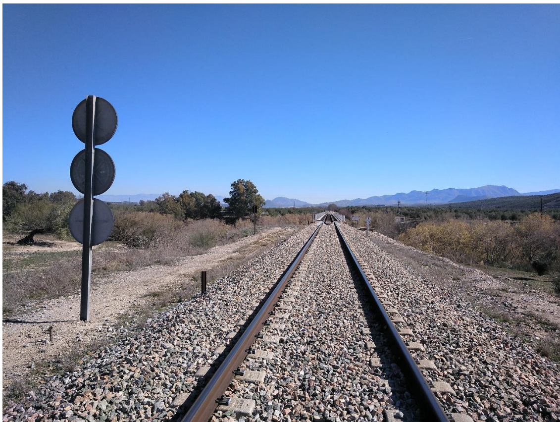
28. Entrada al viaducto, al fondo PN de Cazorla, Segura, Las Villas.
