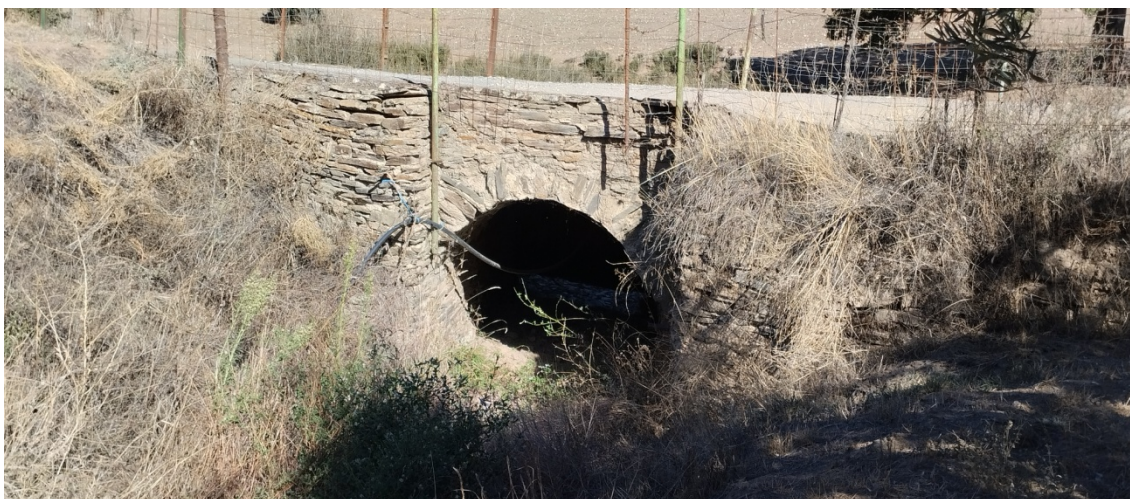
Puente sobre un arroyo en el Camino a la mina de Araceli (16)
