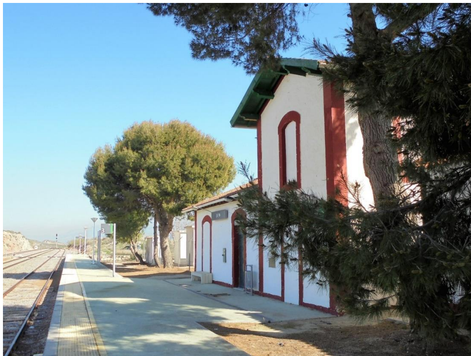
62. Edificio estación de viajeros fachada al andén principal.
