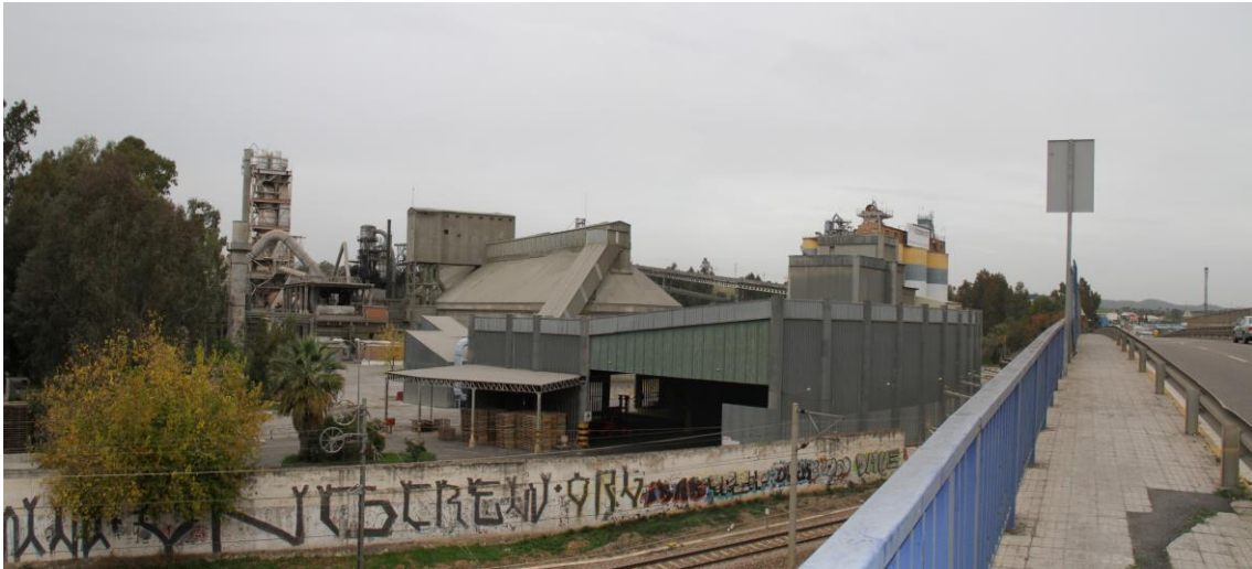
Vista general de la cementera Cosmos (Foto: J. Padilla)
