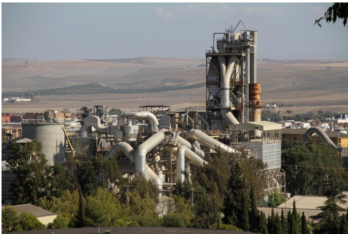
Cementera Cosmos de Córdoba (Foto: J. Padilla, 26/06/2015)
