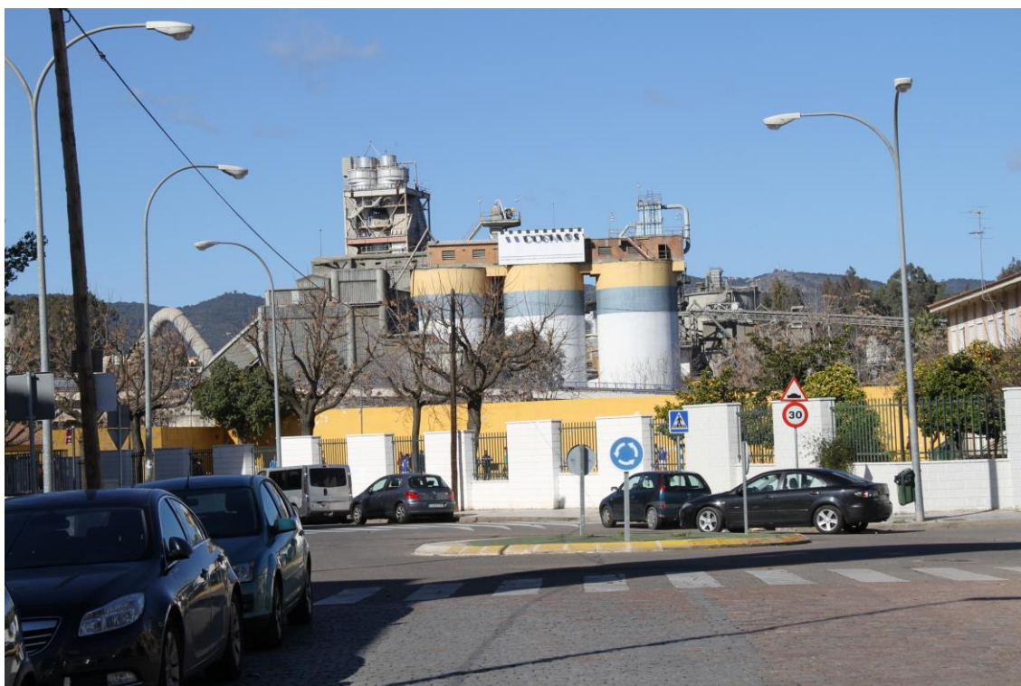
Patio de recreo del CEP concepción Arenal, de fondo la cementera Cosmos (Foto: J. Padilla, 01/02/2015)
