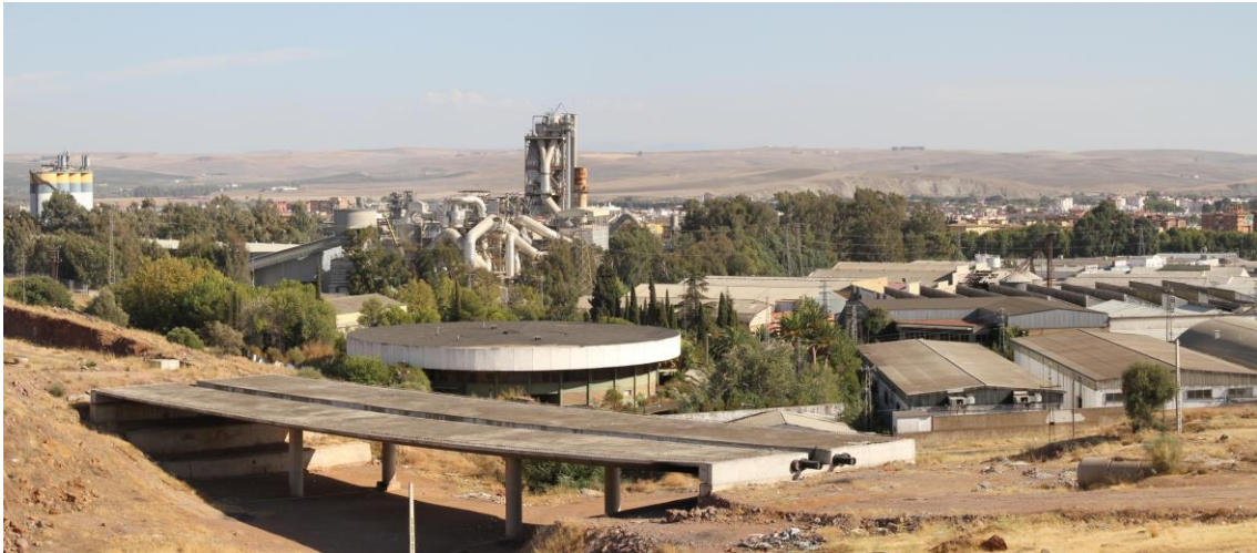
Vista general de la cementera y polígono de Chinales (Foto: J. Padilla, 19/09/2012)
