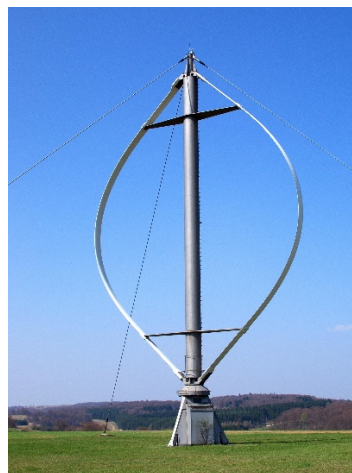
Figura 6. Turbina Dorier Darrieus 55, ubicada en Alemania con una capacidad de generación de 55kW [20]
