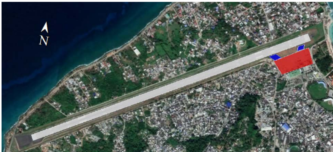
Figura 4. Esquema parte aeronáutica del Aeropuerto: en blanco pista, en azul calles de rodaje y rojo plataforma [30]
