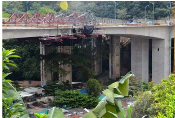
Figura 4. Construcción dovela centro de luz viaducto la unión [5]
