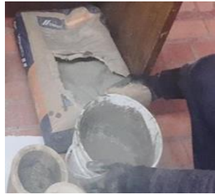
Figura 6. Realización de la mezcla
