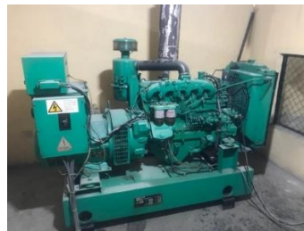
Figura 3. Planta eléctrica del edificio
